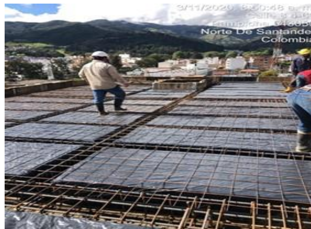
Ilustración N°27 Evidencia casetones y malla electrosoldada placa séptimo.
