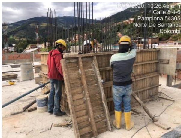
Ilustración N°31 Estructura y encofrado ascensor.
