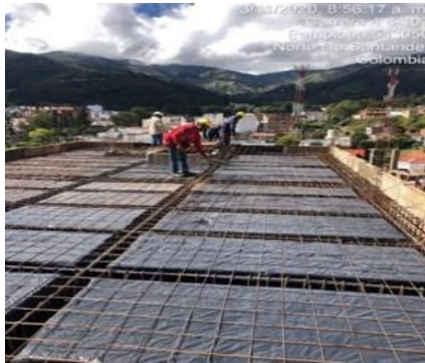
Ilustración N°28 Amarre malla electrosoldada y acero.
