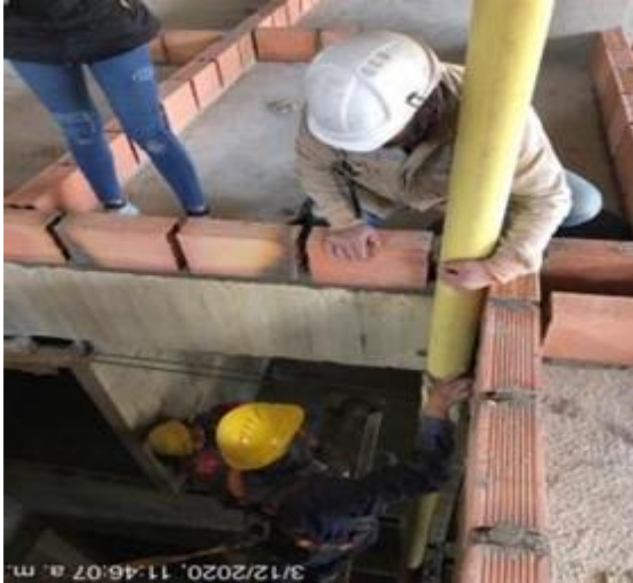
Ilustración N°42 Instalación de bajantes sanitarios.
