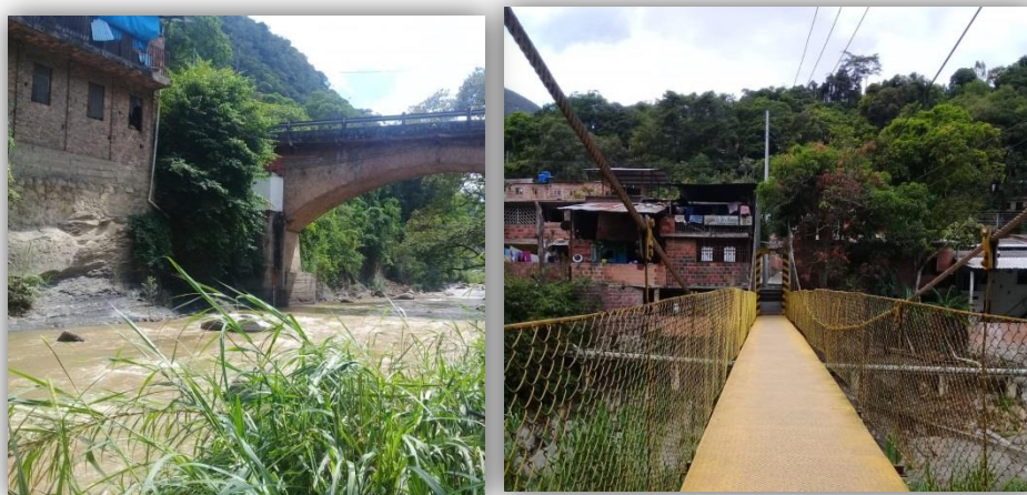
Figura 31. Construcciones y vertimientos al lado del cauce.
