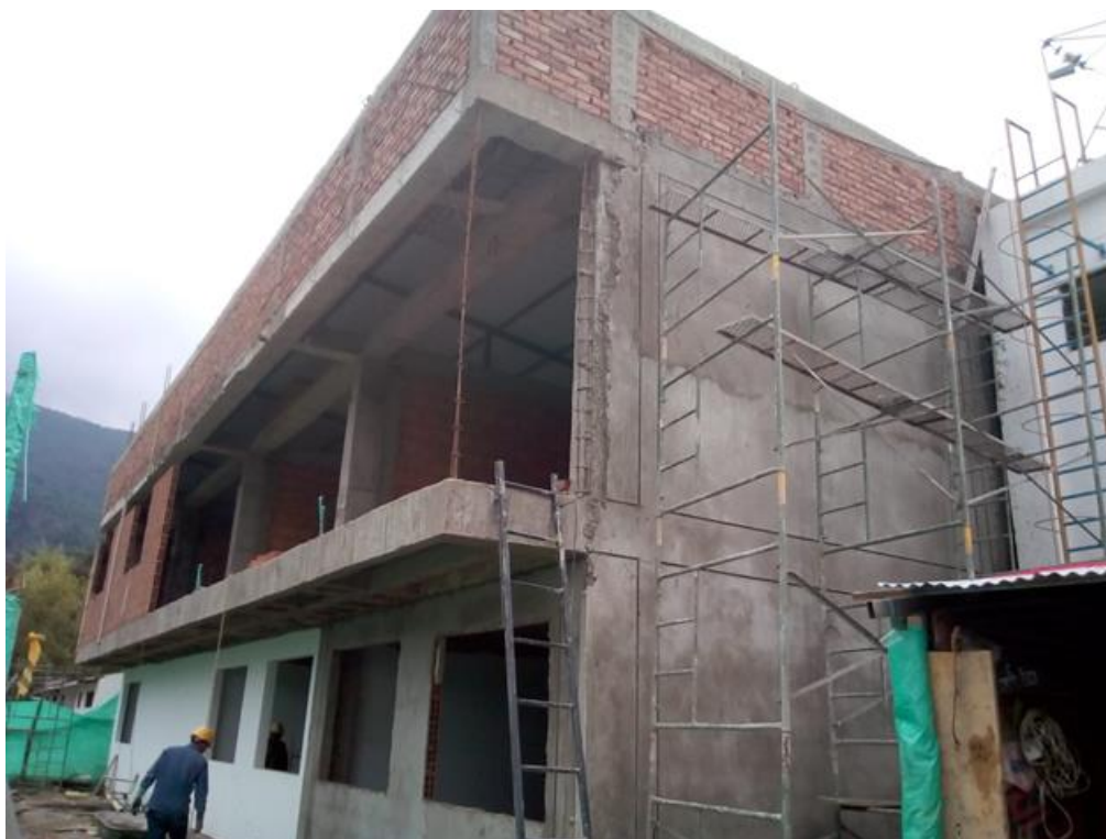
Figura 46. Avance en muros de exterior Obra Nuevas Tecnologías.
