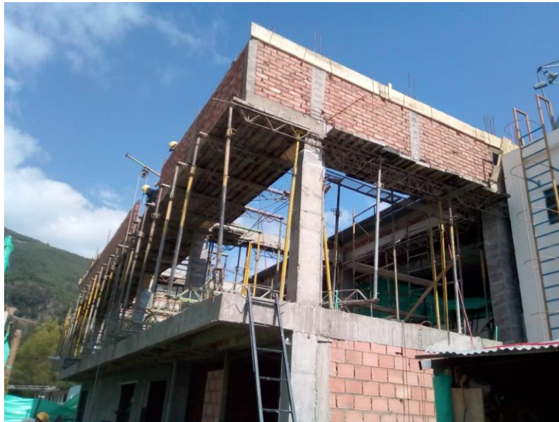
Figura 43. Estructura Segunda Planta de obra BLOQUE NUEVAS TECNOLOGÍAS.
