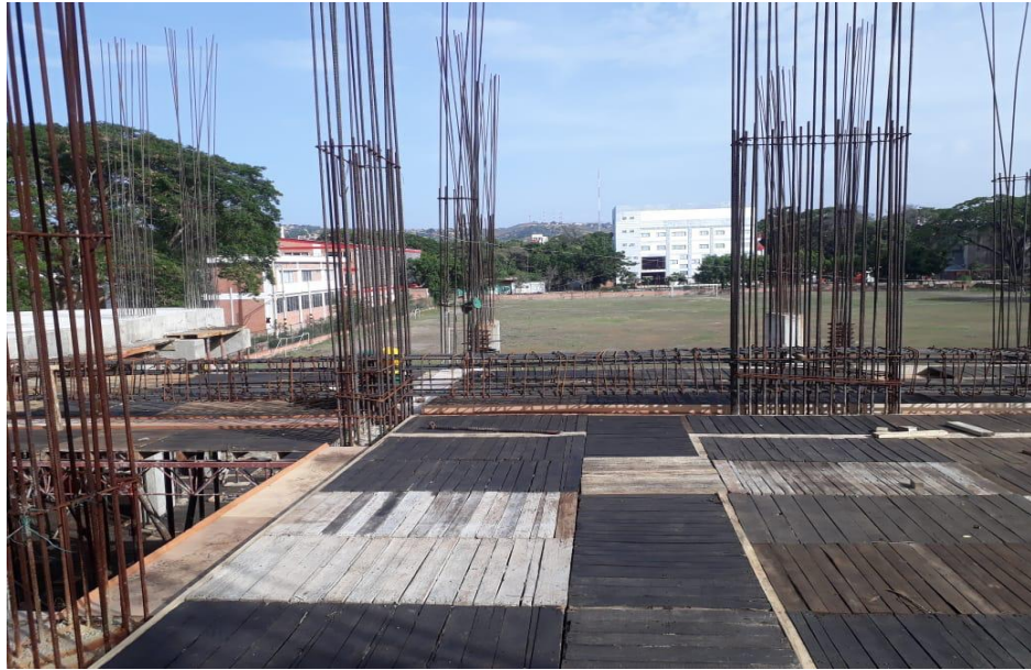
Ver Figura 18. Acero de Columnas Cuadradas.
