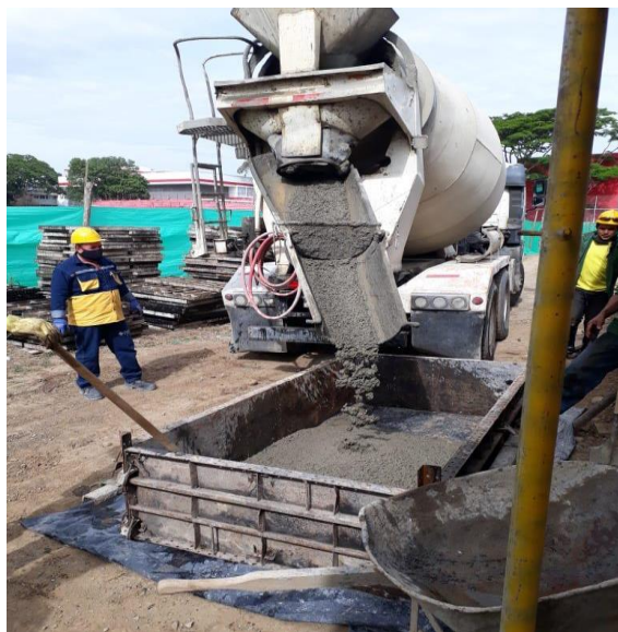
Figura 24. Vaciado de mezcla para transporte manual. Fuente: Propia.
