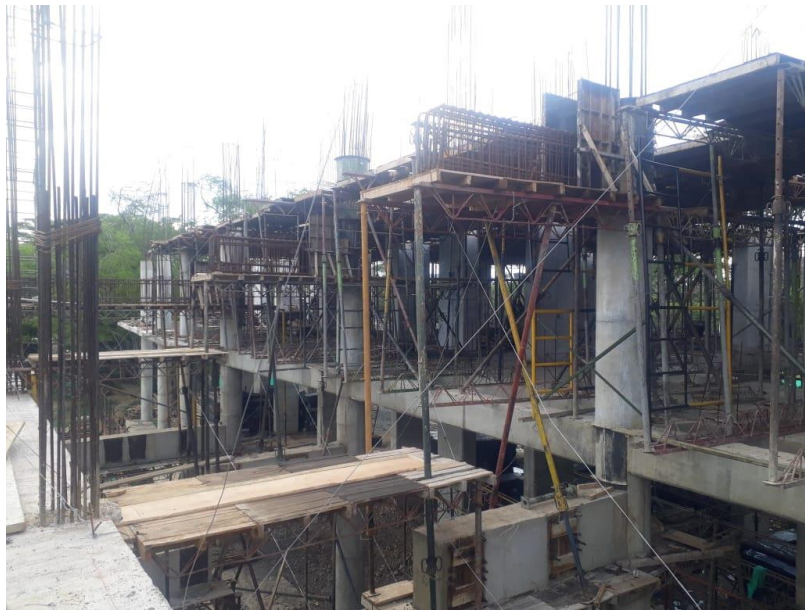
Figura 41. Formaleta sobre segunda Placa Aligerada.
