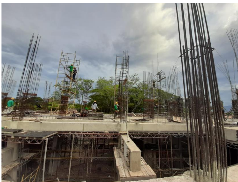
Figura 27. Armado de Acero Segunda Planta.
