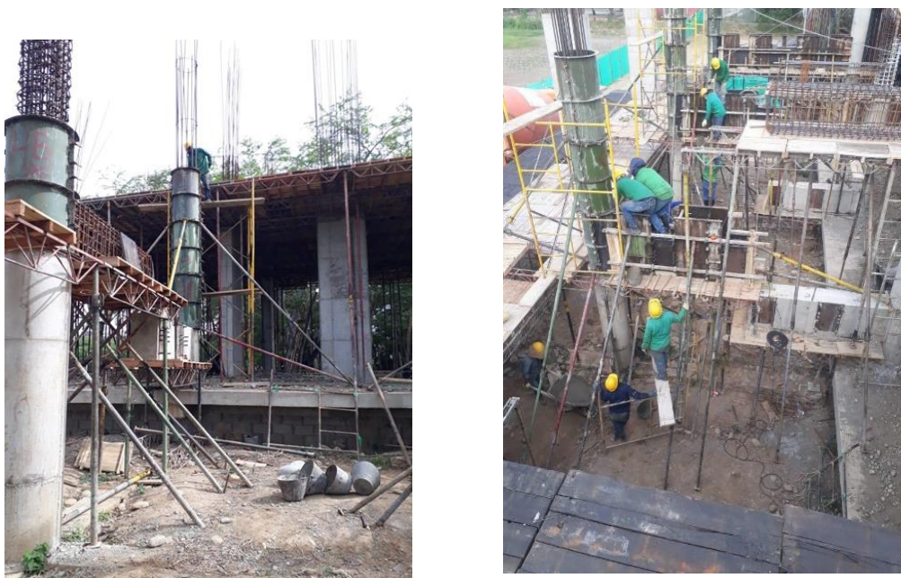
Figura 39. Visualización de formaletas en columnas redondas. Fuente: Propia.
