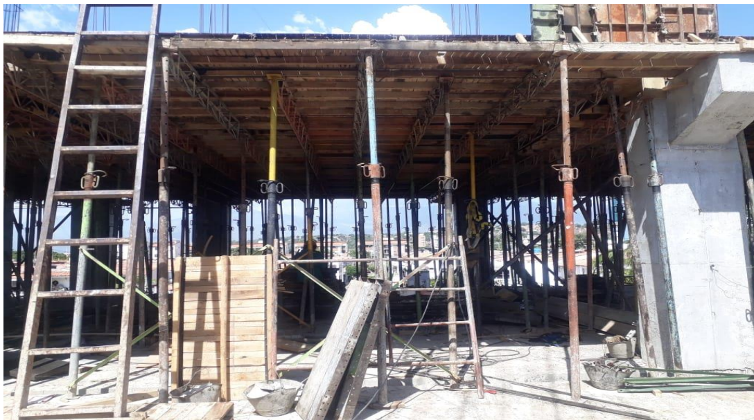
Imagen 16. Formaleta sobre la segunda Placa Aligerada.
