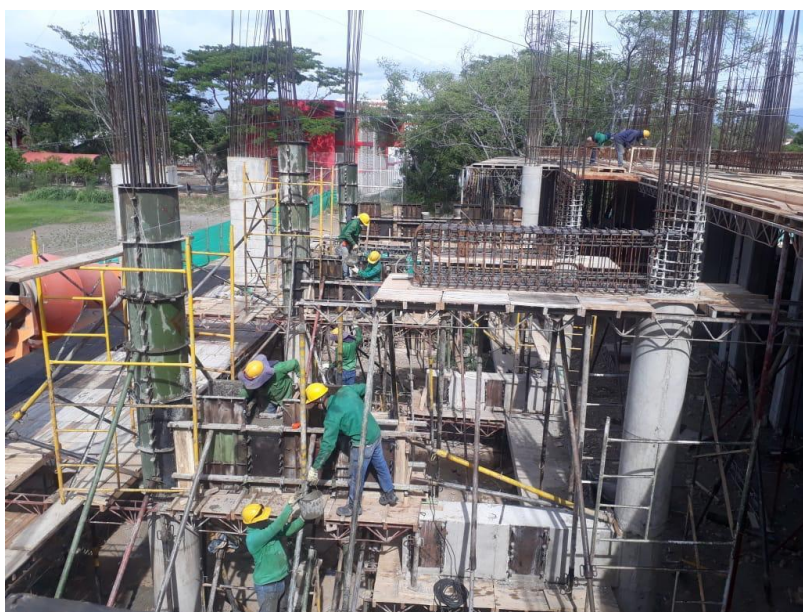
Figura 25. Armado de Acero para segunda planta.
