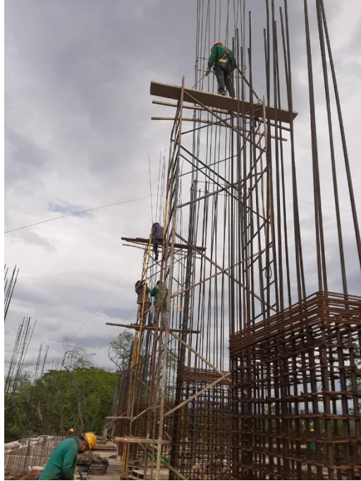
Figura 26. Armado de Acero para Columnas de Segunda Planta
