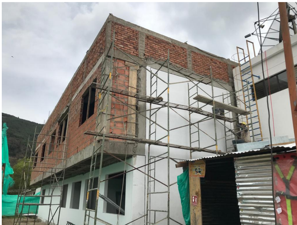
Figura 47. Fachada en ladrillo terminada Obra Nuevas Tecnologías.
