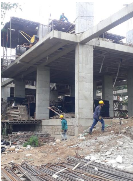
Ver Figura 29. Vista lateral de Columnas Cuadradas.
