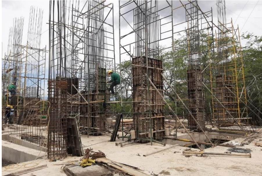
Figura 21. Columnas Cuadradas. Fuente: Propia.
