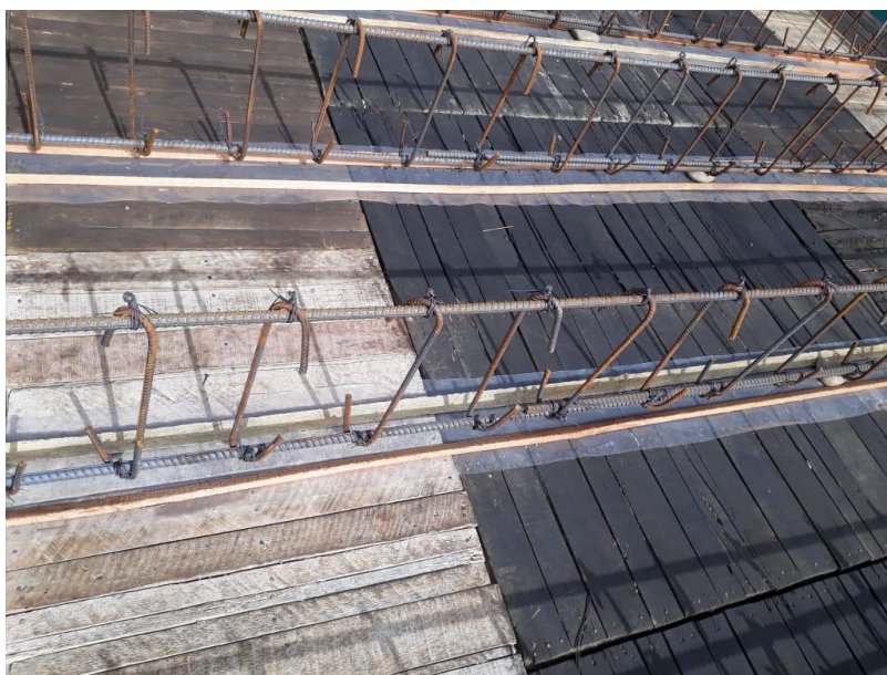
Figura 13. Detalle de Acero
