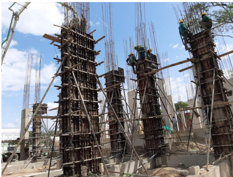
Figura 38. Encofrado de columnas. Fuente Propia.
