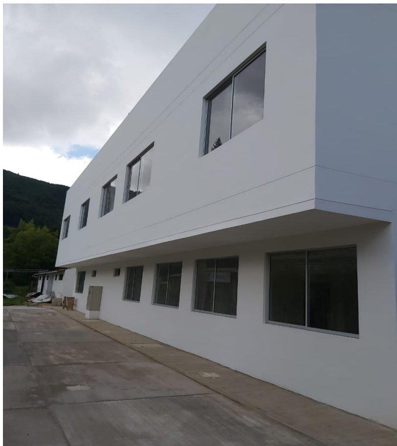
Figura 48. Obra Nuevas Tecnologías Culminada.
