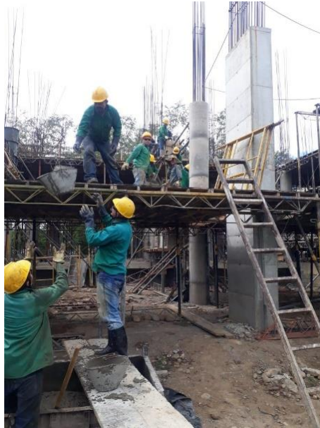
Figura 40. Visualización de formaleta de doble mesa para columnas y placa.
