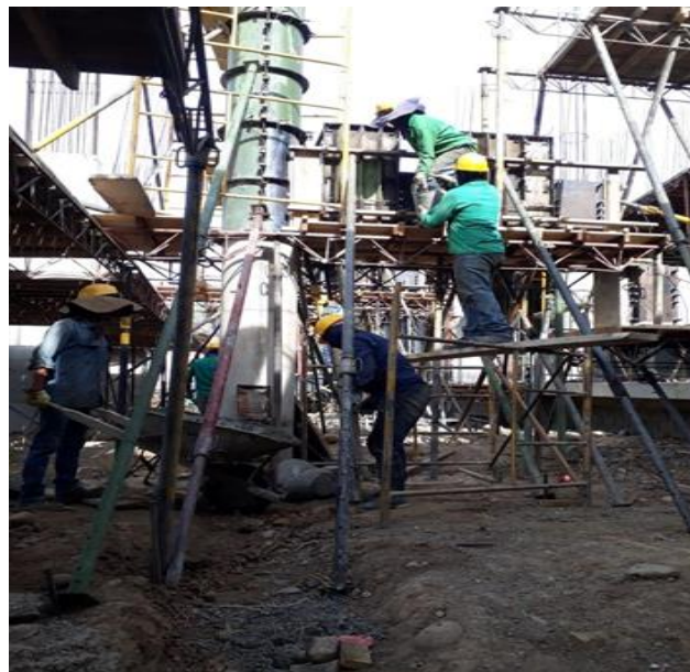
Figura 23. Vaciado del Concreto.
