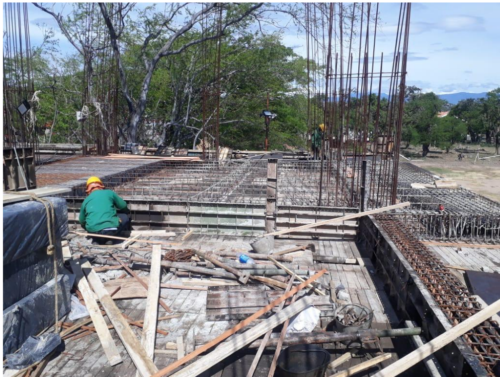
Figura 14. Armado de Acero Sección Vigas y Placa Aligerada.
