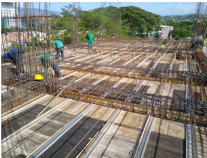
Figura 12. Acero de refuerzo para Columnas y Placa Aligerada.
