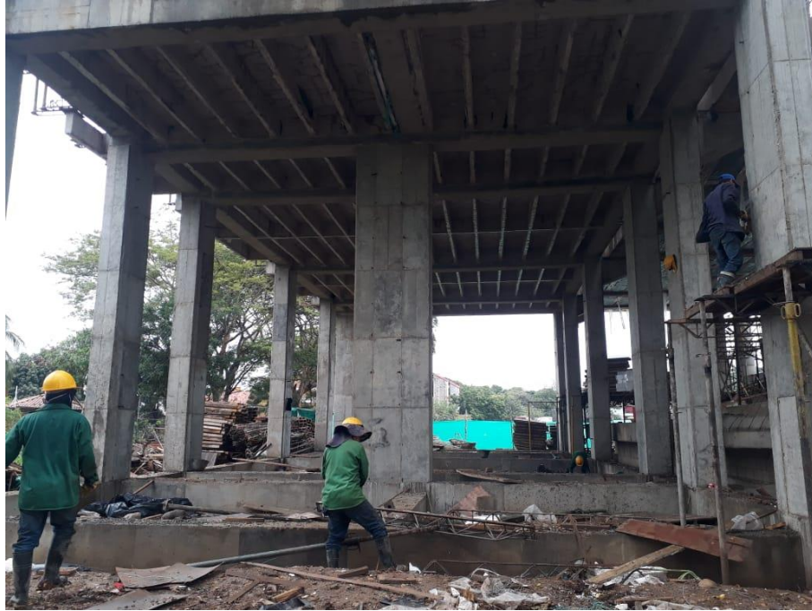
Figura 30. Vista Frontal de las columnas cuadradas.
