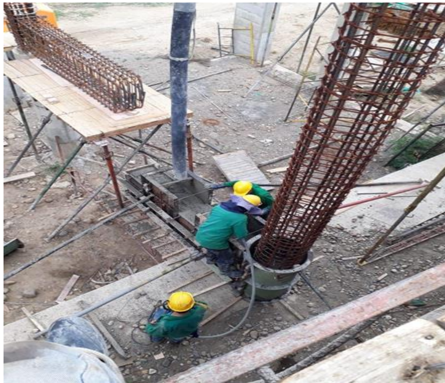
Figura 19. Fundida de Columna Redonda.
