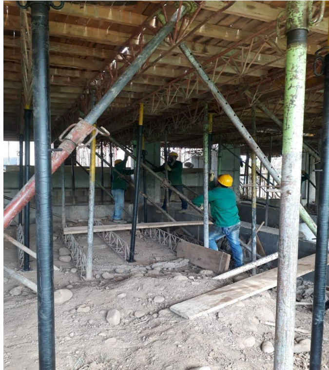
Figura 15. Verificación de Formaletas.
