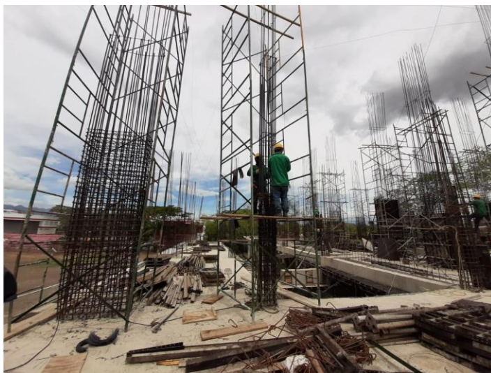
Figura 28. Estado final de armado de Acero. Proyecto Aulas Orientales Fase II.
