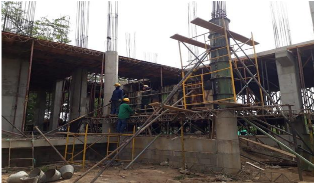
Figura 20. Fundación Columnas Redondas parte Superior. Fuente: Propia.
