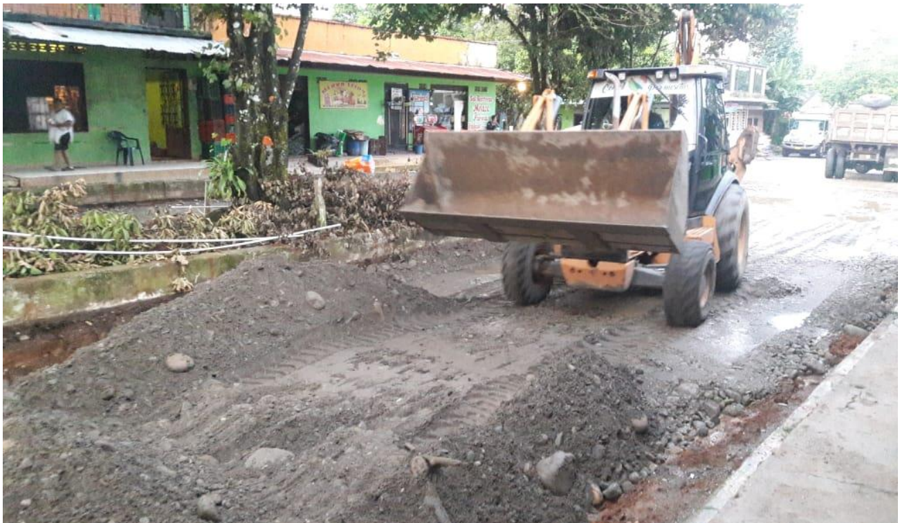
Ilustración 32. Transporte, extendido y compactación de material de base granular.
