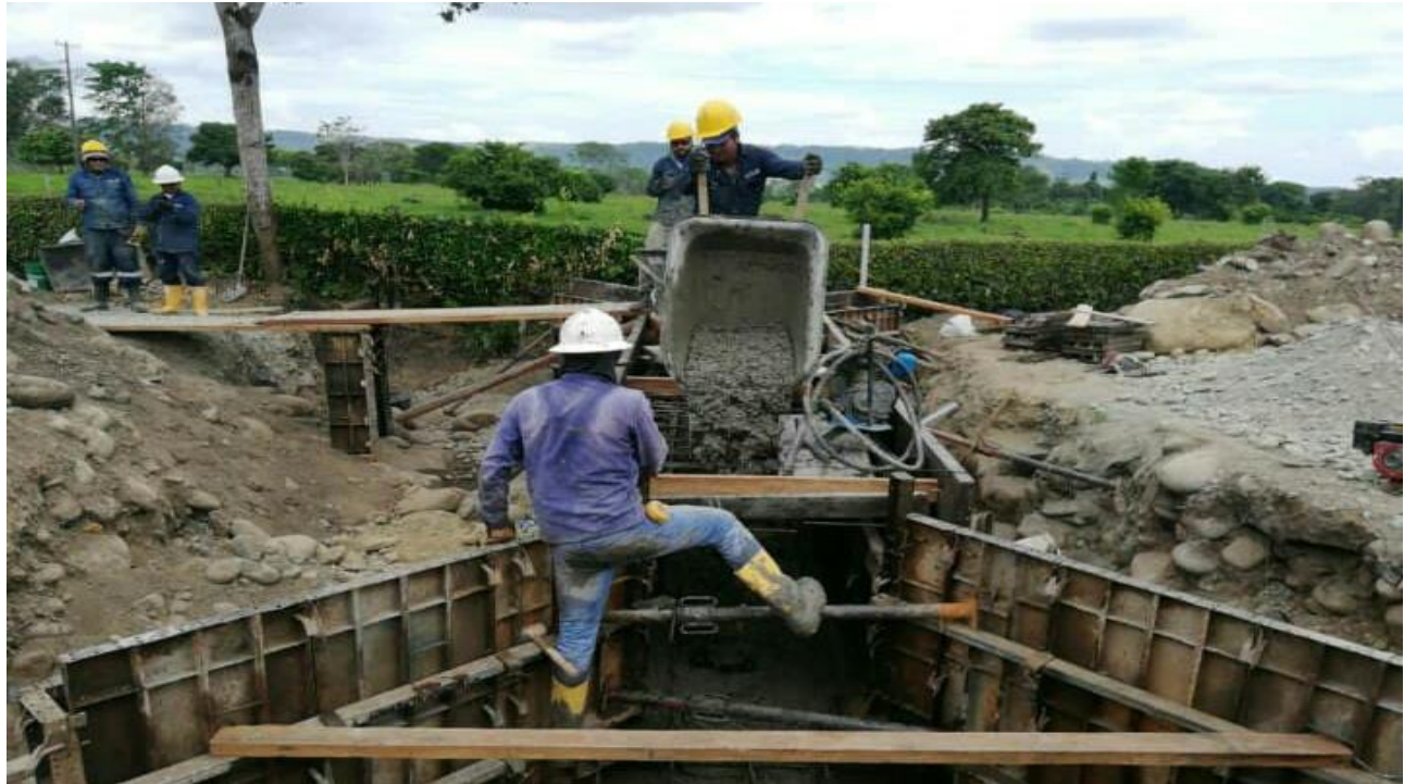
Ilustración 23. Avance de obras de arte en el contrato No° 155-2019
