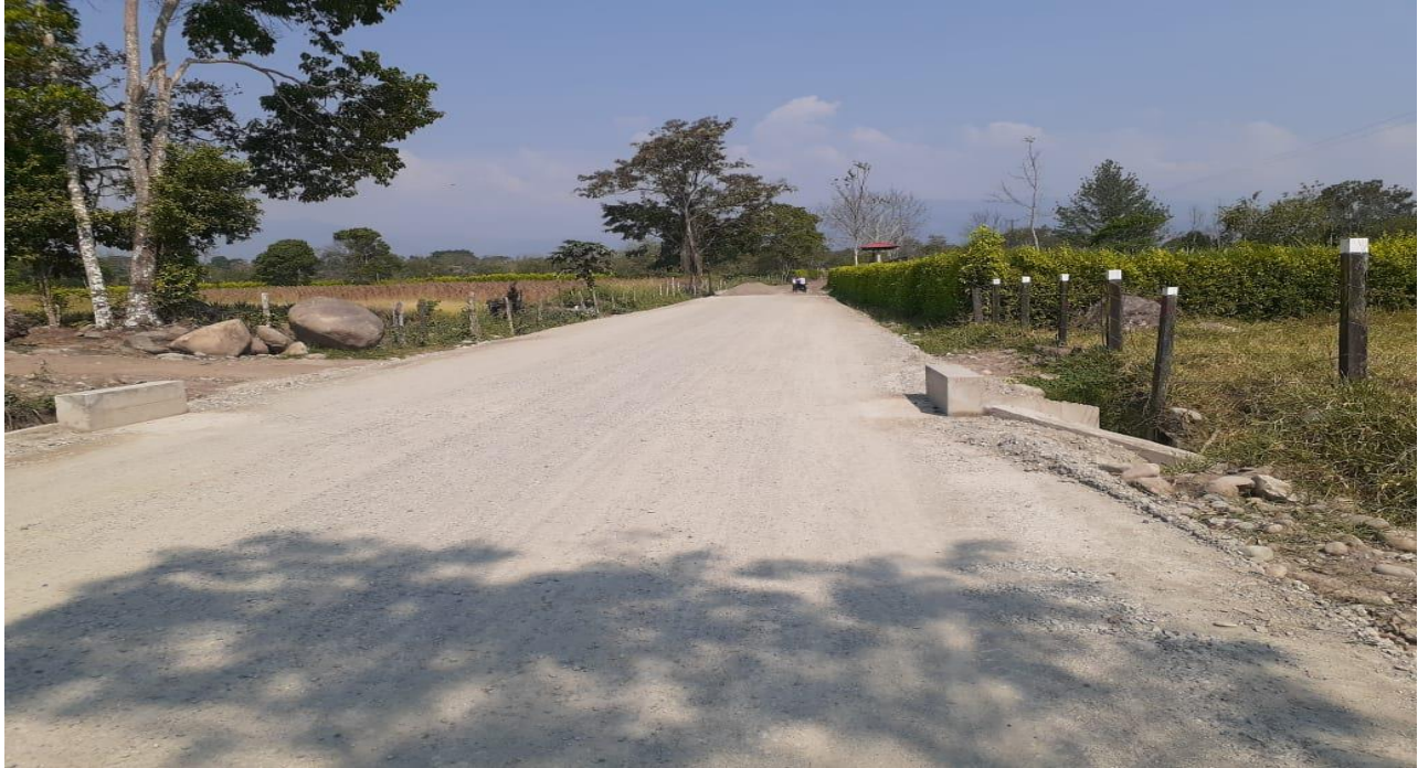
Ilustración 22. base granular BG-1 en el K0+489
