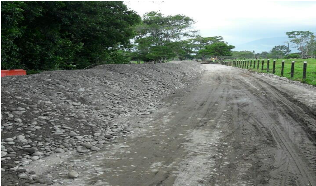
Ilustración 21. Material de subbase.
