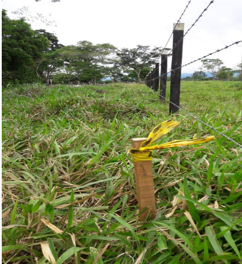
Ilustración 17. Localización y replanteo ubicación de estaca según el diseño y trazado.
