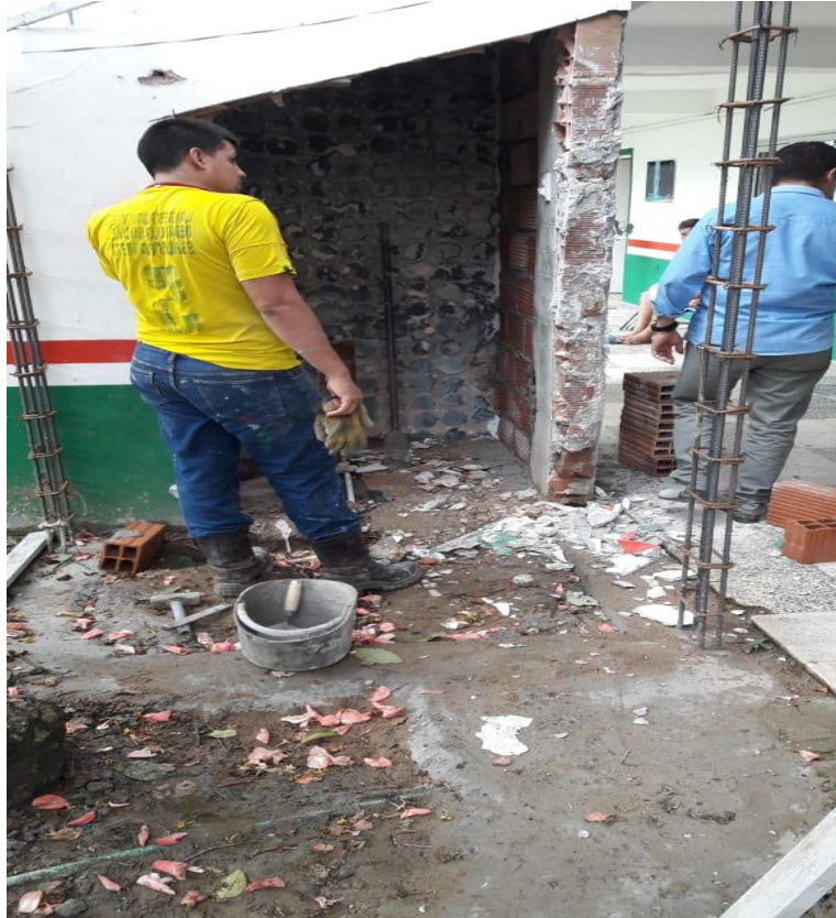
Ilustración 28. Avance de obra del contrato Mejoramiento del Archivo alcaldía.
