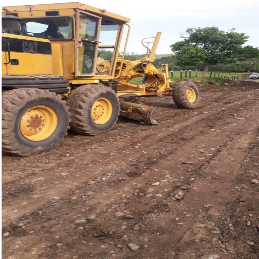
Ilustración 19. Trabajo de nivelación, compactación y ampliación de la bancada existente.
