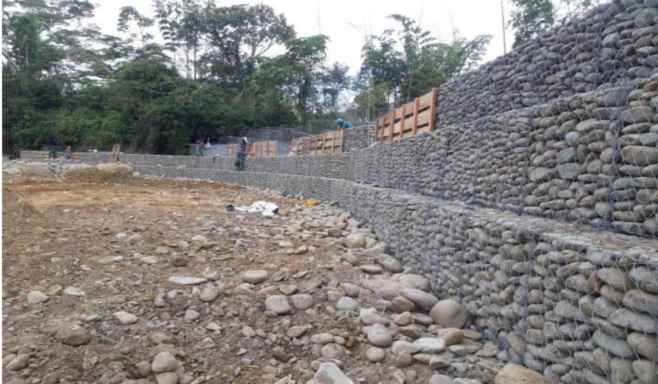
Ilustración 25. Vista de obra sobre el Rio Lucia. Obras de protección en gaviones
