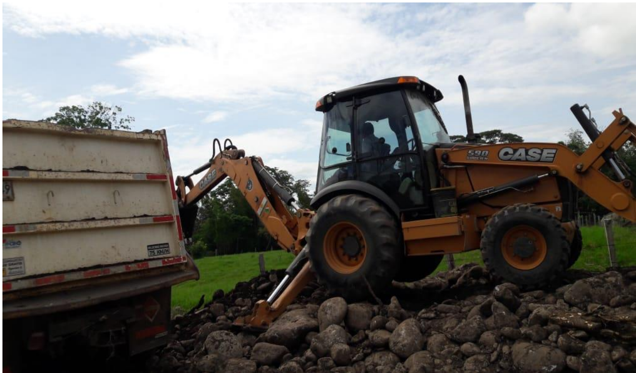
Ilustración 20. Trabajo de excavación mecánica.
