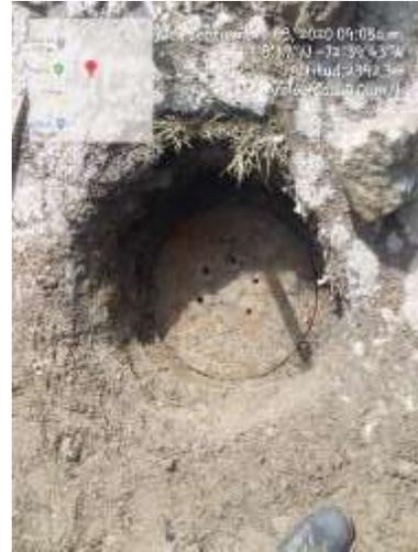
Ilustración 33. Tapa en Acero P-014      Ilustración 34. Pozo por Debajo de la Rasante P-017
