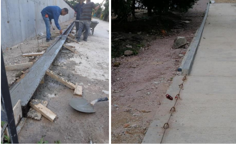
Ilustración 10 Bordillo fundido en sitio
