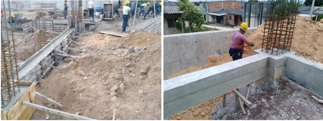
Ilustración 8 Vigas de cimentación 3000 psi
