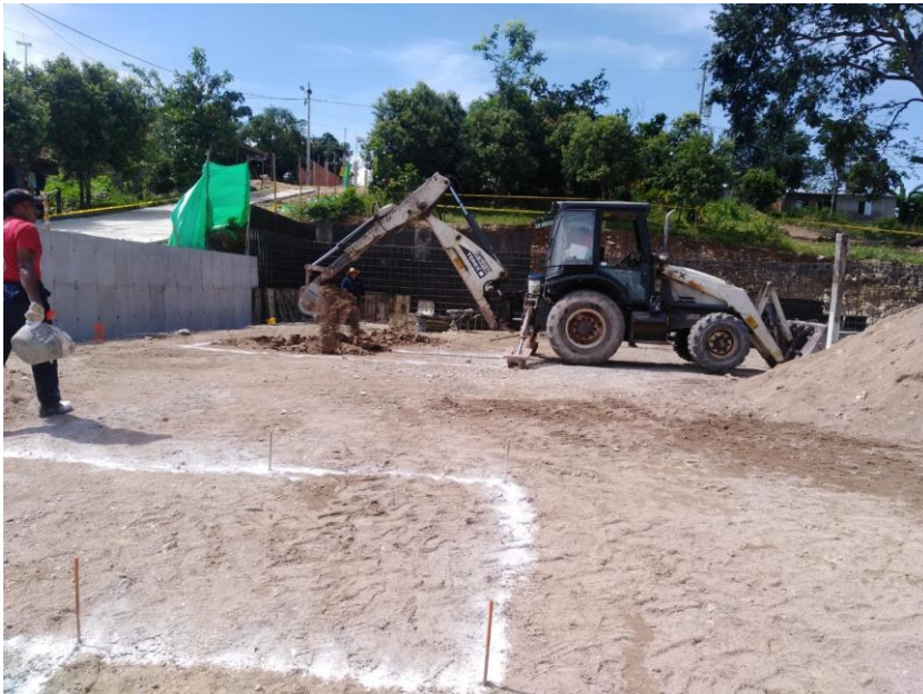
Ilustración 3 Localización y Replanteo
