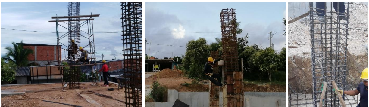
Ilustración 11 Columnas en concreto
