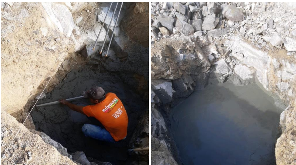
Ilustración 5 Solado de limpieza e=0.05m
