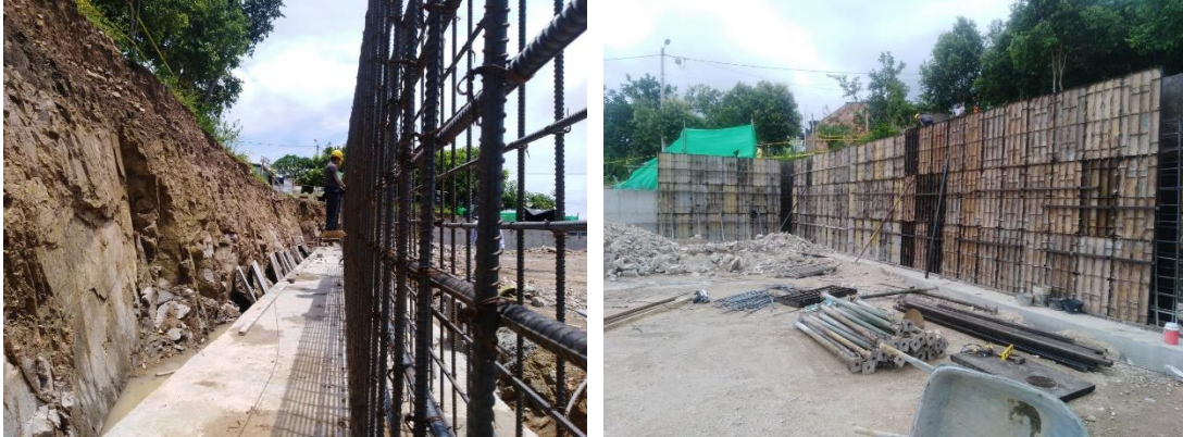
Ilustración 12 Armado y encofrado muros de contención
