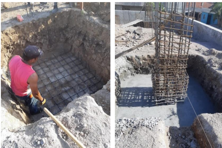
Ilustración 7 Zapata en concreto
