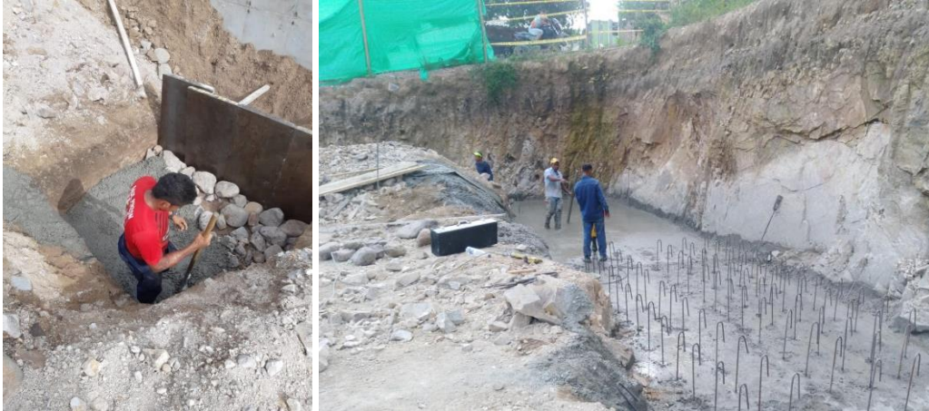
Ilustración 6 Concreto ciclópeo
