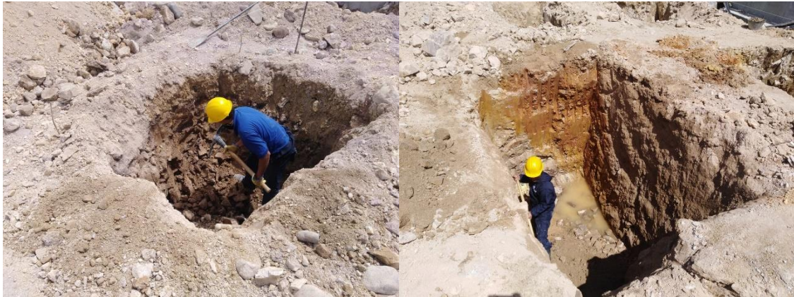
Ilustración 4 Excavación manual zapata y contrapeso
