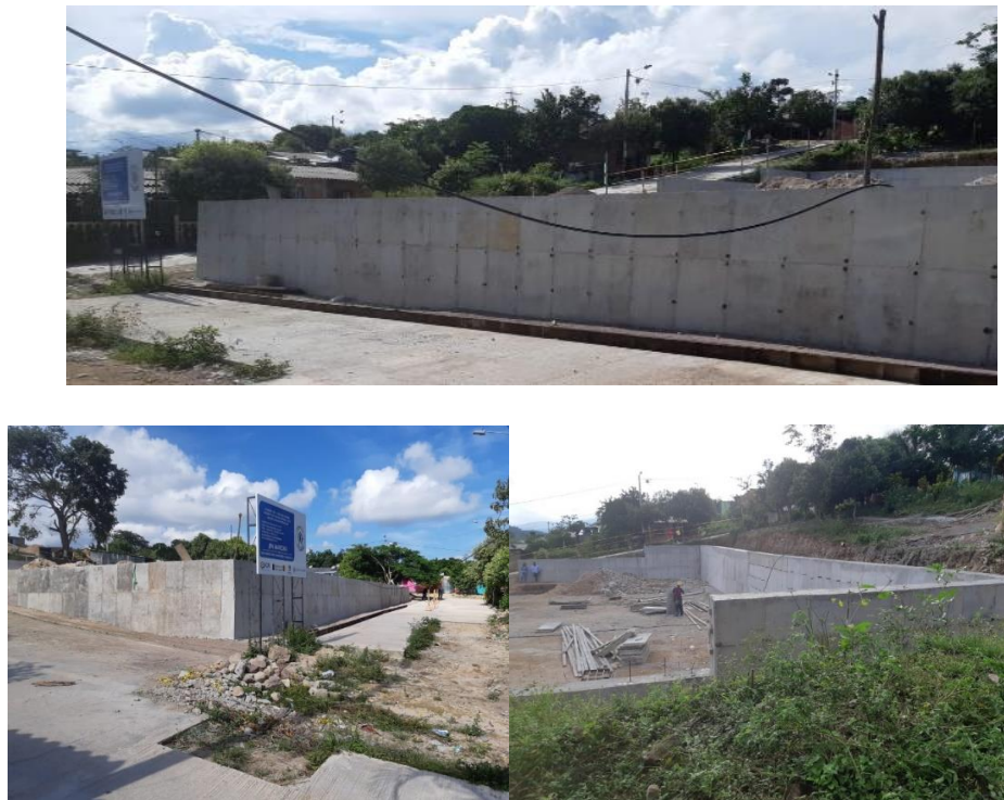
Ilustración 13 Muro de contención.
