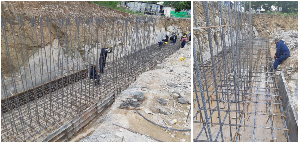
Ilustración 9 Acero de refuerzo 60.000 psi
