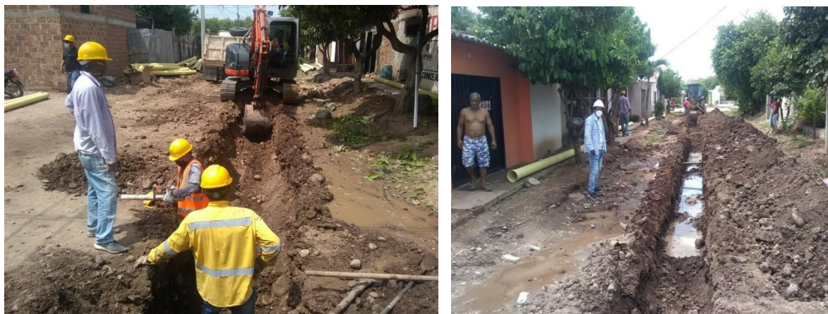
Ilustración 23. Excavaciones para la instalación de la red de alcantarillado.
