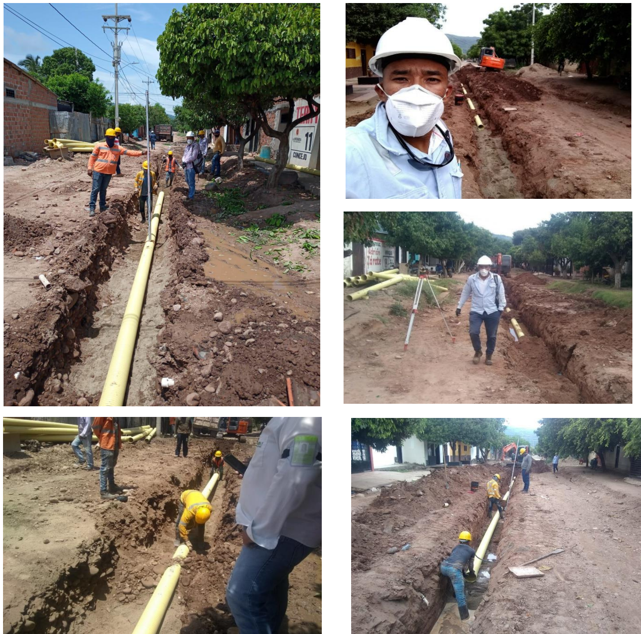
Ilustración 24. Instalacion De La Red Principal De Alcantarillado. Fuente: Elaboración Propia Por El Autor.
