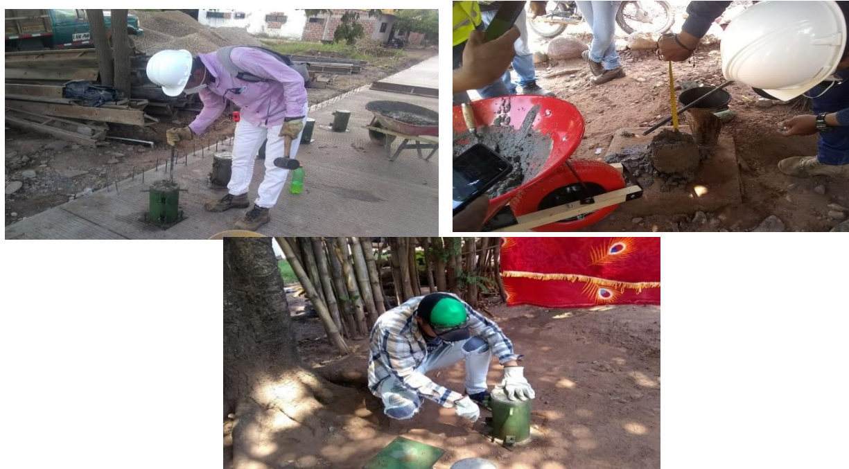
Ilustración 18. Ensayo De Concreto Pavimento De Hidráulico 4000psi.
