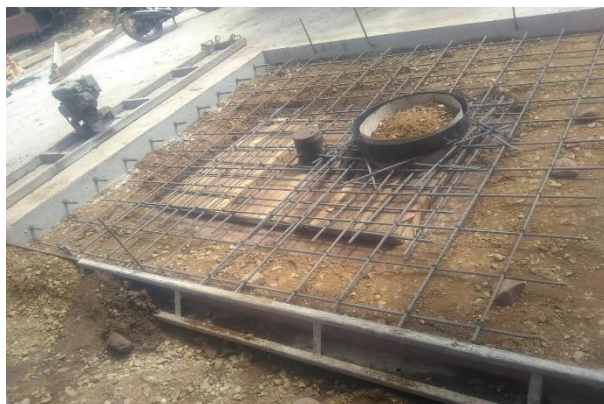
Ilustración 21. Acero De Refuerzo Corrugado. Fuente: Elaboración Propia Por El Autor.
