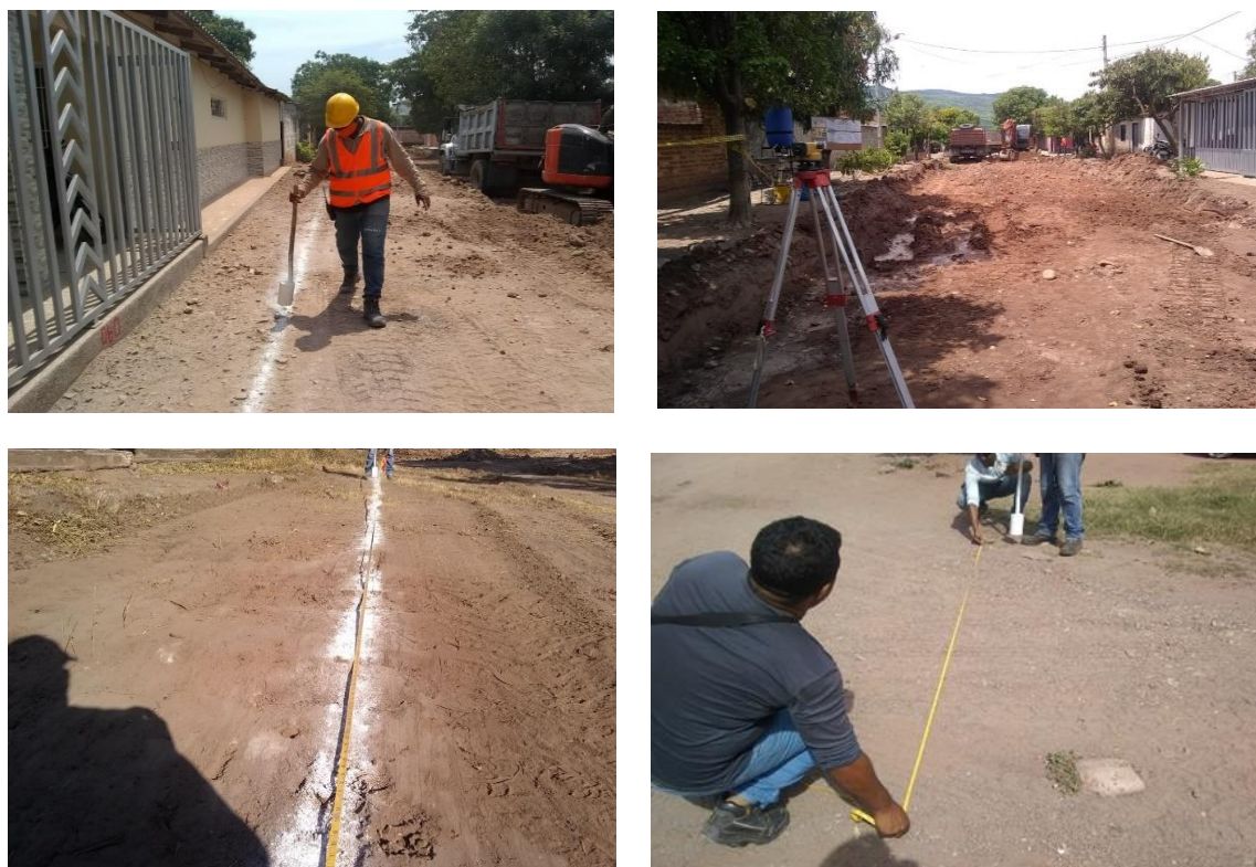
Ilustración 13. Localización Y Replanteo Topográfico. Fuente: Elaboracion Propia Por El Autor.
