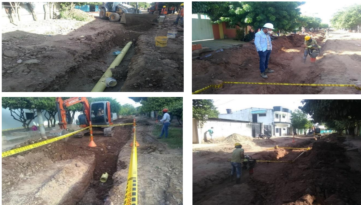
Ilustración 25. Instalación de relleno y compactación para la tubería de alcantarillado. Fuente: elaboración propia por el autor
