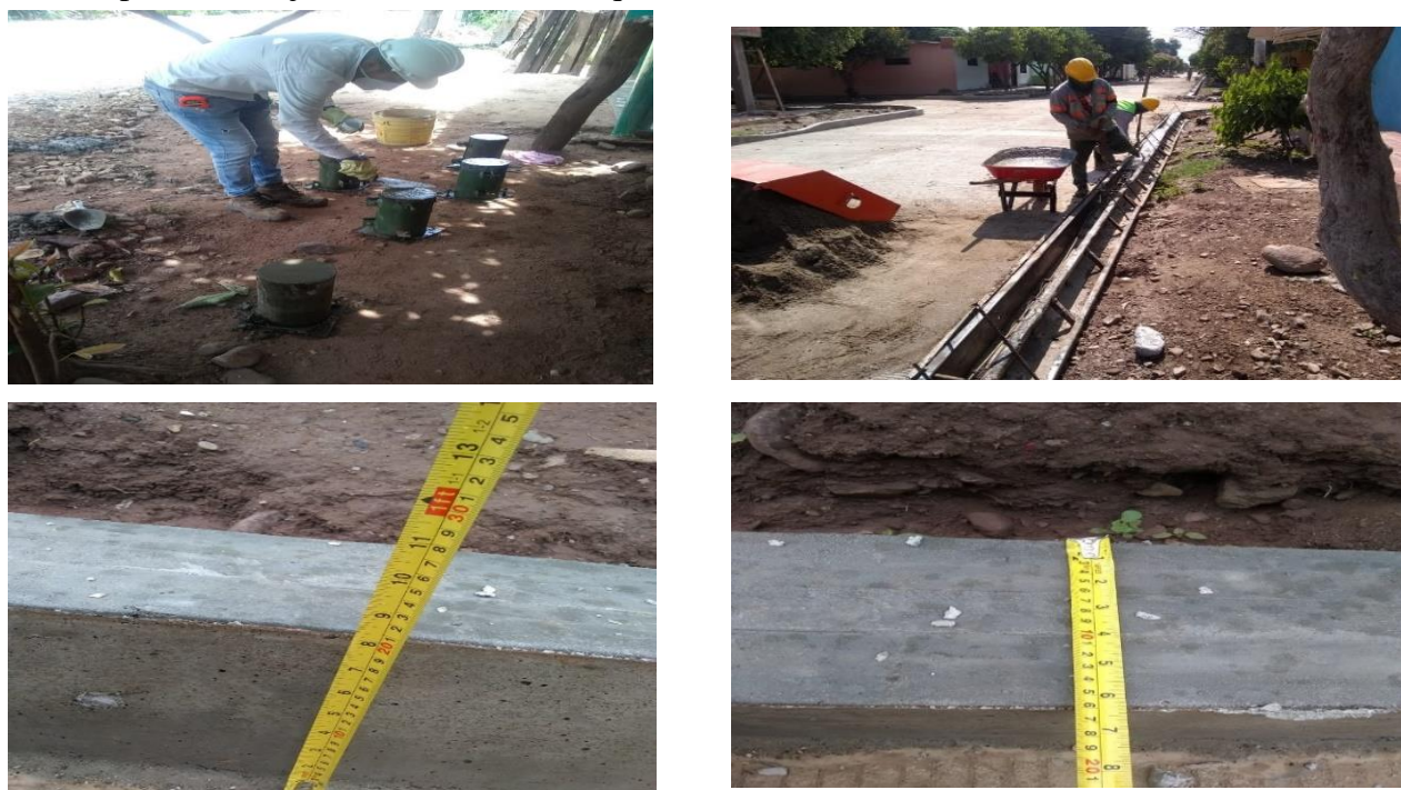
Ilustración 19. Instalación En Concreto De Hidráulico 3000psi Para Bordillos
