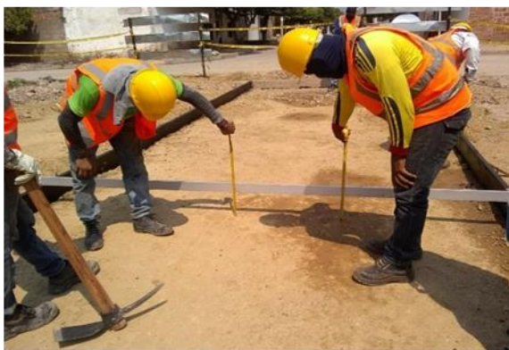
Ilustración 16. Nivelación De Terreno Para La Instalación De Concreto Fuente: Elaboración Propia Por El Autor
