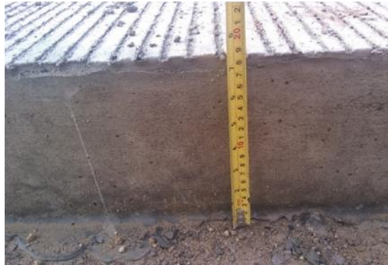
Ilustración 17. Instalación En Concreto De Pavimento Hidráulico 4000psi. Fuente: Elaboración Propia Por El Autor.
