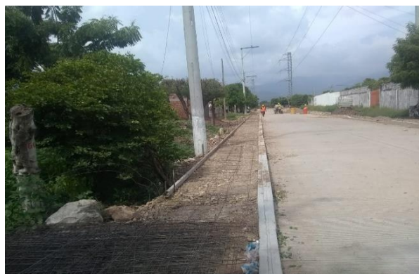
Ilustración 20. Instalación en concreto de hidráulico 3000 psi para andenes.
