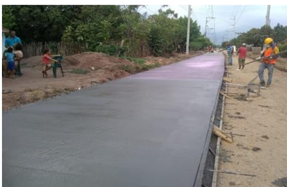
Ilustración 17. Instalación En Concreto De Pavimento Hidráulico 4000psi. Fuente: Elaboración Propia Por El Autor.
