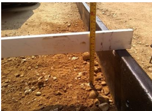
Ilustración 16. Nivelación De Terreno Para La Instalación De Concreto Fuente: Elaboración Propia Por El Autor
