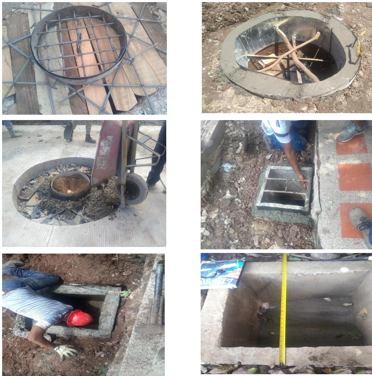
Ilustración 26. Reparación Fundida de pozos de inspección y cajillas. Fuente: elaboración propia por el autor.
