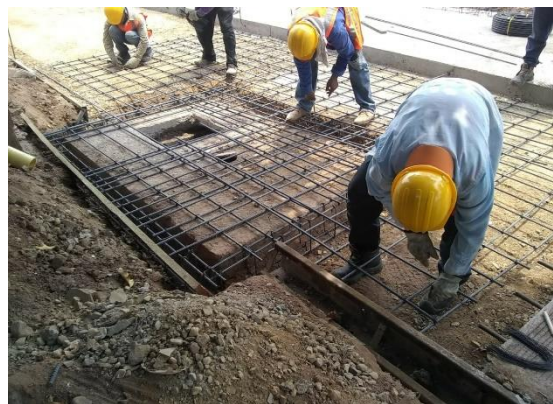
Ilustración 21. Acero De Refuerzo Corrugado. Fuente: Elaboración Propia Por El Autor.
