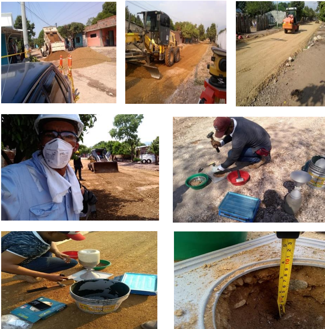
Ilustración 15. Afirmado Base Granular Fuente: Elaboración Propia Por El Autor
