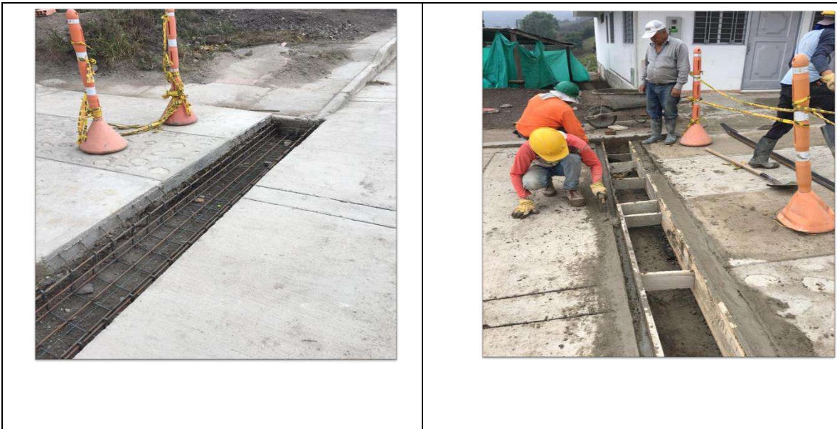
Cárcamo en concreto de 3000 Psi
