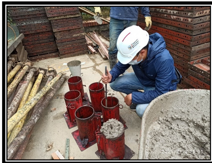
Ilustración 40 Realización de cilindros para ensayo de compresión
