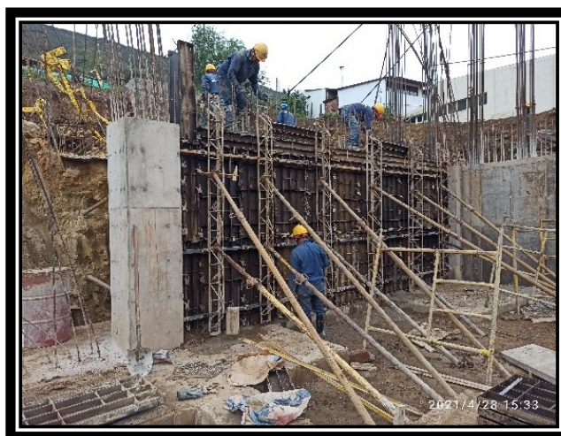
Ilustración 31 Muestra de vaciado de muro de contención perimetral
