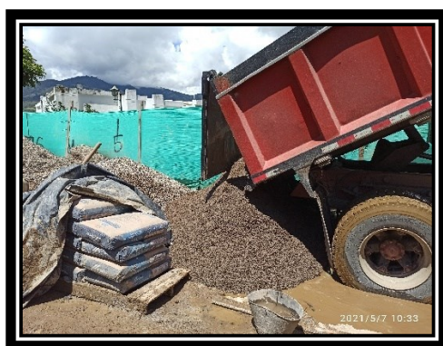
Ilustración 36 Ingreso de materiales a la obra
