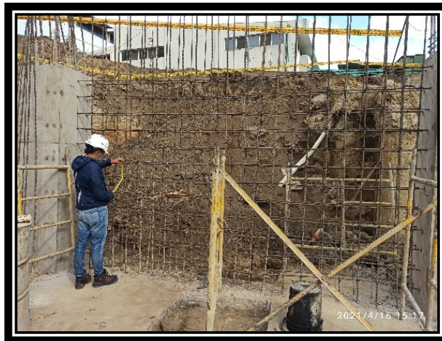
Ilustración 29 Muestra de armado de muro de contención perimetral
