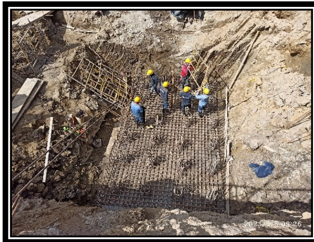
Ilustración 24 Muestra de Pilotes de cabezal GP1
