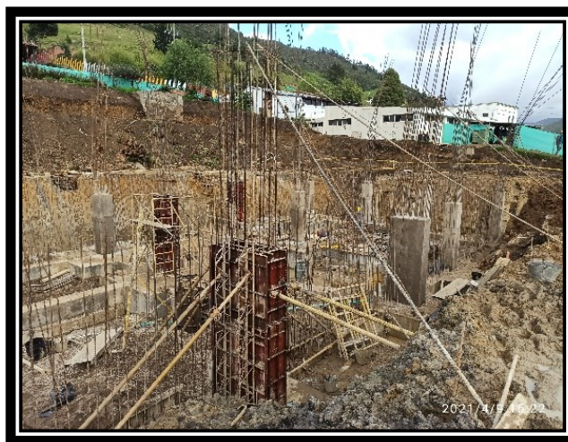
Ilustración 28 Muestra de columnas del nivel -3 soterrado
