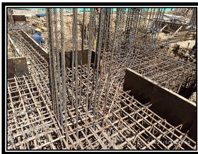
Ilustración 25 Muestra de armado de cabezal GP4 en el eje G3
