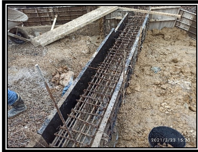
Ilustración 27 Muestra de armado de viga de cimentación
