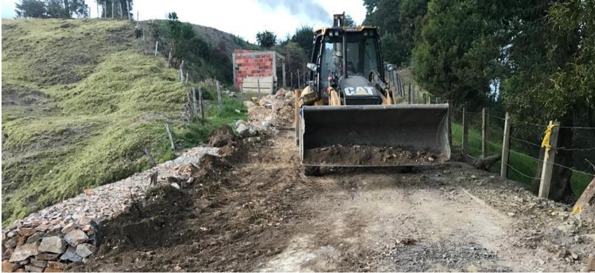
Ilustración 21 relleno y limpieza.
