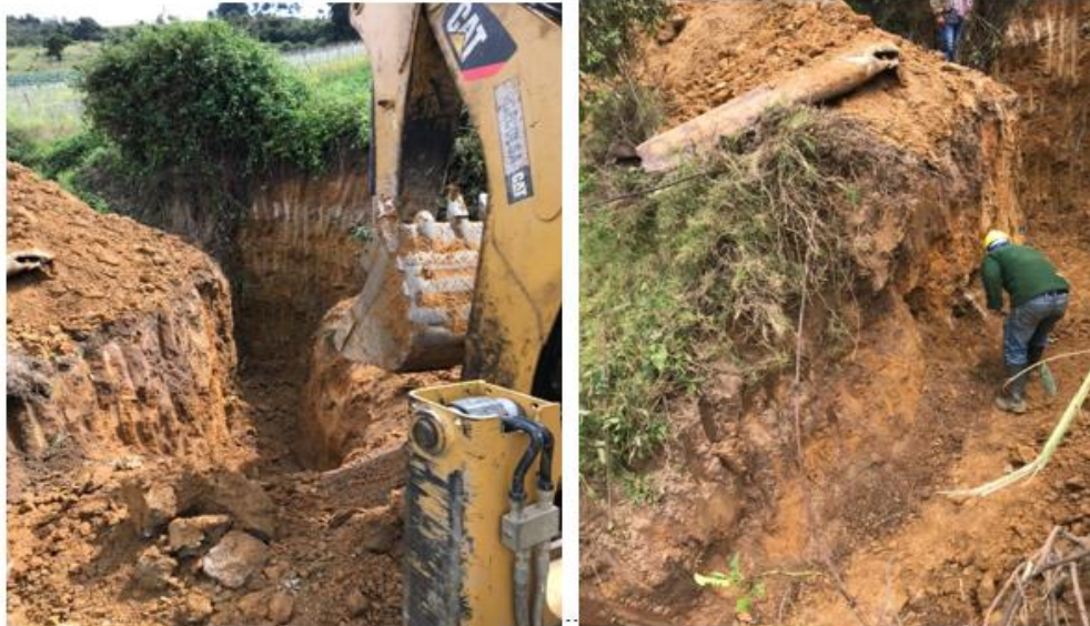
Ilustración 28 excavación con maquina y manual.
