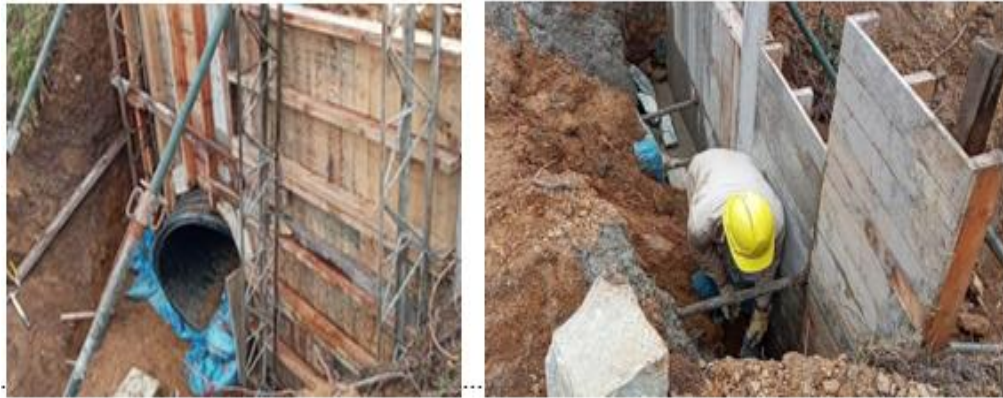
Ilustración 30 armado del encofrado y estructura de la alcantarilla.
