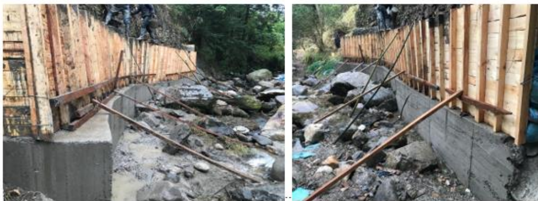
Ilustración 24 armado y fundición de la segunda sección.
