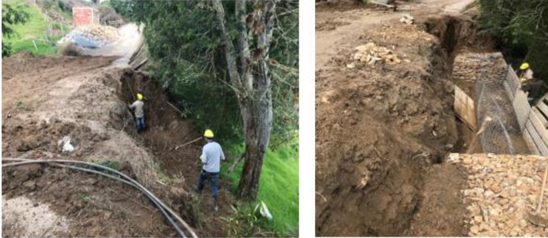
Ilustración 15 nivelación medición adecuación para armado de las mallas.
