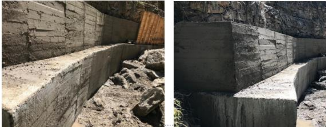
Ilustración 25 desencofrado y terminación del muro.
