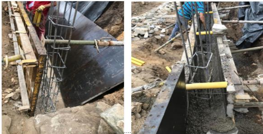
Ilustración 7 armado y concretos.
