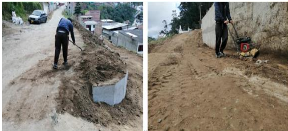
Ilustración 9 compactación, nivelación y aseo final.
