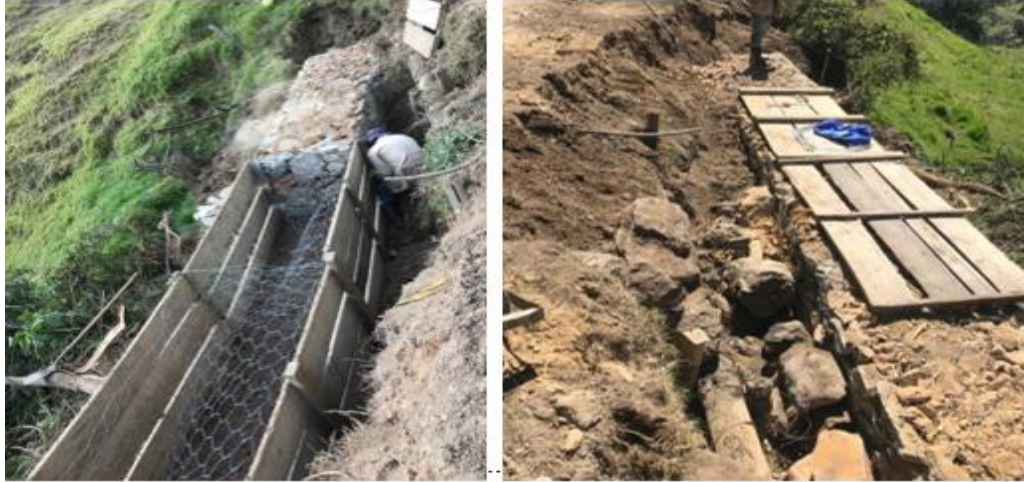
Ilustración 19 armado segunda línea de gaviones.
