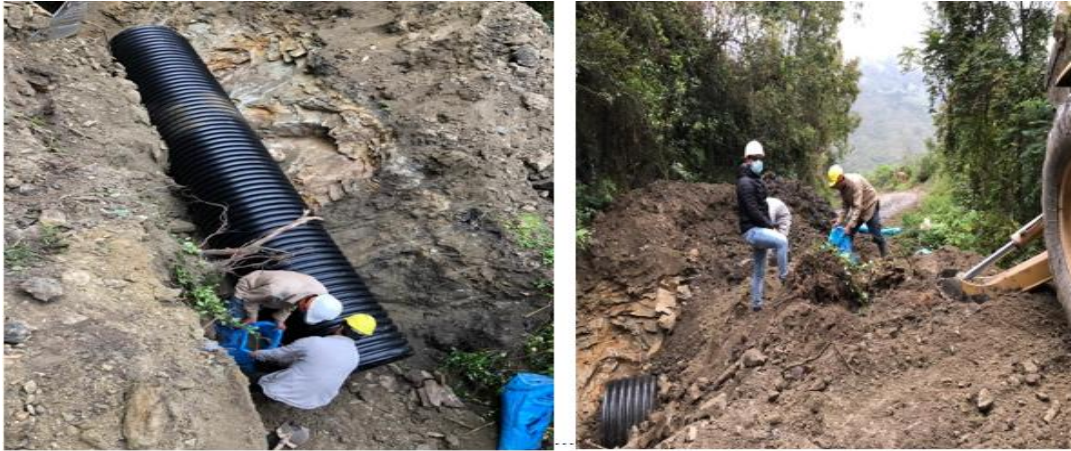
Ilustración 34 instalación de la tubería de 6 metros y 36”.
