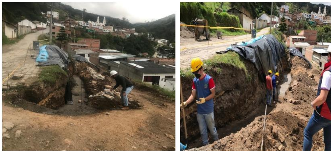
Ilustración 5 avance de la obra
