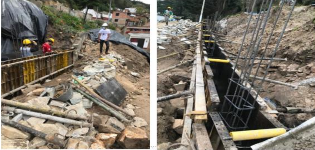
Ilustración 6 armado de acero de refuerzo y encofrado.
