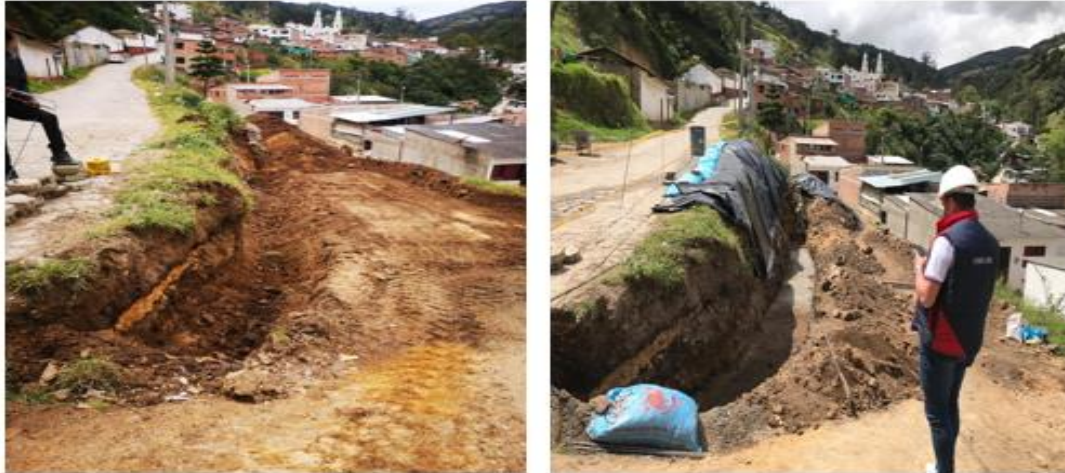
Ilustración 4 avance de la obra
