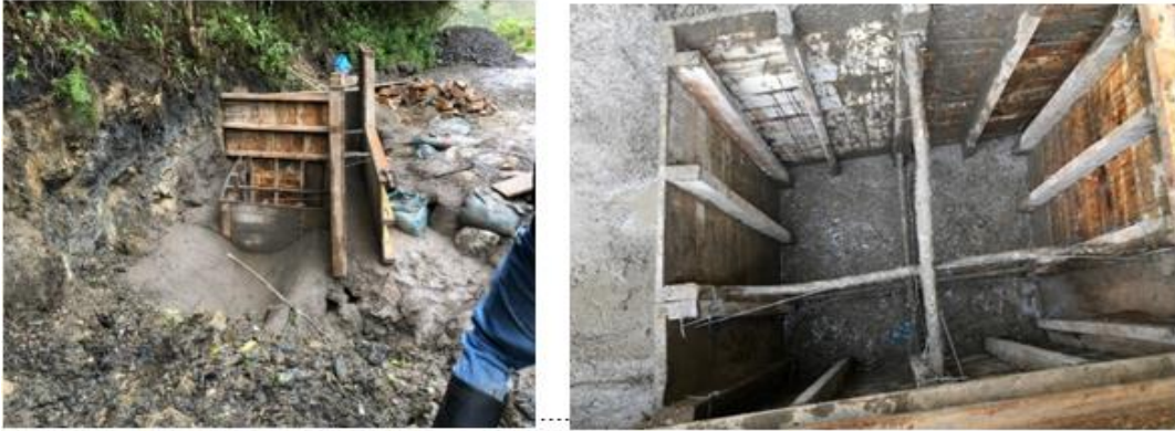
Ilustración 36 fundición en concreto.
