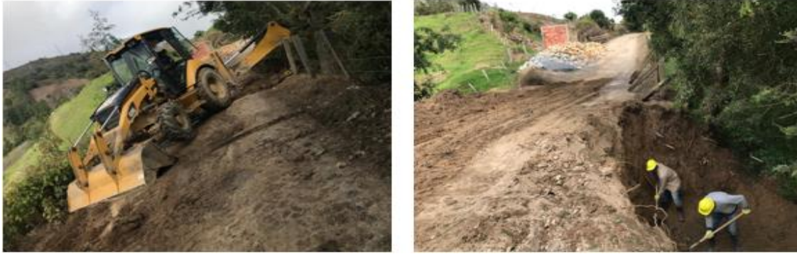
Ilustración 13 excavaciones con maquinaria y manual.
