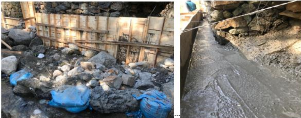
Ilustración 23 armado y fundición de la primera sección.
