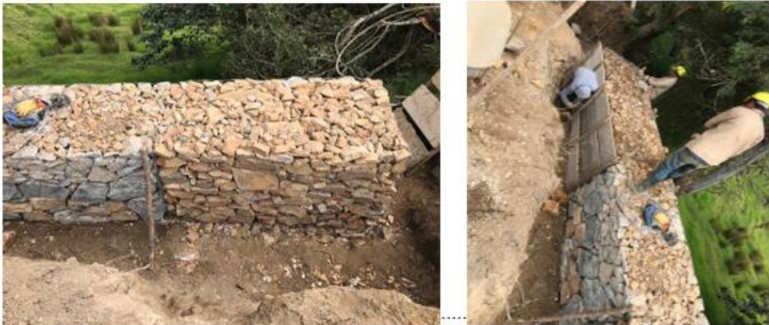
Ilustración 16 inicio de construcción de armado de gaviones.
