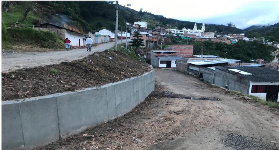
Ilustración 10 muro de contención en el barrio brisas del tapagua.
