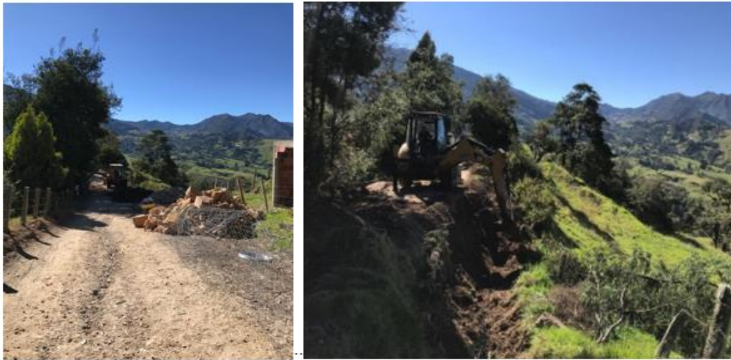
Ilustración 18 inicio de segunda excavación.
