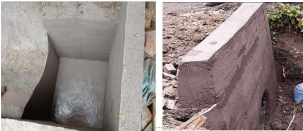
Ilustración 37 desencofrado y limpieza.
