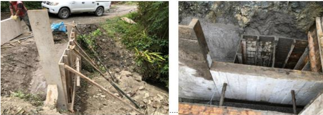
Ilustración 35 encofrado.
