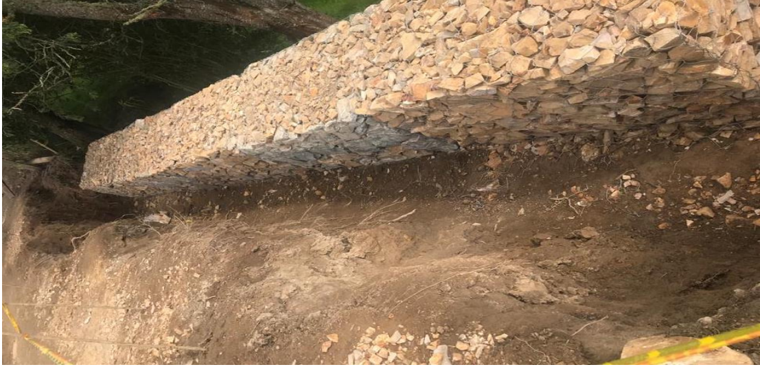
Ilustración 17 primera línea de gaviones.
