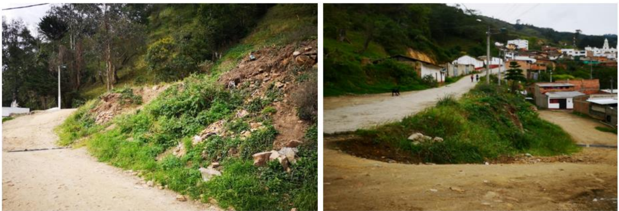
Ilustración 2 lugar antes de la intervención
