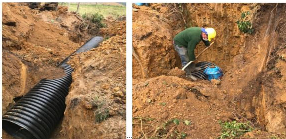
Ilustración 29 instalación de la tubería de 6 metros y 36”.
