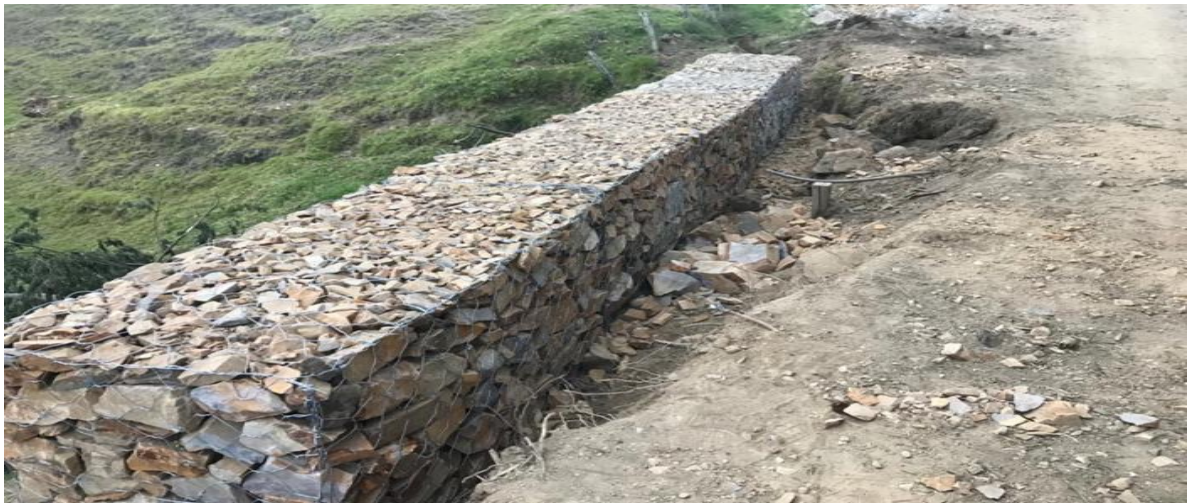
Ilustración 20 finalización de la segunda línea de gaviones.
