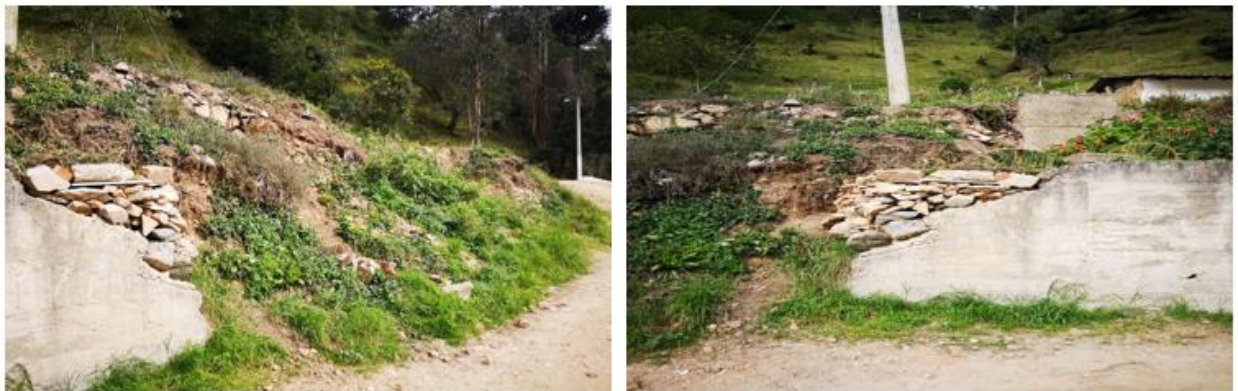
Ilustración 3 lugar antes de la intervención
