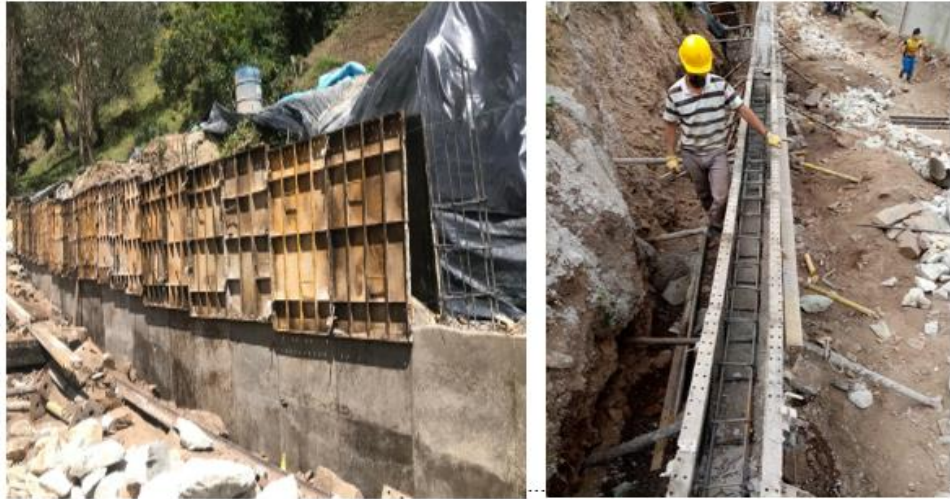
Ilustración 8 armado y concretos.
