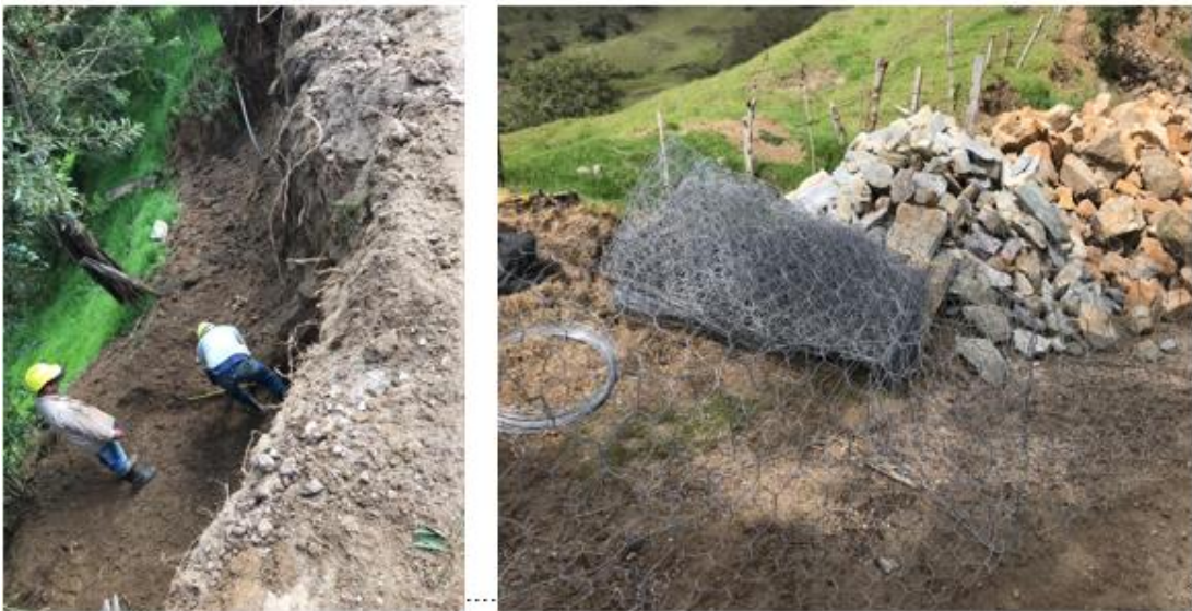
Ilustración 14 nivelación medición adecuación para armar las mallas.
