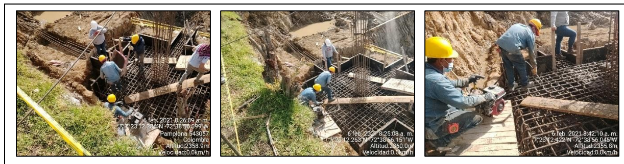
Figura 27 Fundición de cabezales y correcto vibrado
