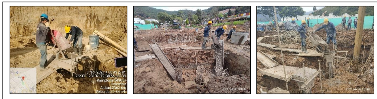
Figura 26 Fundición de micropilotes
