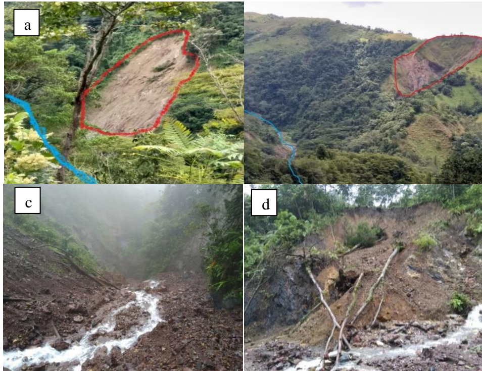
Fotografía 14. a) y b). Deslizamientos activos sobre la quebrada Marayal. c) y d). Deslizamientos activos sobre el caño Hondo.
