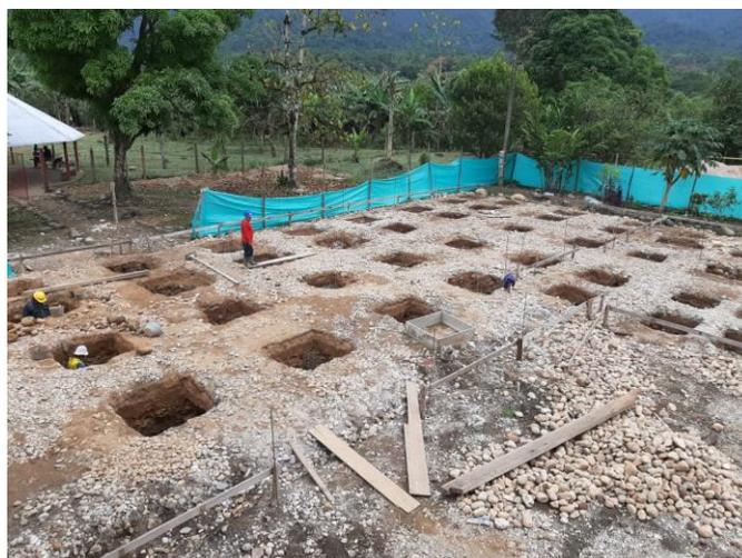
Ilustración 12 Excavación Manual
