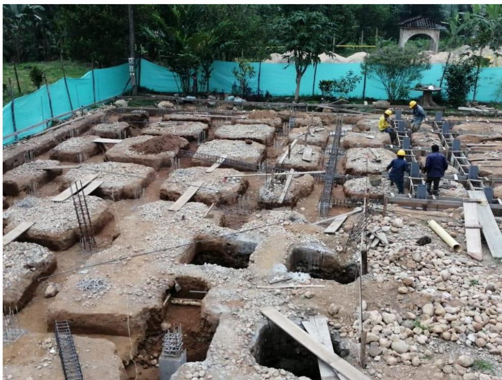
Ilustración 42 Concreto de zapatas
