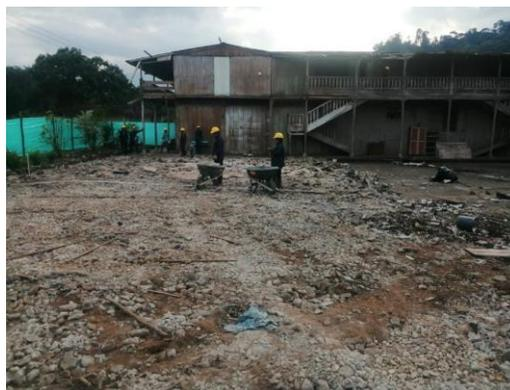
Ilustración 11 Demolición de pisos en concreto
