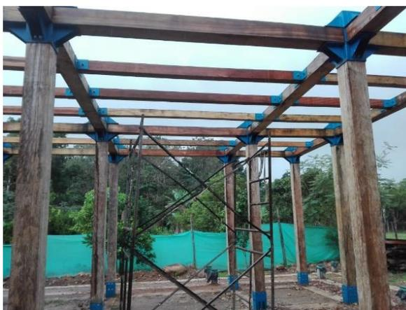
Ilustración 9 Anclaje vigas y columnas
