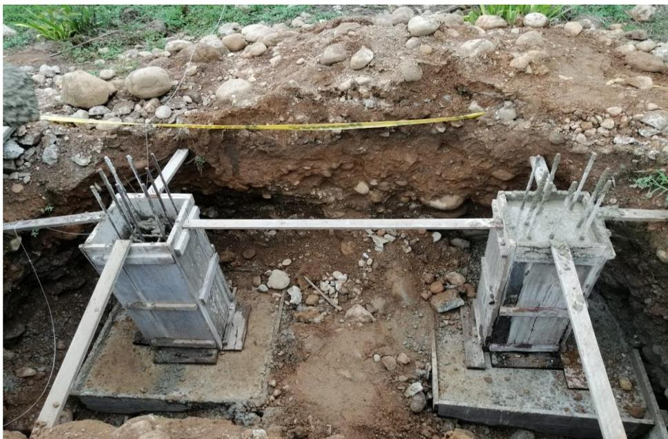
Ilustración 41 Pedestal en concreto
