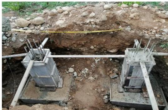
Ilustración 15 Pedestal en concreto
