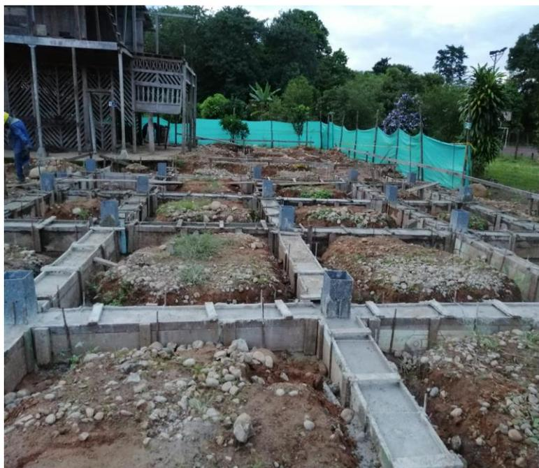
Ilustración 16 Vigas de cimentación
