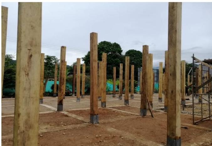
Ilustración 8 Instalación de columnas
