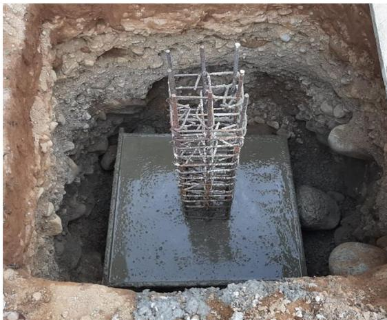
Ilustración 14 Concreto Zapatas
