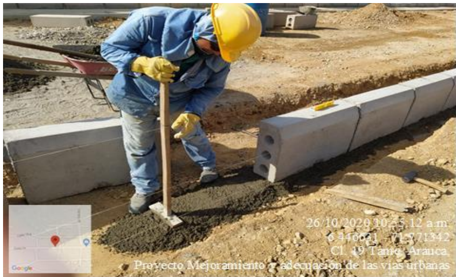
Ilustración 24. Instalación sardinel a-10 Fuente: Patiño Angie. 2021.
