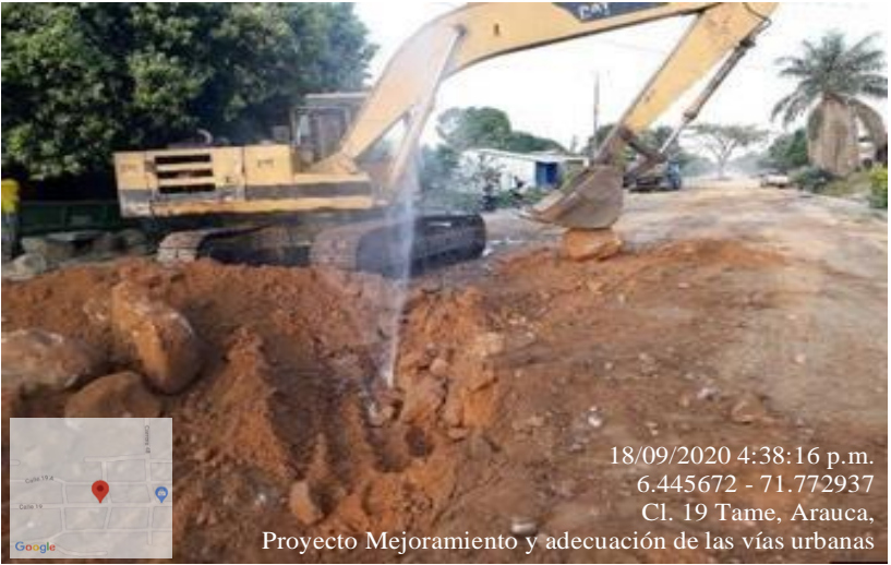
Ilustración 10. Excavación mecánica Fuente: Patiño Angie. 2021.
