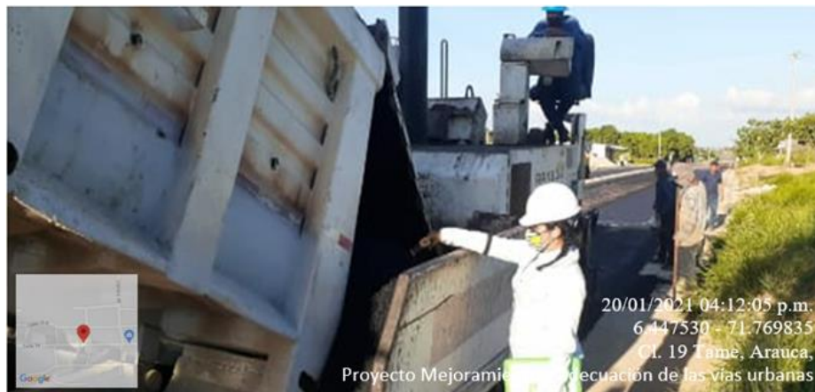
Ilustración 22. Instalación mezcla Fuente: Patiño Angie. 2021.
