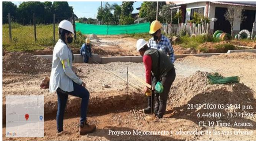
Ilustración 31. Excavación manual Fuente: Patiño Angie. 2021.
