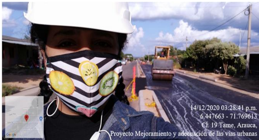
Ilustración 36. Compactación mezcla asfáltica Fuente: Patiño Angie. 2021.
