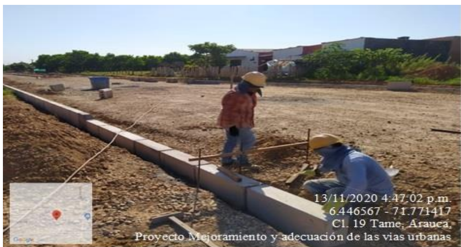
Ilustración 25. Instalación sardinel a-85 Fuente: Patiño Angie. 2021.
