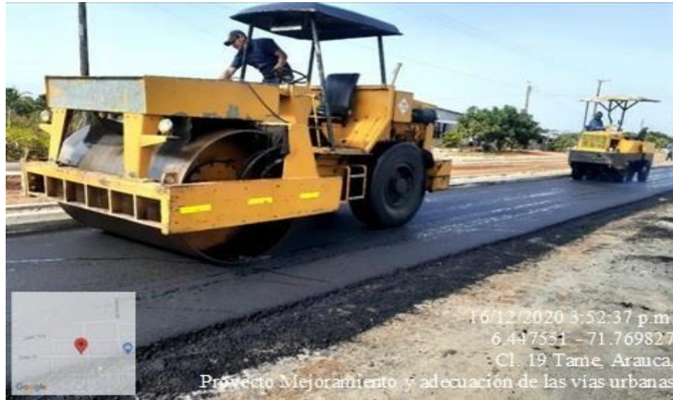
Ilustración 20. Compactación mezcla asfáltica Fuente: Patiño Angie. 2021.
