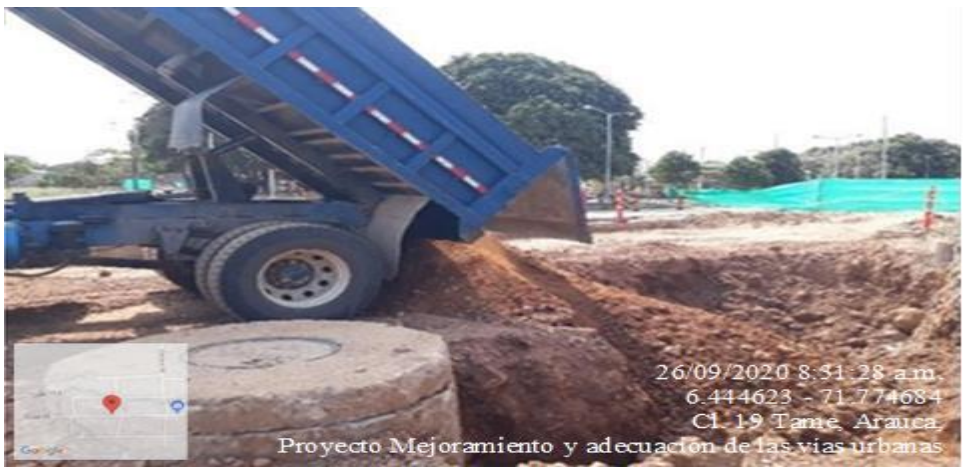
Ilustración 16. Material granular 4” Fuente: Patiño Angie. 2021.
