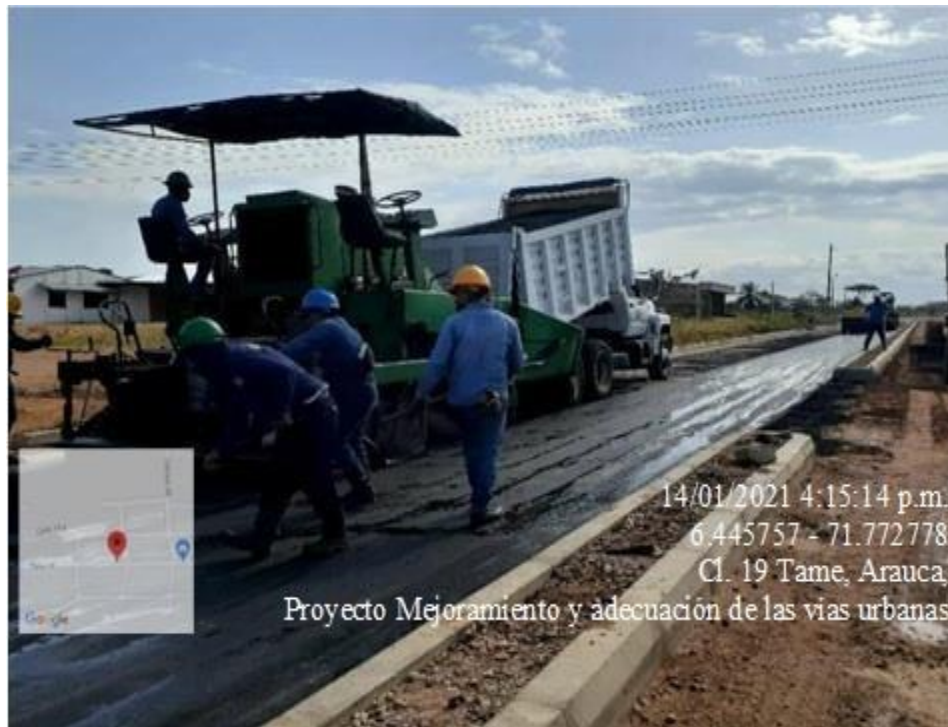
Ilustración 21. Instalación mezcla asfáltica Fuente: Patiño Angie. 2021.
