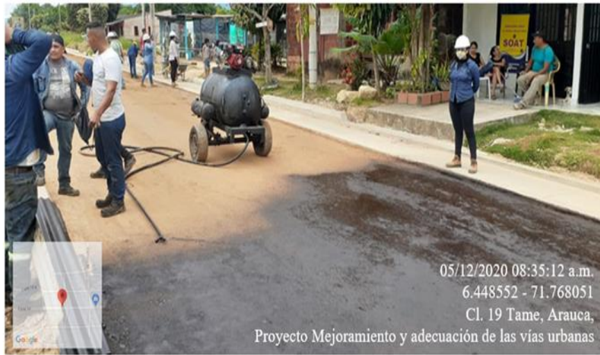
Ilustración 40. Riego de imprimación Fuente: Patiño Angie. 2021.
