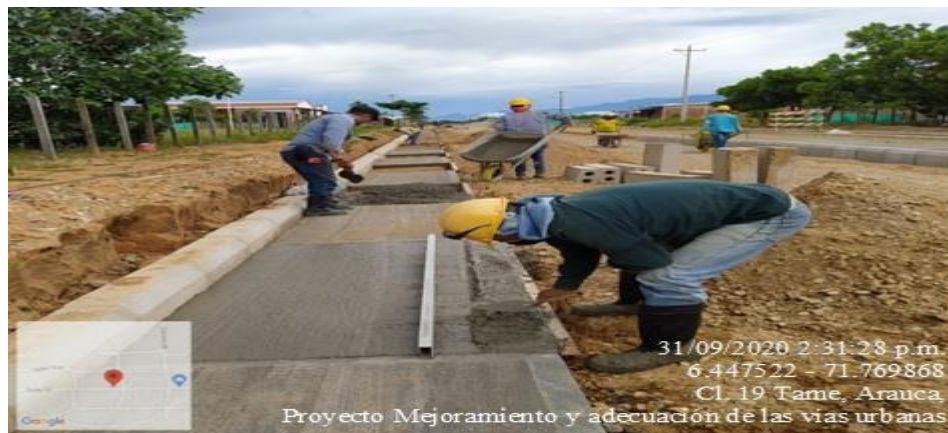
Ilustración 27. Construcción cuneta de 3000 PSI Fuente: Patiño Angie. 2021.
