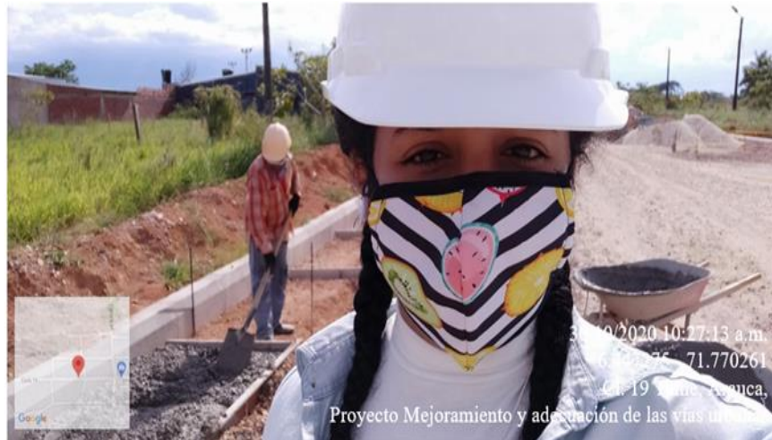
Ilustración 38. Refuerzo en la construcción de la cuneta Fuente: Patiño Angie. 2021.
