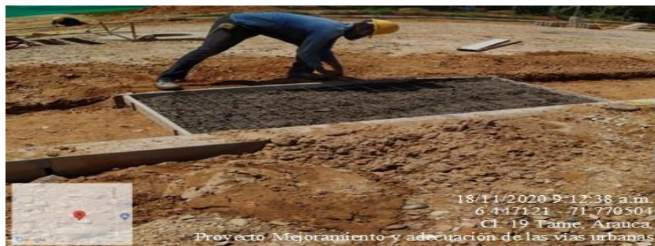
Ilustración 28. Refuerzo en la construcción de la cuneta Fuente: Patiño Angie. 2021.
