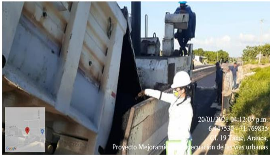
Ilustración 34. Instalación mezcla Fuente: Patiño Angie. 2021.
