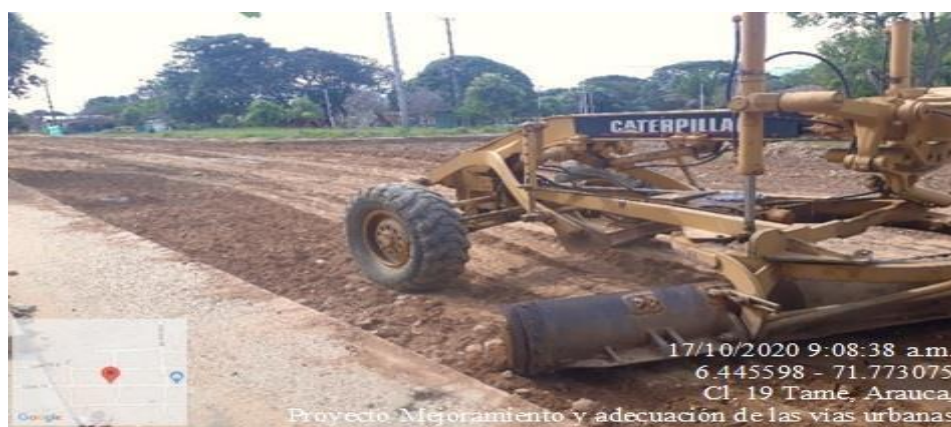
Ilustración 14. Nivelación De Subrasante
