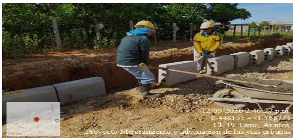
Ilustración 23. Instalación sardinell a-10 Fuente: Patiño Angie. 2021.
