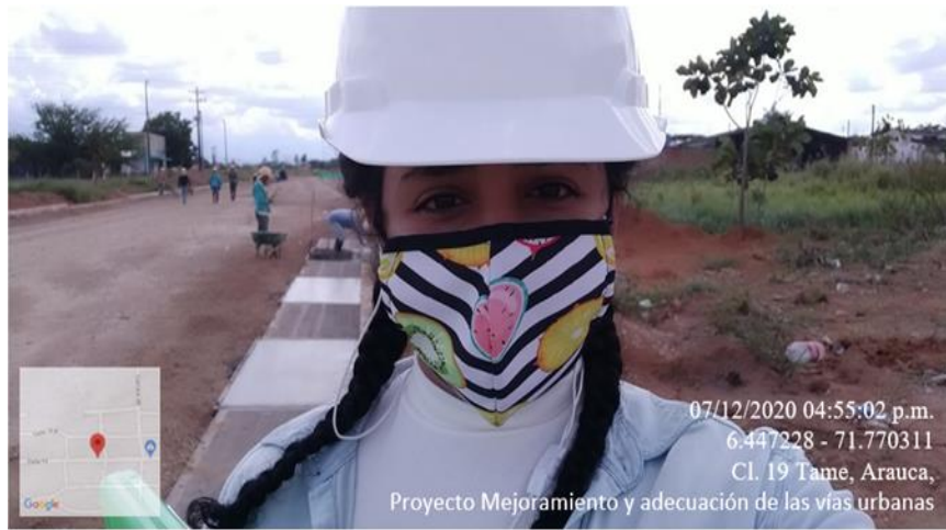
Ilustración 37. Construcción cuneta de 3000 PSI Fuente: Patiño Angie. 2021.
