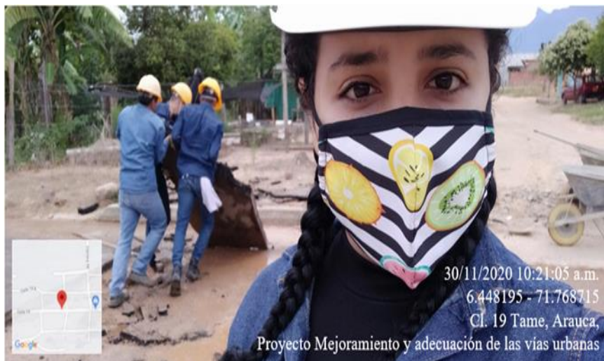
Ilustración 33. Retiro del pavimento Fuente: Patiño Angie. 2021.
