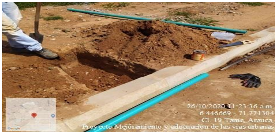
Ilustración 13. Reparación acometida hidráulica
