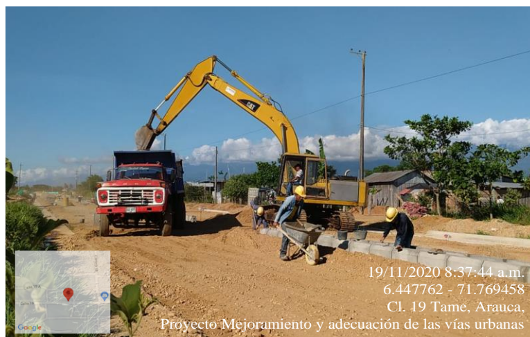
Ilustración 12. Retiro del material sobrante Fuente: Patiño Angie. 2021.
