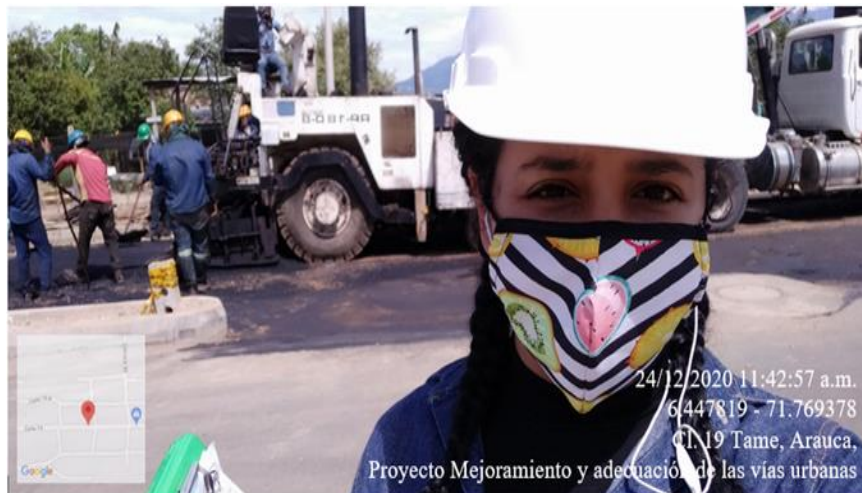
Ilustración 39. Instalación mezcla asfáltica Fuente: Patiño Angie. 2021.
