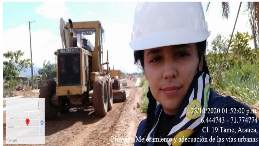
Ilustración 32. Nivelación De Subrasante Fuente: Patiño Angie. 2021.
