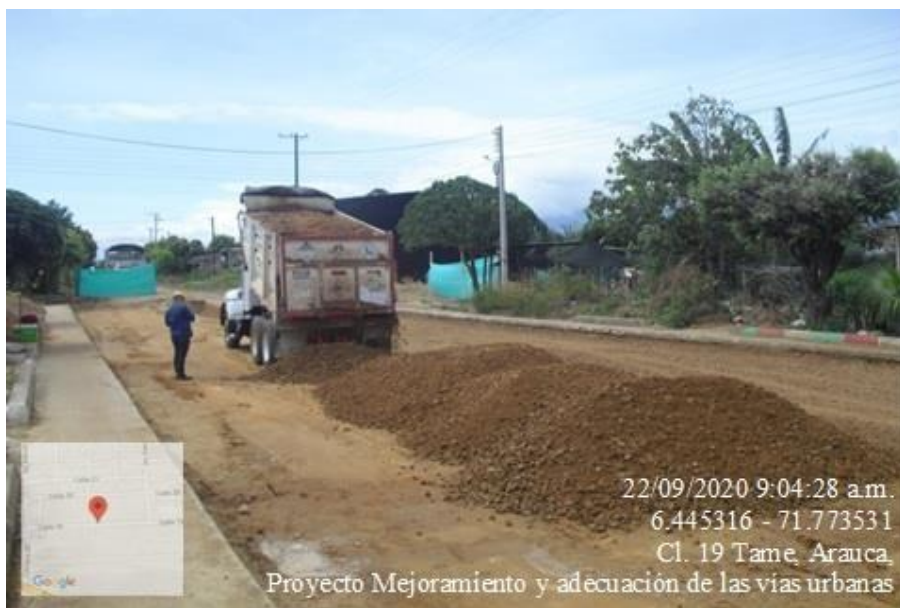
Ilustración 17. Subbase granular Fuente: Patiño Angie. 2021.
