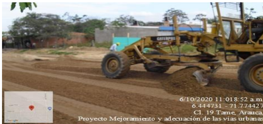
Ilustración 18. Base granular Fuente: Patiño Angie. 2021.
