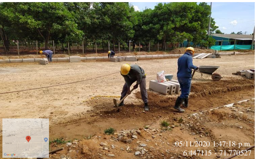
Ilustración 11. Excavación manual Fuente: Patiño Angie. 2021.
