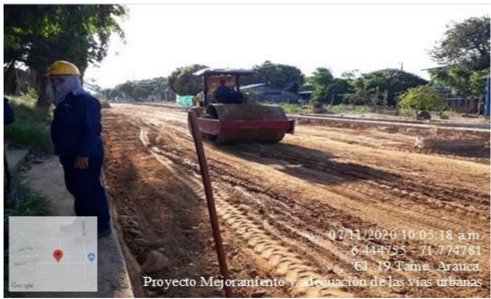
Ilustración 15. Compactación - Nivelación De Subrasante Fuente: Patiño Angie. 2021.
