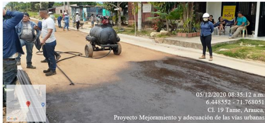
Ilustración 19. Riego de imprimación Fuente: Patiño Angie. 2021.
