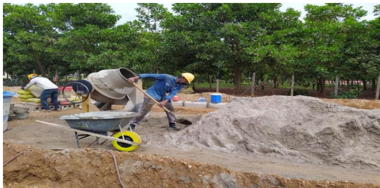
Ilustración 9. Mezcla de concreto 3.000 PSI Fuente: Patiño Angie. 2021.
