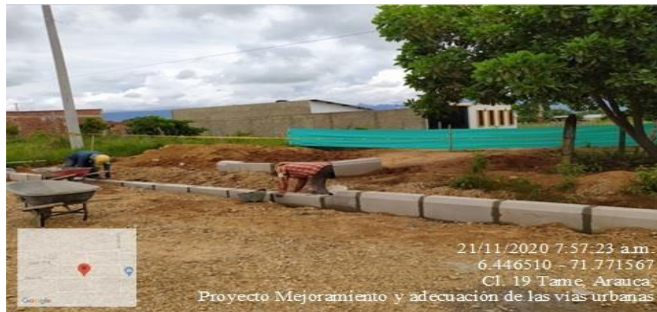
Ilustración 26. Instalación sardinell a-100 Fuente: Patiño Angie. 2021.
