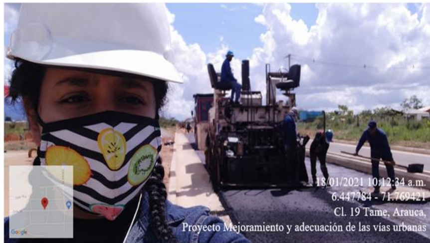
Ilustración 35. Instalación mezcla asfáltica Fuente: Patiño Angie. 2021.
