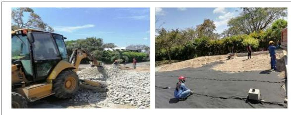
Nota. En la figura 16 se puede observar el proceso de relleno del cajón con piedra filtro y arena de pañete.
