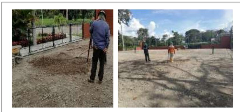
*Nota.* La figura 12 muestra el proceso de nivelación manual del terreno mediante corte y relleno con subbase granular.
