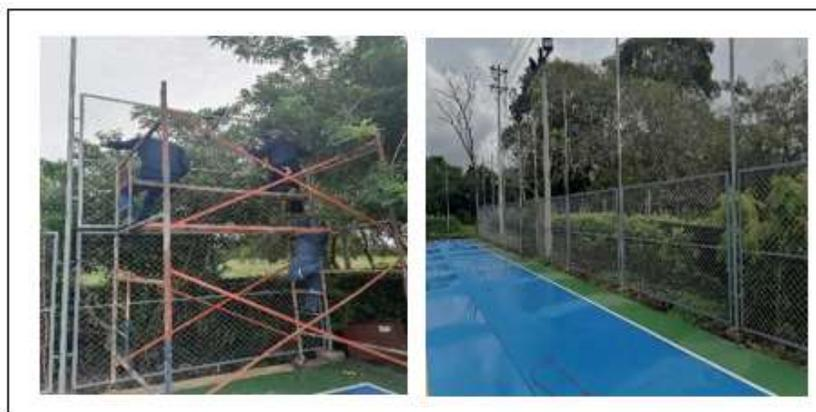
*Nota.* En la figura 28 se observa la cuadrilla de soldadura instalando los paneles de malla eslabonada para el cerramiento de cancha múltiple.
