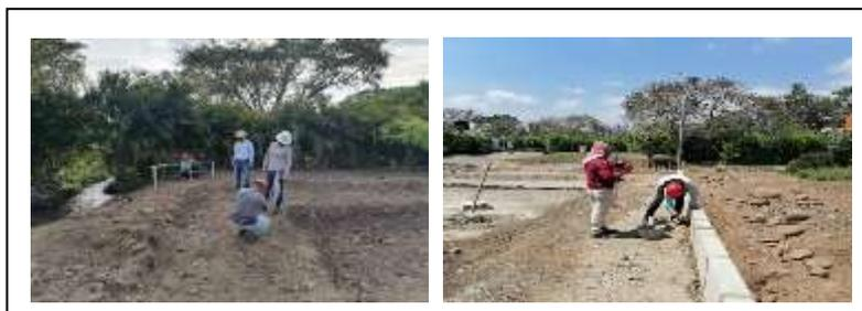
En la figura 13 se observa el control de excavación y la instalación de sardineles para el confinamiento de materiales que componen la estructura de cancha vóley playa.
