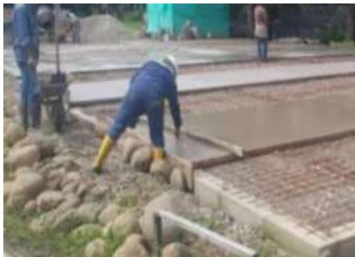
*Nota.* La figura 26 muestra el proceso de acabado o aplanado con llana, posterior al vaciado del concreto.
