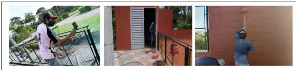
*Nota.* En la figura 4 se puede observar el proceso de pintura sobre muros de fachada, malla eslabonada y portones metálicos.
