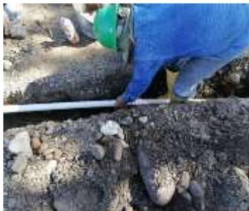
*Nota.* La figura 2 muestra la instalación de tubería para red hidráulica de cancha de tenis.
