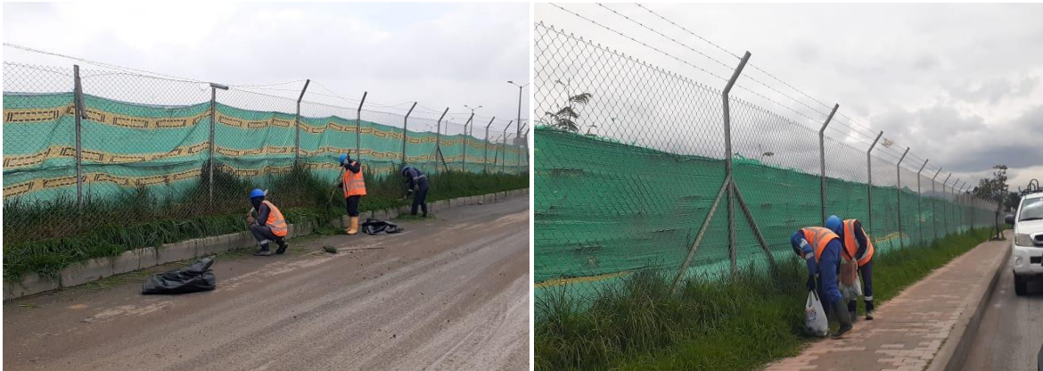
Imagen 18. Desmonte en frentes de obra
