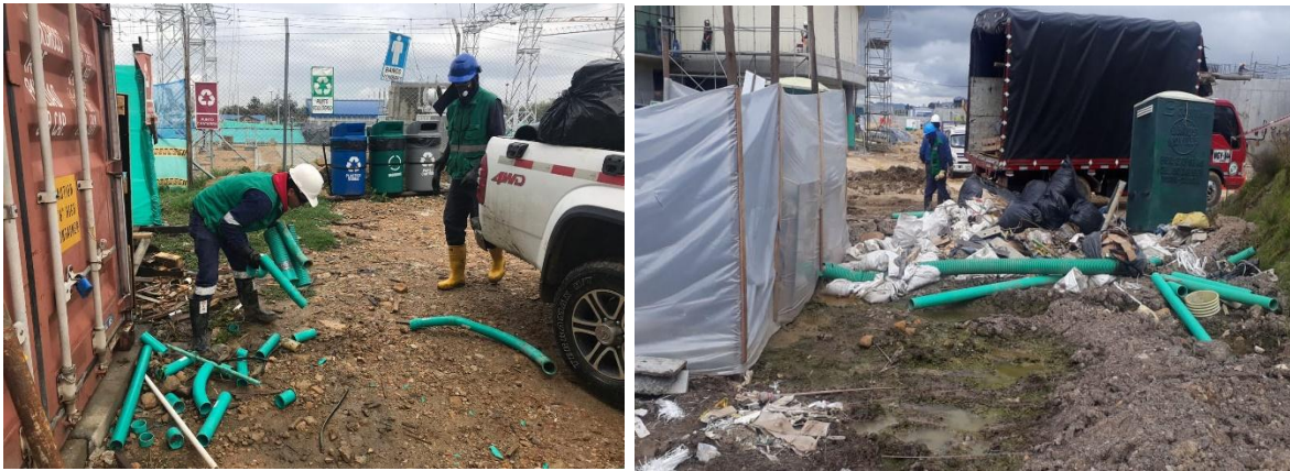
Imagen 22. Jornada de orden y aseo por Frentes de Obra.
