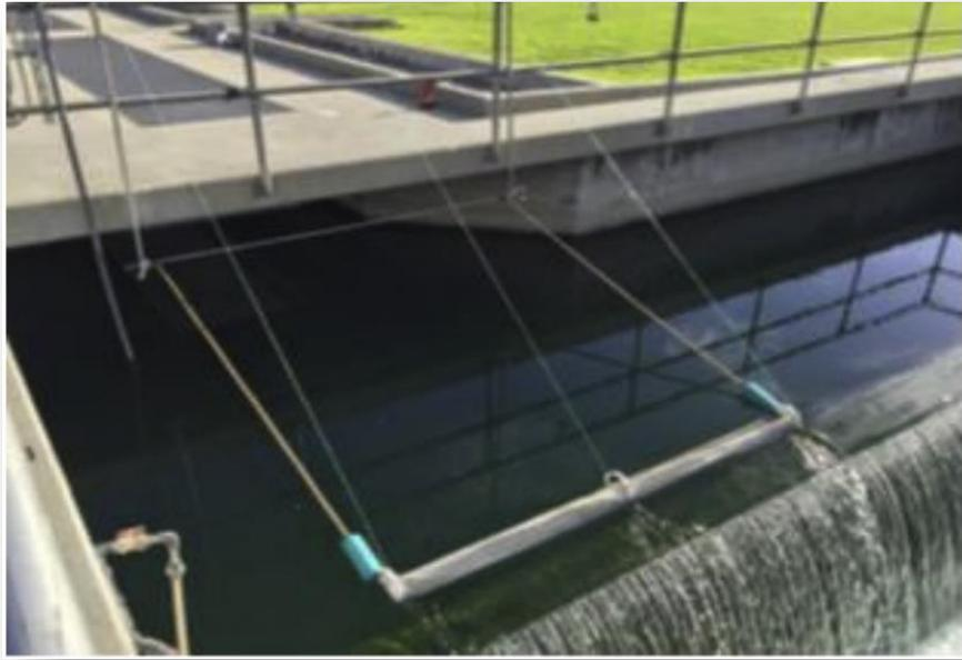
**Figura 9.** Colección de microplásticos utilizando un conjunto de filtrado de superficie.
