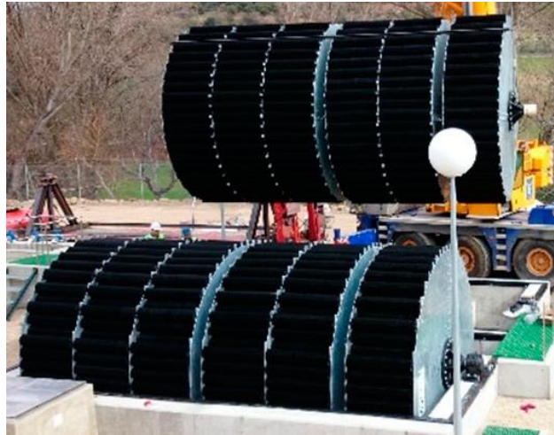
Figura 9. Medio de soporte fijo parcialmente sumergido para la formación de la biopelícula.
