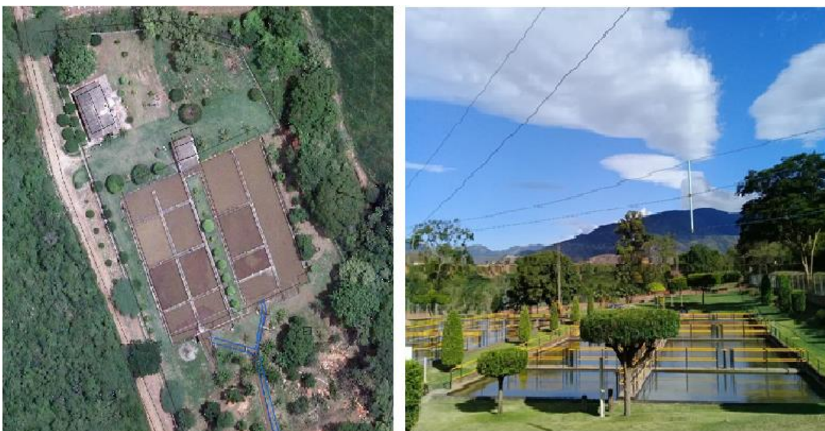
Ilustración 11 Desarenadores Río Pamplonita
