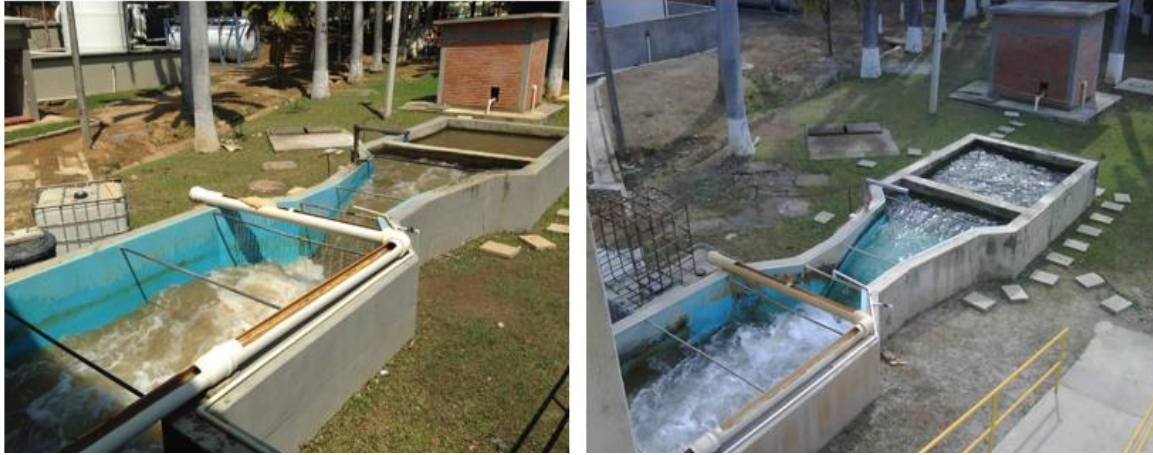
Ilustración 12 Canaleta Parshall PTAP El Pórtico Fuente: Autor, 2018
