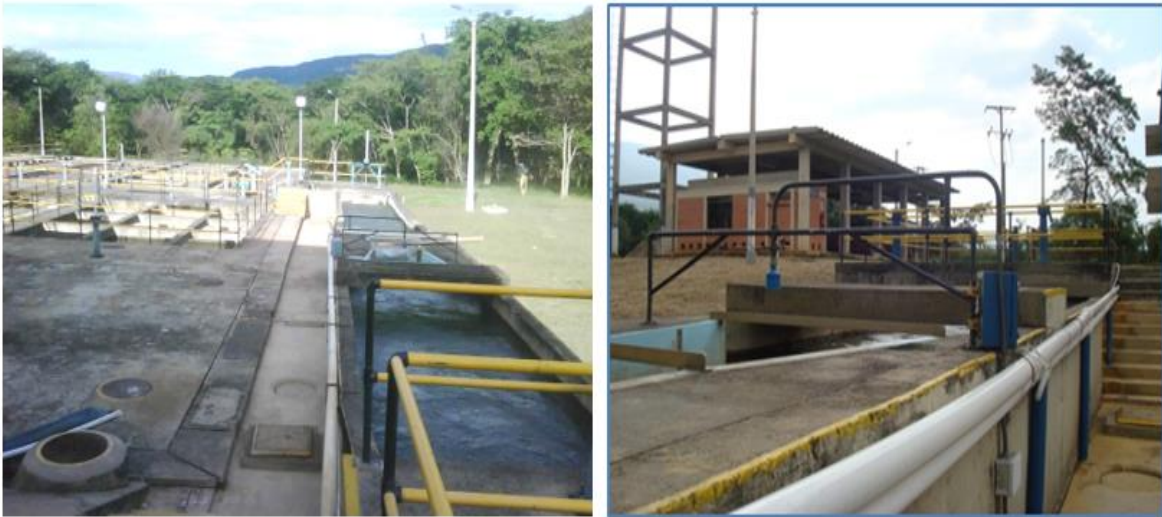
Ilustración 23 Coagulación y Mezcla Rápida PTAP Carmen de Tonchala Fuente: Aguas Kpital, 2017.
