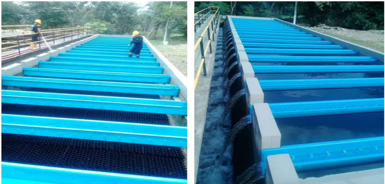
Ilustración 22 Sedimentación PTAP Carmen de Tonchala Fuente: Aguas Kpital, 2017
