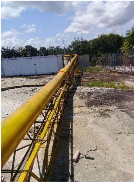
*Imagen 7. 99 Viaducto de Conducción a Tanque de Almacenamiento.*
