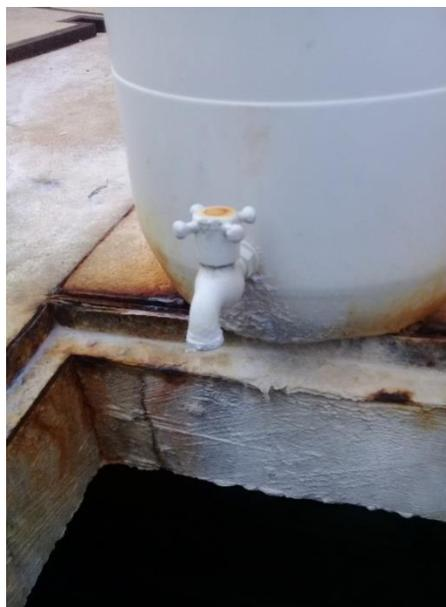
Imagen 7. 94 . Artefacto para la Adición de Cloro Disuelto (Goteo)
