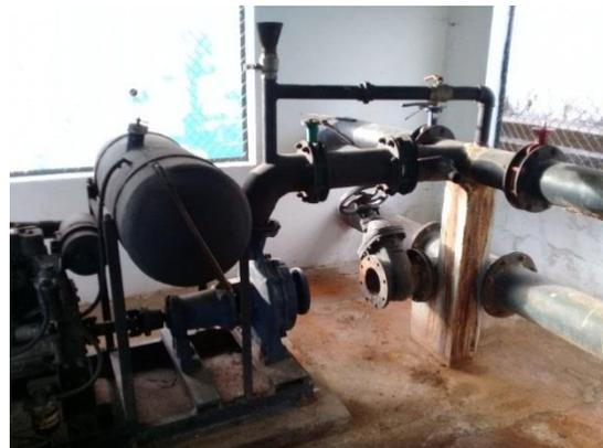
*Imagen 7. 117 Bomba de Impulsión Dañada 2.*
