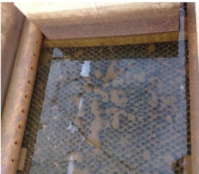
*Imagen 7. 70 Sedimentador de Alta Tasa (Forma Hexagonal).*
