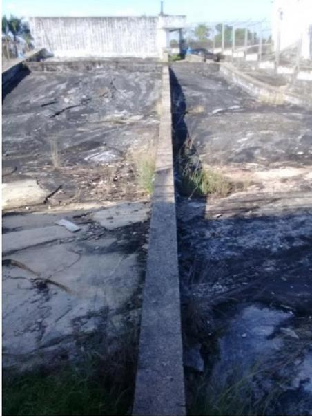
*Imagen 7. 37 Tubería de Purga del Desarenador.*
