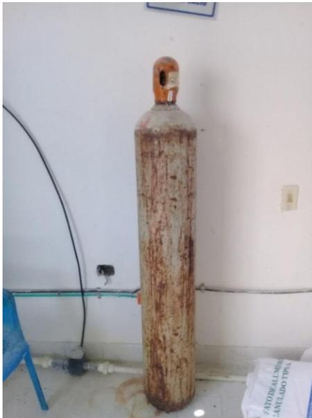
*Imagen 7. 91 Tanque de Cloro Gaseoso.*
