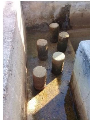
*Imagen 7. 66 Reductores de Velocidad en Salida del Floculador.*
