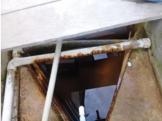
*Imagen 7. 55 Tubería de Dosificación de Coagulante y Regulador de pH.*
