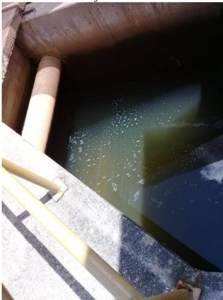
*Imagen 7. 82 Tubería de Recolección de Agua Filtrada*
