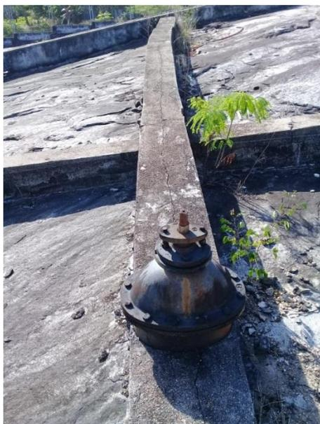
*Imagen 7. 29 Válvula Reguladora de Entrada al Bypass.*
