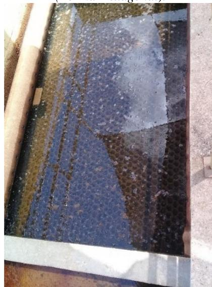
*Imagen 7. 73 Sedimentador de Alta Tasa (Forma Hexagonal).*
