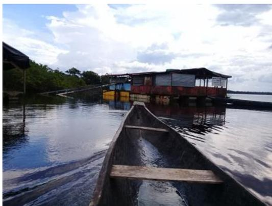
Imagen 7. 15 Barcaza Flotante de Captación
