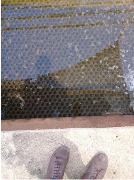
*Imagen 7. 74 Sedimentador de Alta Tasa (Forma Hexagonal).*
