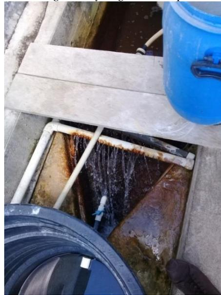
*Imagen 7. 58 Tubería de Dosificación de Coagulante y Regulador de pH.*
