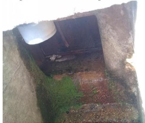
*Imagen 7. 40 Salida de Tubería de Purga del Desarenador.*
