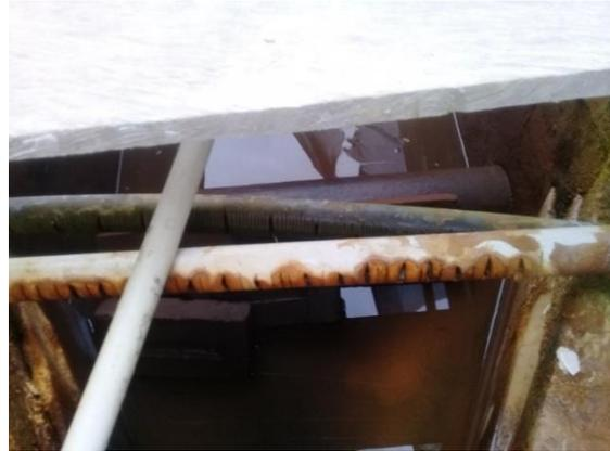
*Imagen 7. 56 Tubería de Dosificación de Coagulante y Regulador de pH.*
