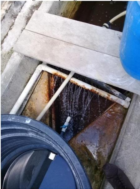
*Imagen 7. 57 Tubería de Dosificación de Coagulante y Regulador de pH.*
