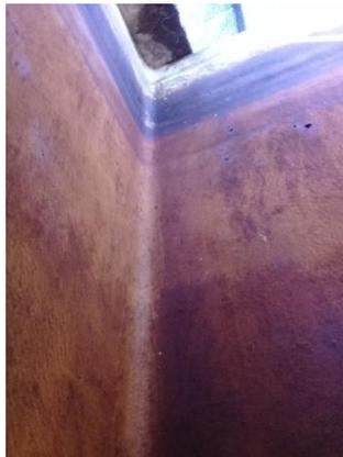
*Imagen 7. 67 Corrosión en paredes de Floculador.*
