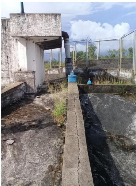
*Imagen 7. 28 Tubería de Aducción en Entrada a Desarenador.*
