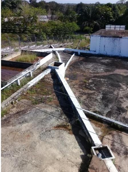
*Imagen 7. 110 Tuberías Conductoras al Lechos.*
