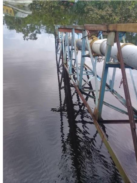
*Imagen 7. 22 Expansión de Tubería de 8 a 10'',
