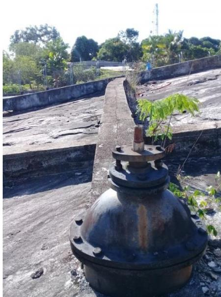
*Imagen 7. 31 Válvula Reguladora de Entrada al Bypass.*
