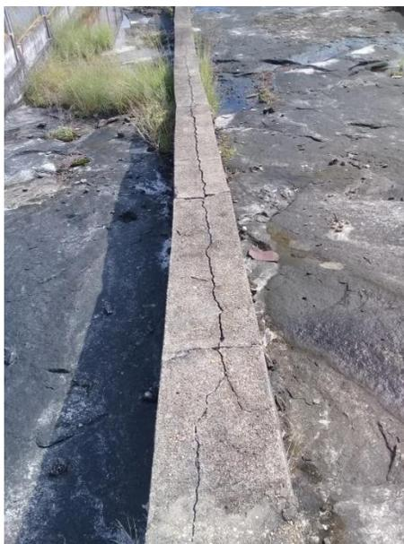
*Imagen 7. 26 Recubrimiento de la Tubería de Aducción a la Entrada de la PTAP.*
