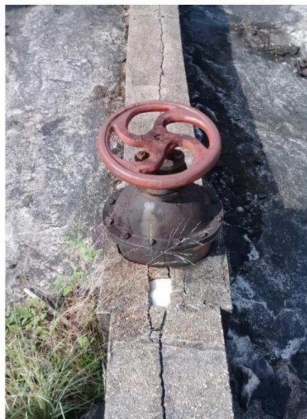
*Imagen 7. 27 Válvulas de Desviación hacia BYPASS en Caso de Emergencia*
