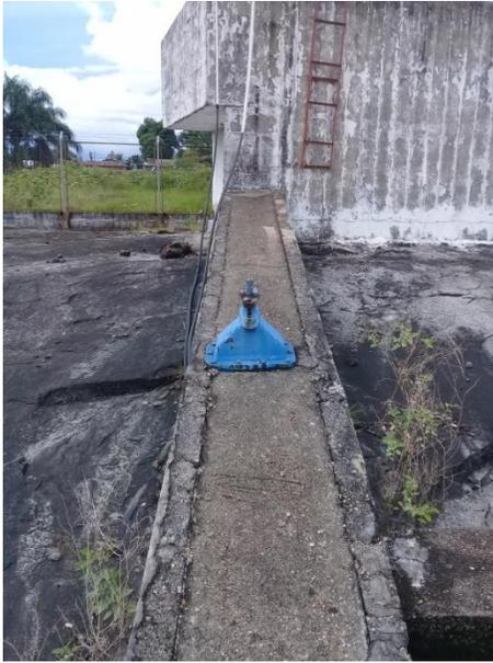
*Imagen 7. 41 Válvula Reguladora de la Tubería de Conducción.*
