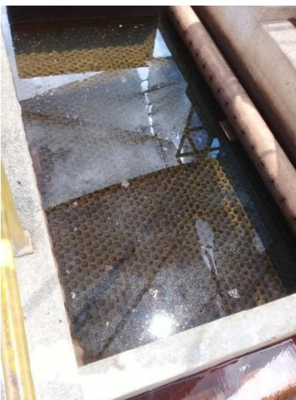
*Imagen 7. 72 . Sedimentador de Alta Tasa (Forma Hexagonal).*
