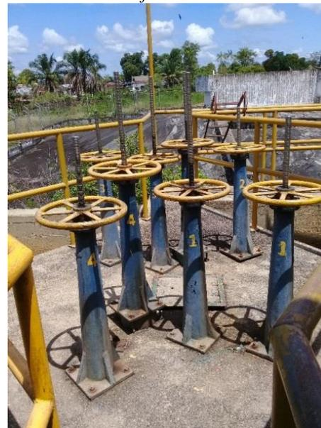
*Imagen 7. 84 Manojos de Válvulas de Control a Filtros.*
