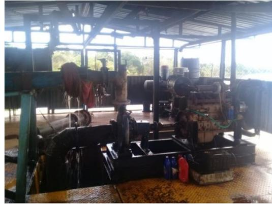
*Imagen 7. 18 Sistema de Succión de Barcaza Flotante de Captación.*
