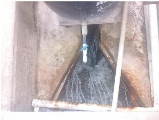
*Imagen 7. 59 Vista Superior del Mezclador Rápido.*
