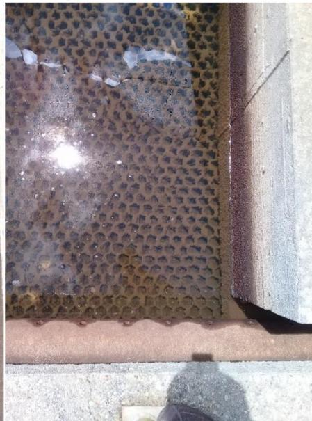
*Imagen 7. 71 Sedimentador de Alta Tasa (Forma Hexagonal).*
