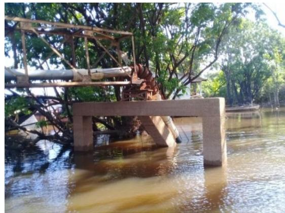
*Imagen 7. 20 Expansión de Tubería de 8 a 10'', Época Normal.*
