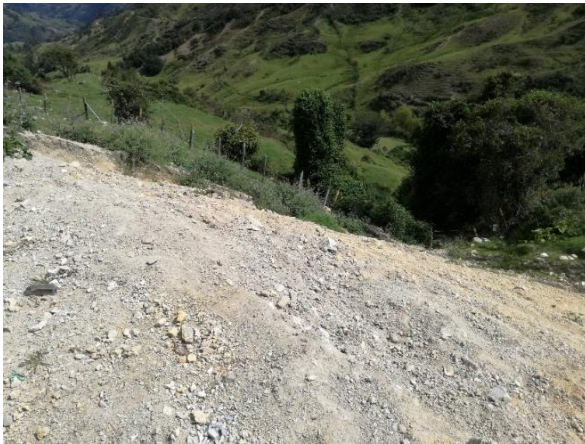
Imagen 13 material de excavación sin compactación Fuente: Angee Delgado
