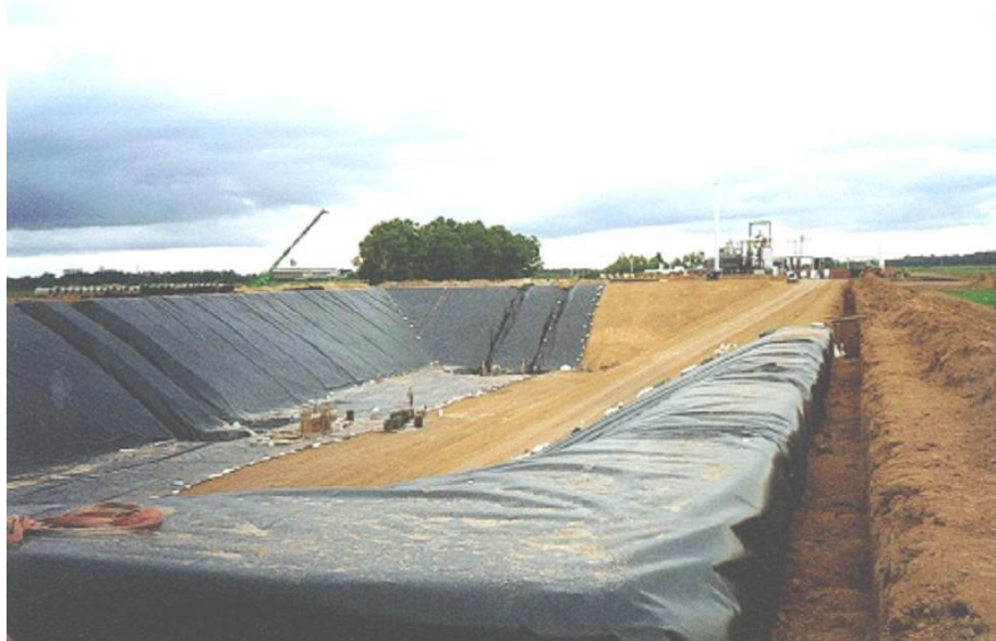
Imagen 4 Método en Área Plana. Fuente: Relleno Sanitario de Malleco. 2018
