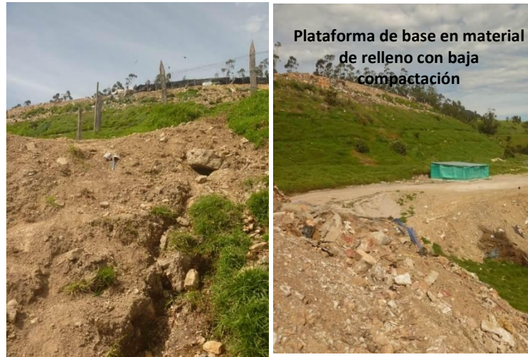
Imagen 14 base de la masa de residuos sin estabilidad Fuente: Angee Delgado
