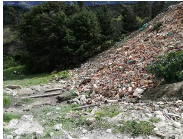
Imagen 13 material de excavación sin compactación Fuente: Angee Delgado
