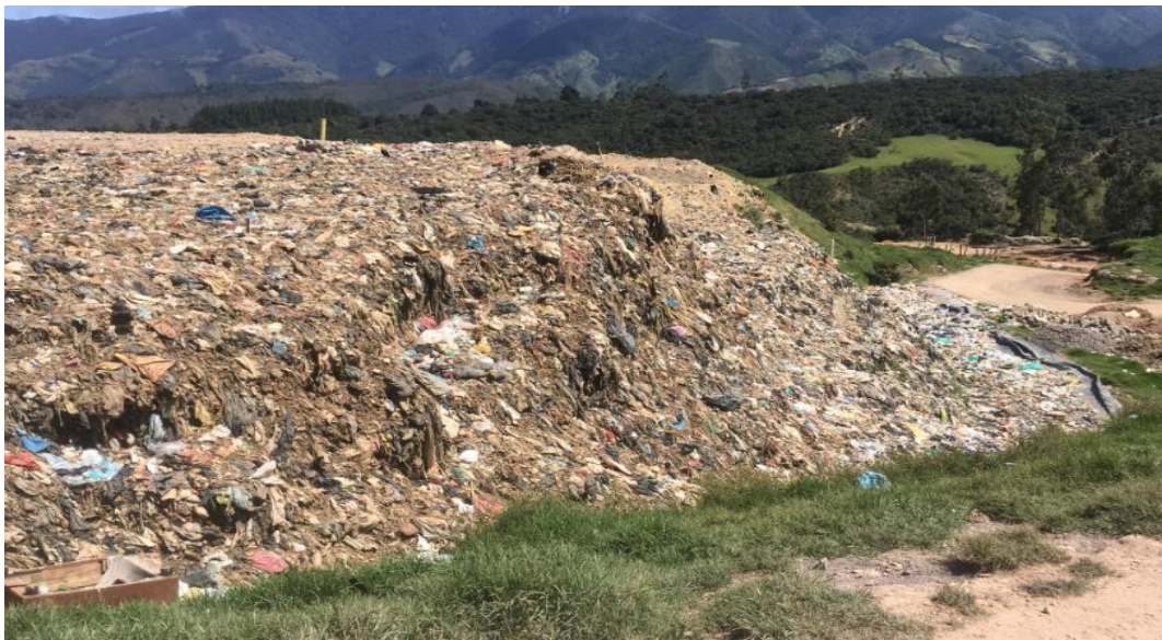
Imagen 11 No cobertura de los residuos sólidos dispuestos. Fuente: Angee Delgado
