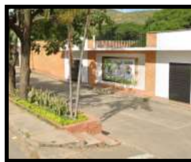
Imagen 1. Fachada Colegio Gimnasio El Bosque
