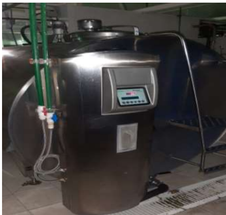
Figura 5. Tanque frío de la sala de ordeño.
