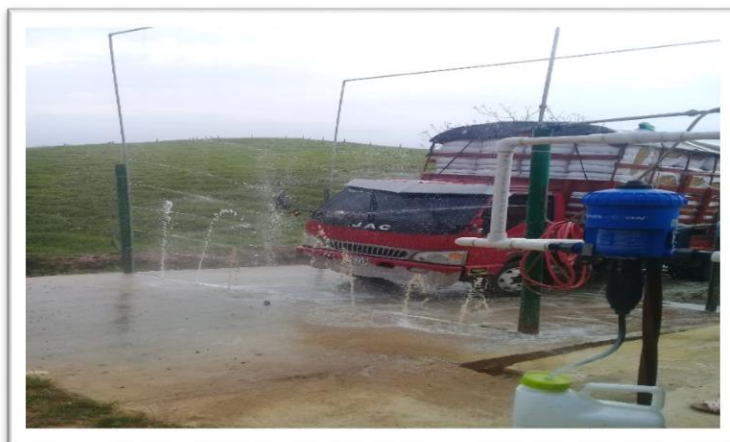
Figura 2. Arco de aspersion para desinfección para medios de transportes.
