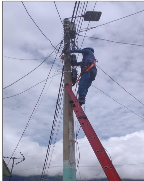
Figura 29. Instalación de cajas NAP en tramo Subiendo hacia Brighton – R22
