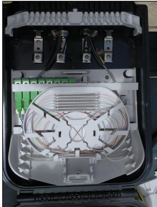
Figura 26. Caja Nap en buen estado
