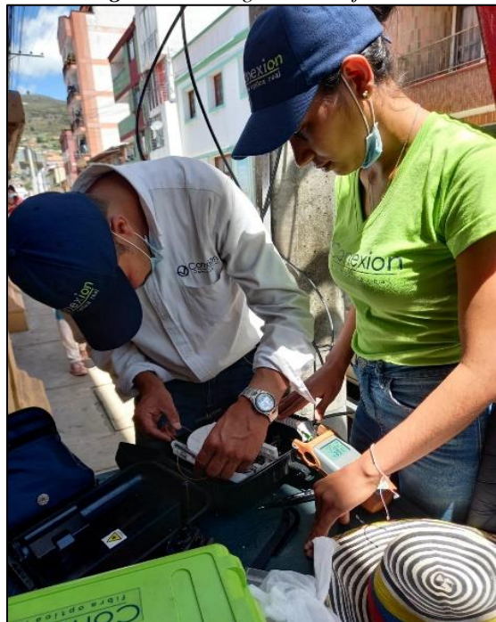
Figura 25. Arreglo de la caja NAP
