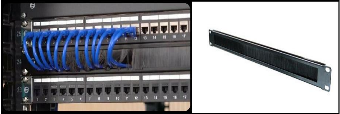
Figura 76 Panel Pasa cables con Cepillo para Armario Rack
