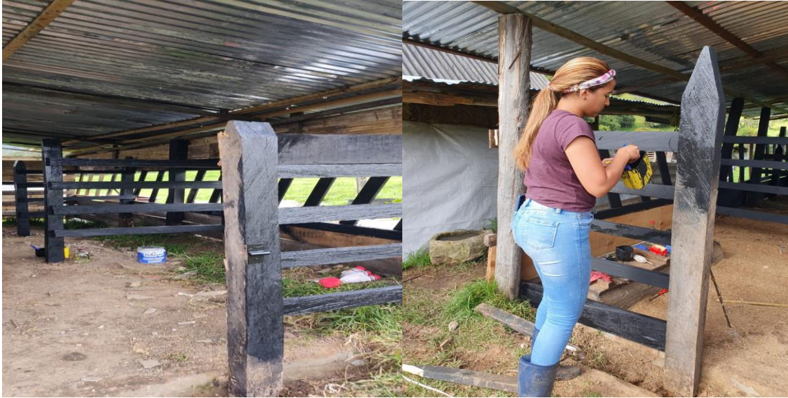
Imagen 3. Pesebreras en construcción.
