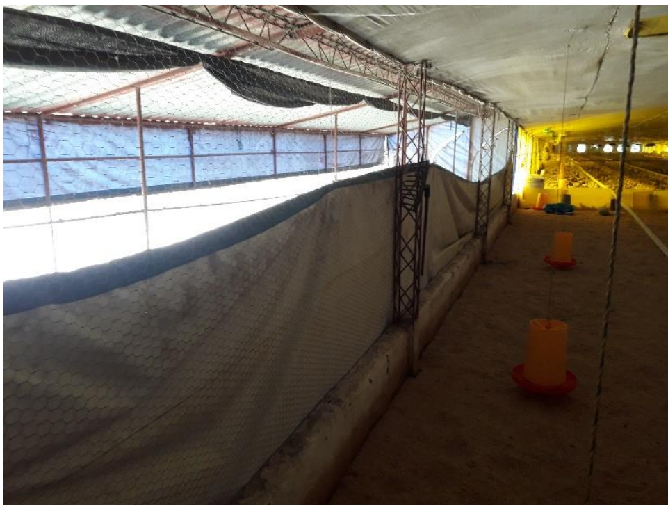
Figura 10. Cortinas laterales de la caseta que permiten el ingreso de aire.
