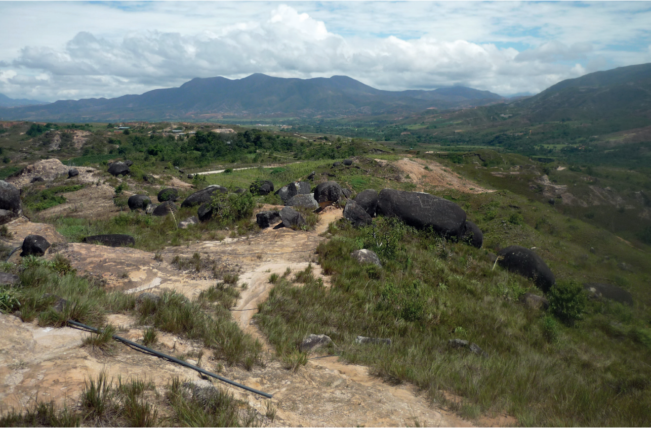
Figura 20 Fotografía panorámica del área de disposición de Piedras Negras
