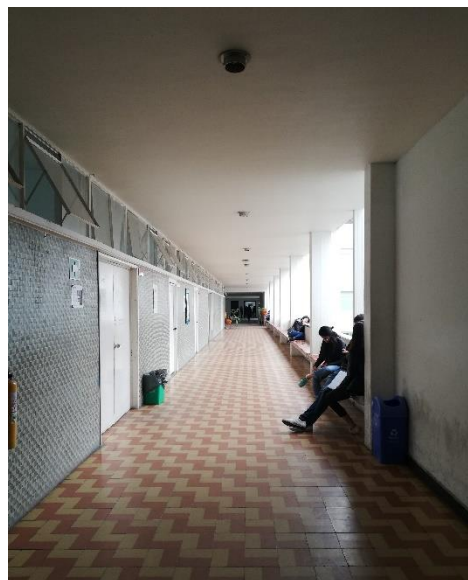
Figura 85. Ubicaciones Txi2, Txi3, Corredor Segundo Piso
