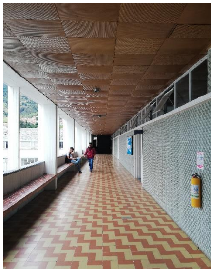
Figura 100. Ubicaciones Txi3, Txi4 Corredor Tercer Piso
