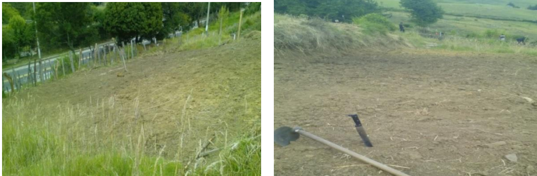
Imagen 4. Limpieza del terreno
