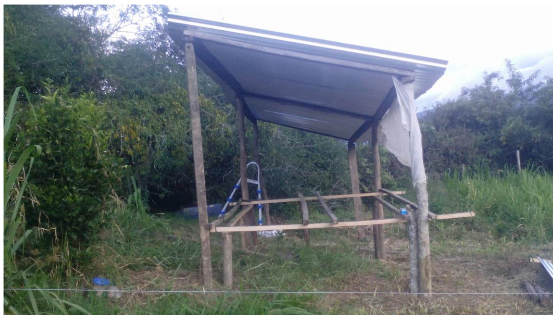
Figura N.18 Construcción de lombrizario
