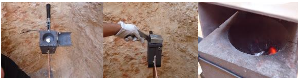
Figura 95. Ejemplo de unión de picas con el cable mediante fusión luminotécnica.
