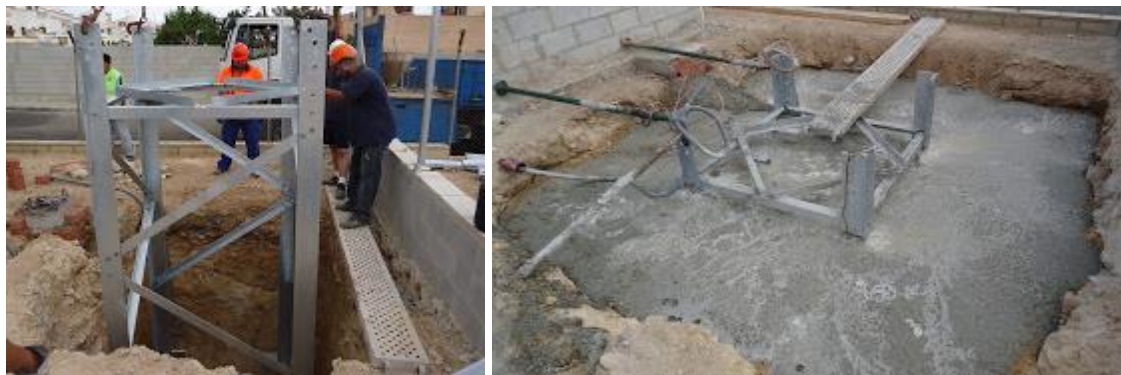
Figura 96. Ejemplo de Cimentación de la base de una torre.
