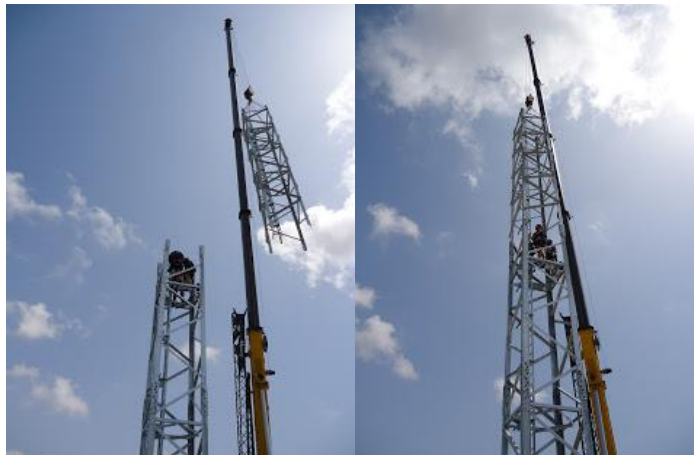
Figura 97. Ejemplo del montaje de los tramos de una torre de comunicaciones.
