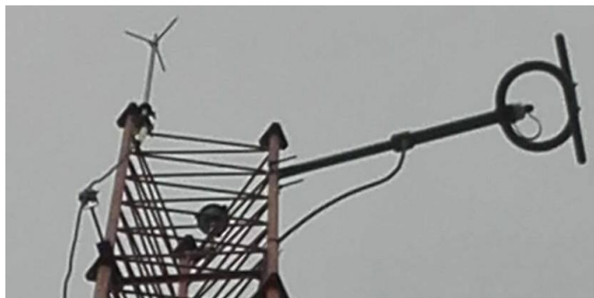
Figura 12 Antena RYMSA AT 12-200-4 usada en la estación de radio.
