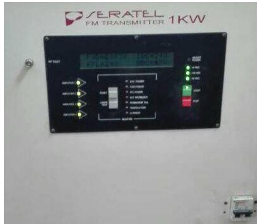
Figura 8 Trasmisor principal de frecuencia modulada SERATEL ST-504.1 usada en la estación de radio.
