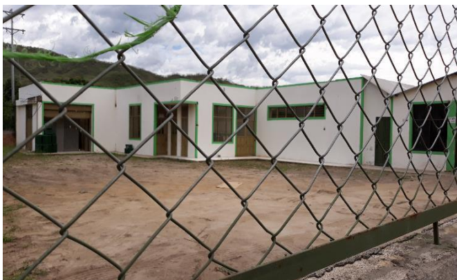
Anexo 9. Centro de acopio en vereda Vegas
