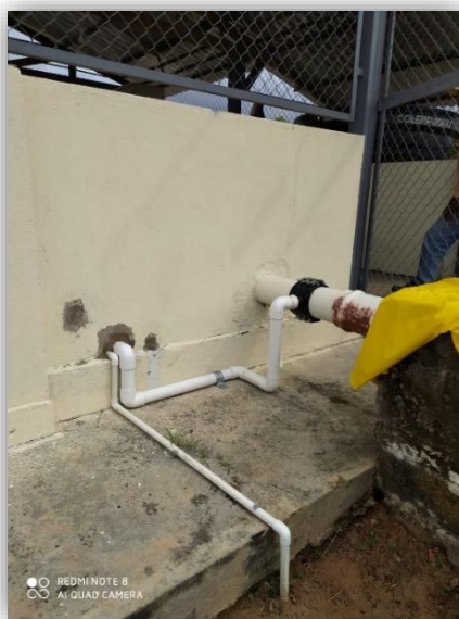
Figura 9. Inyección de la solución del fertilizante a la tubería mayor. Maquencal
