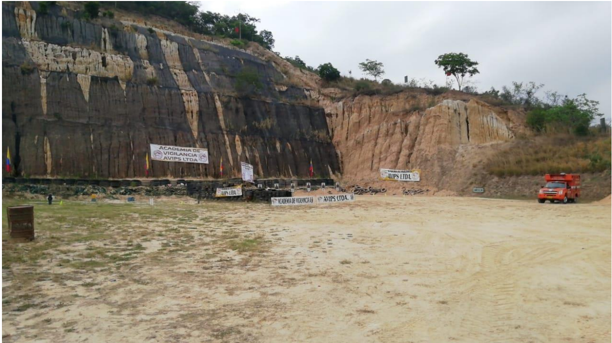
Anexo 11 Vista lateral de los paredones laterales
