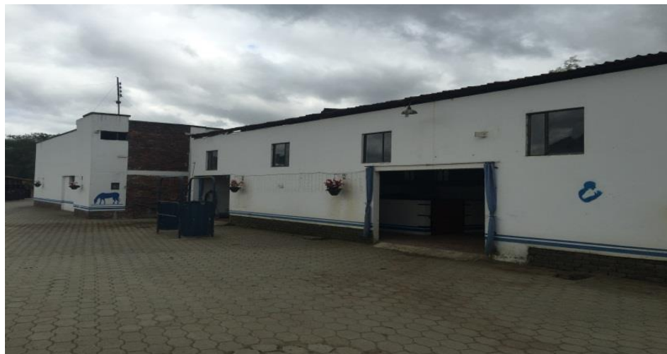
Figura 2 Entrada hospital, Clínica Equina. S.A.S. Fuente: Capacho, 2016.
