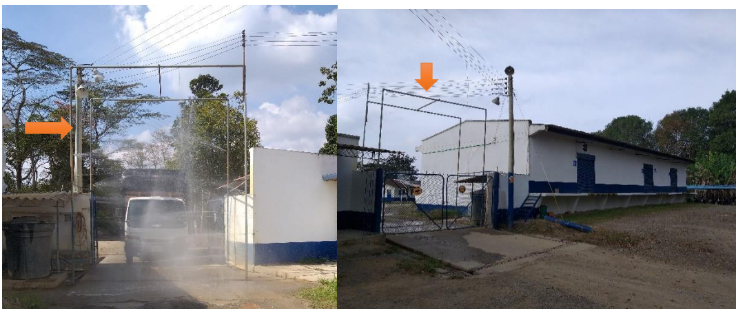
Figura 3. Arco de desinfección de vehículos. Fuente. Díaz 2019
