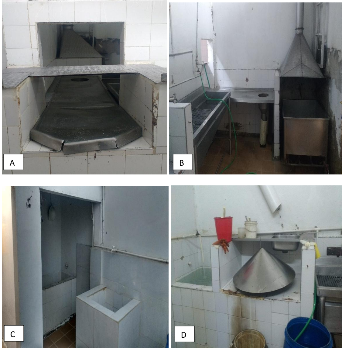
Figura 16. Área de vísceras blancas. (A) Tobogán donde caen las vísceras blancas luego de retirar del animal. (B) Mesa en donde se realiza el vaciamiento del contenido del sistema digestivo y caldera que contiene agua en ebullición para el escaldado del abomaso. (C) Área donde se realiza el desprendimiento del abomaso. (D) Campana de escaldado de abomaso. Fuente: Salvador 2019
