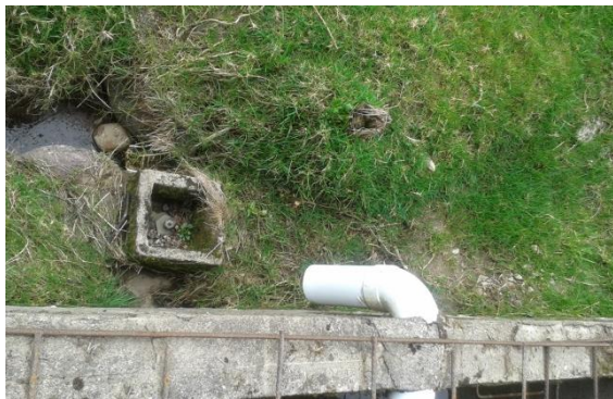
Figura 7. Vertedero Desarenador, distrito de riego ASOLAGUNA
