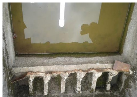
Figura 11. Tanque de distribución, distrito de riego ASOLAGUNA
