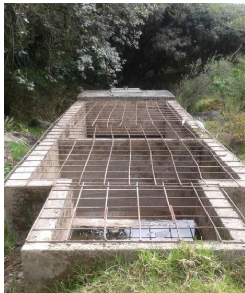
Figura 10. Desarenador distrito de riego. Fuente: Archivo personal
