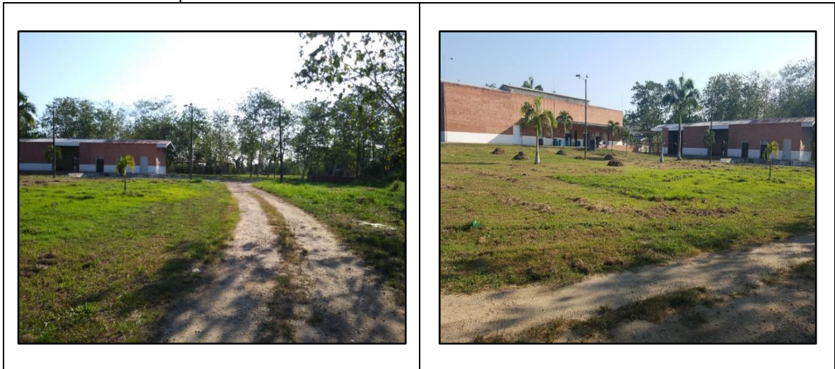
Ilustración 23. Vías sin pavimentación
