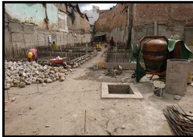
Figura 13. Terminación armado ábacos bloque C.
