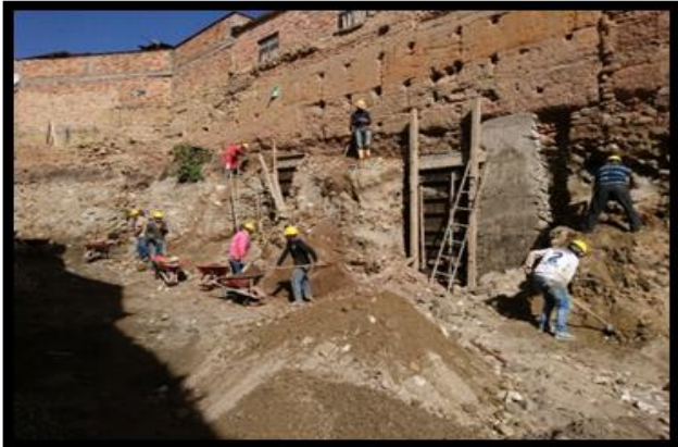
Figura 23 Armado pantallas de contención
