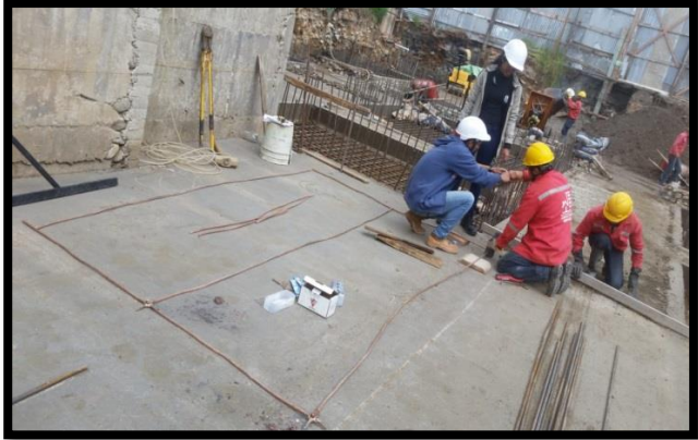
Figura 25 Instalación de malla para- rayos
