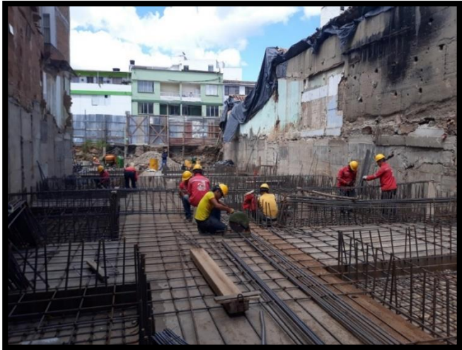
Figura 26 Armado de parrilla inferior.
