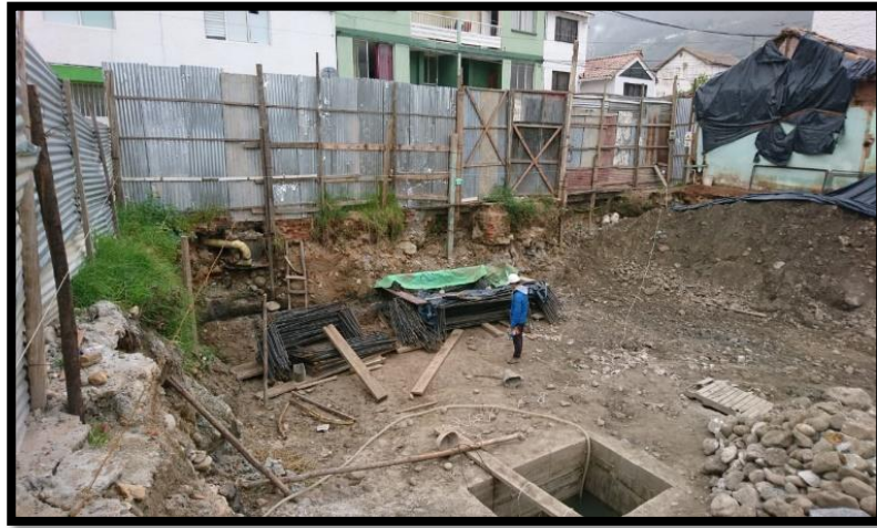
Figura 20 Reconocimiento de materiales de la obra.
