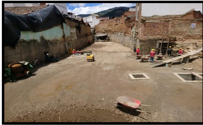
Figura 11. Compactación final del terreno
