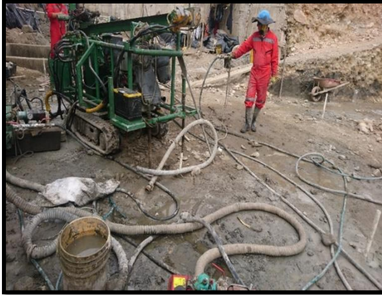
Figura 7. Inyecciones de consolidación. Fuente: Foto tomada por el autor
