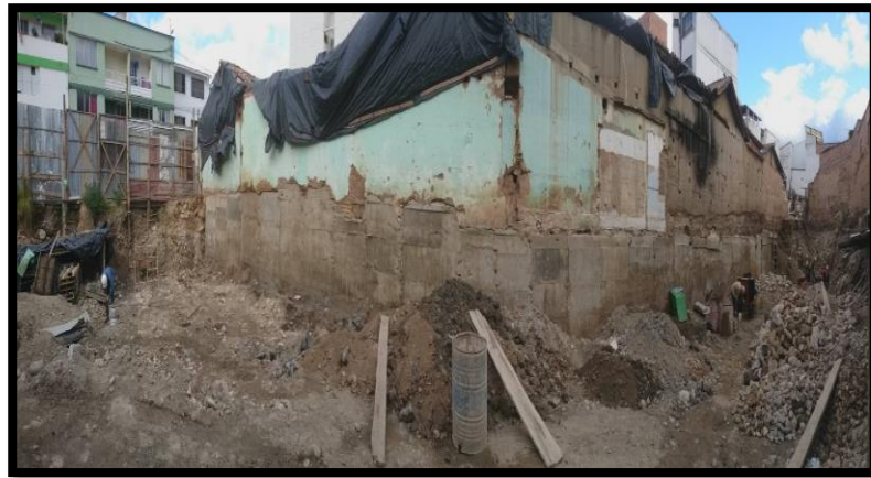
Figura 6. Terminación muros de contención
