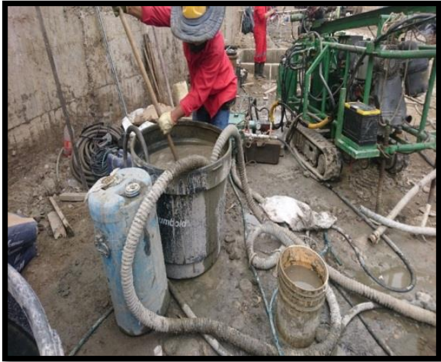
Figura 24 Preparación de la mezcla
