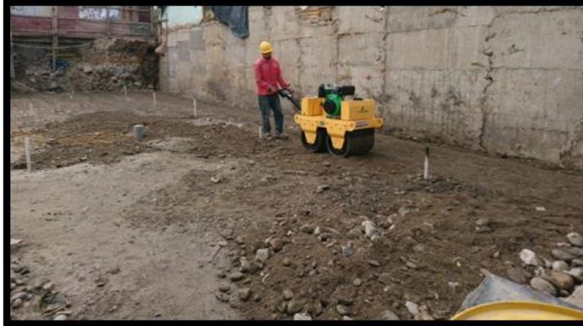
Figura 8. Compactación del terreno, Fuente: Foto tomada por el autor
