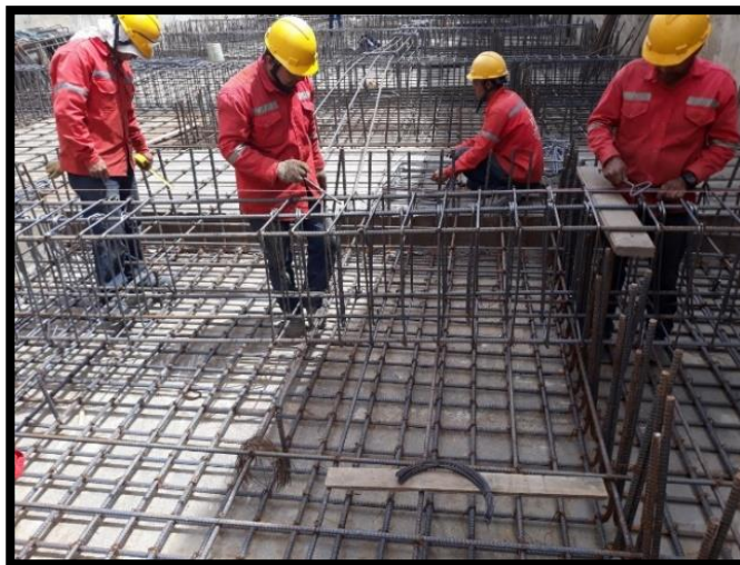
Figura 15. Viga de fundación
