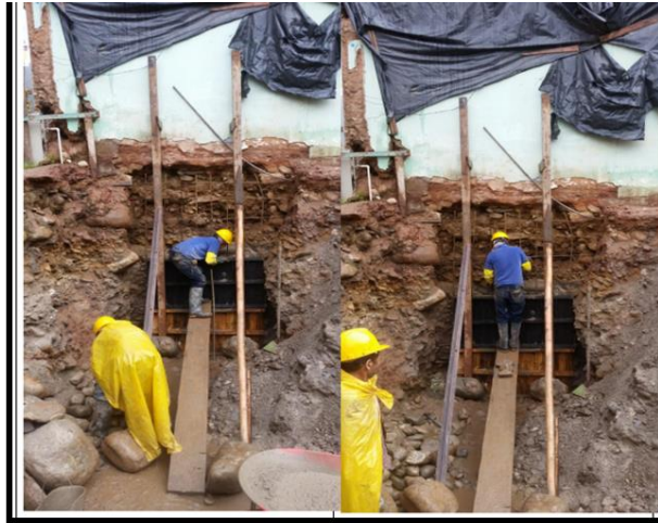
Figura 4. Pantallas de contención fuente autor
