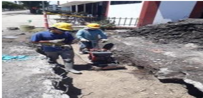
Figura 22 Relleno y Compactación
