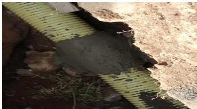
Figura 11 atraque de concreto
