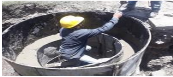
Figura 13 Pozos de Inspección de 120 Diámetro Interno
