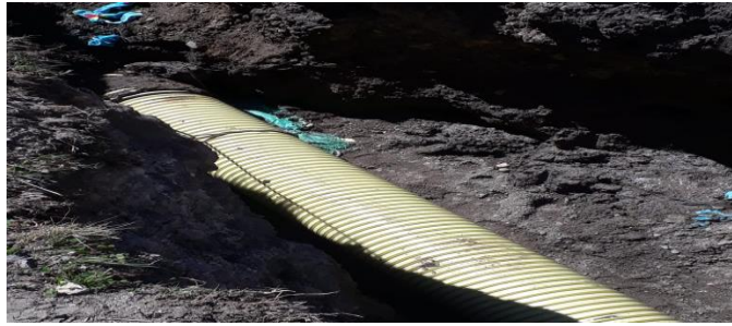
Figura 10 instalación de tubería
