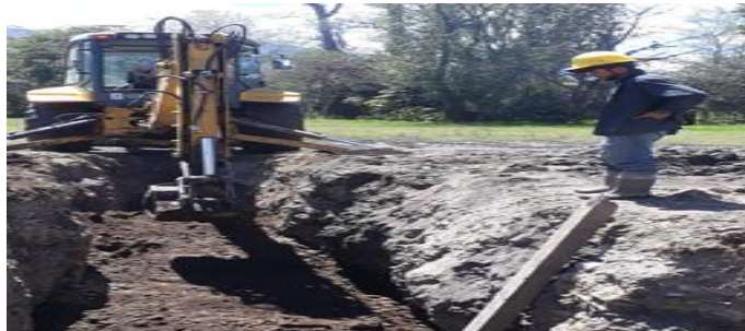
Figura 14 Relleno Compactado con Material Seleccionado
