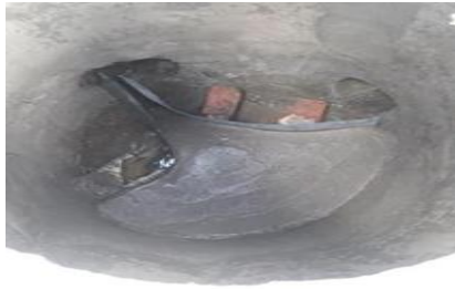
Figura 16 Construcción de Cañuelas
