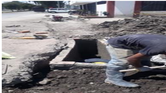
Figura 21 Construcción Caja de Inspección
