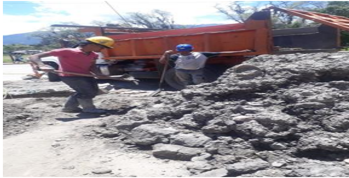
Figura 7 excavación manual
