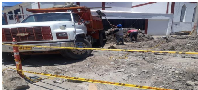
Figura 5. cerramiento con cinta
