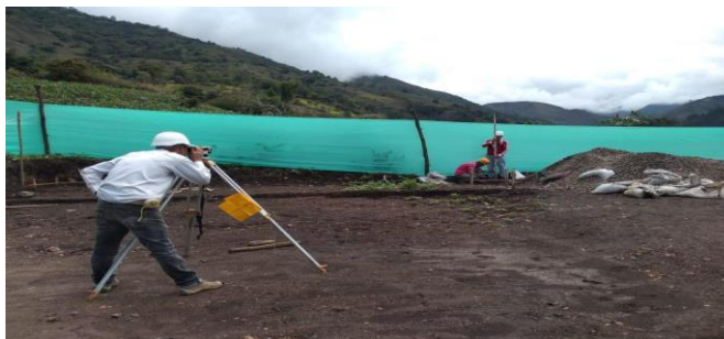
Figura 4 Replanteo topográfico
