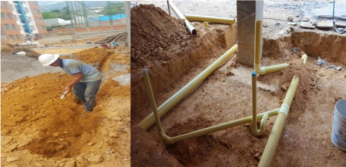
*Figura 14. Excavación para desagüe de sanitaria y de aguas lluvias.*
