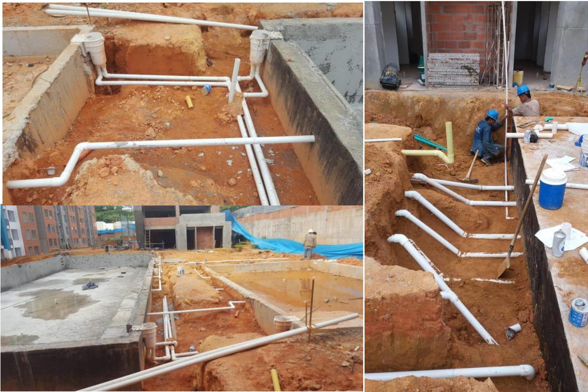
*Figura 19. Conexión redes de desnatadores, inyectoros y aspiradoras para la piscina.*
