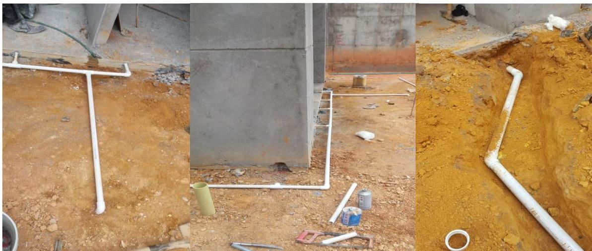
*Figura 23. Redes superficiales y con excavación.*
