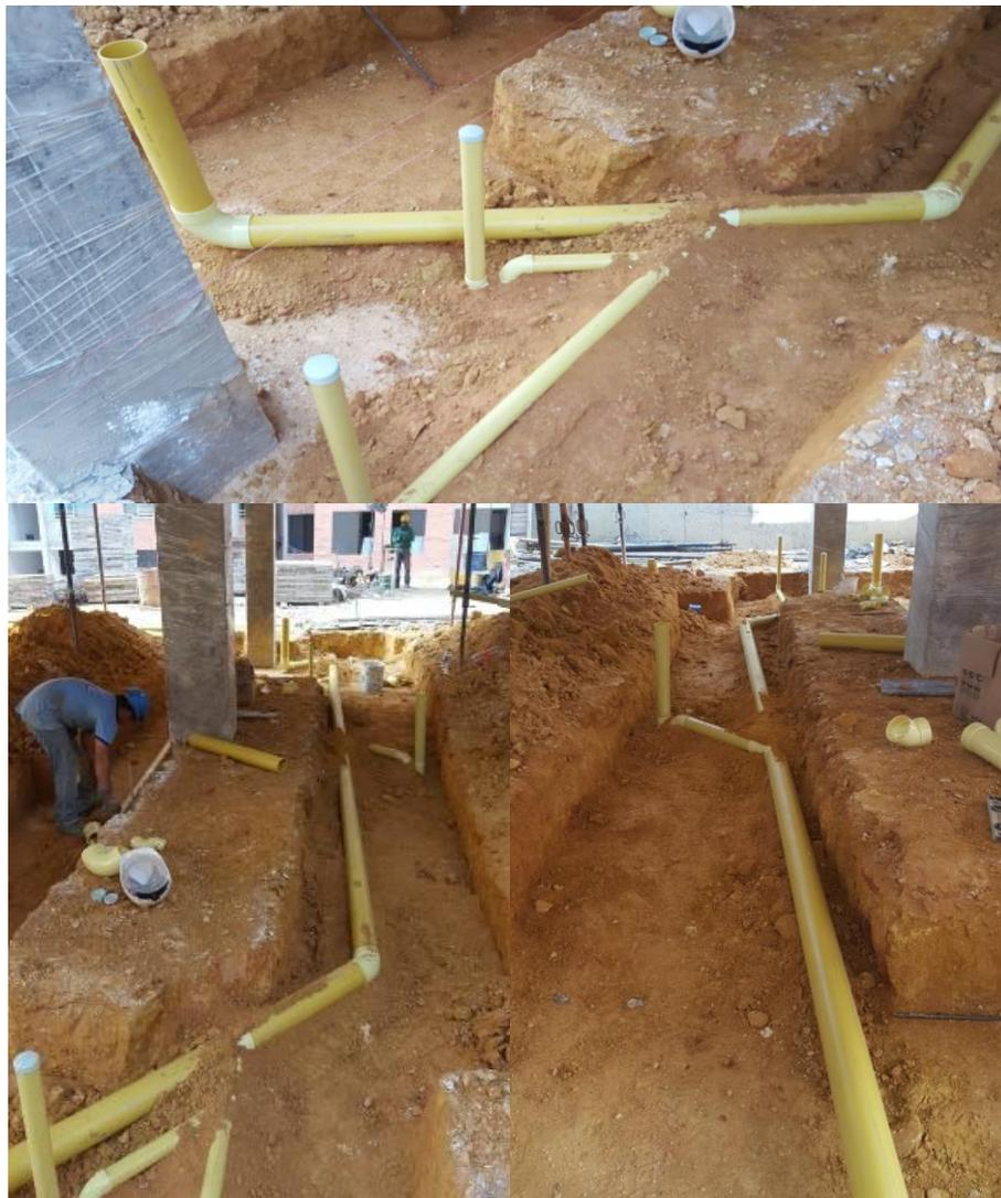
*Figura 15. Red de desagüe de sanitaria y de aguas lluvias.*
