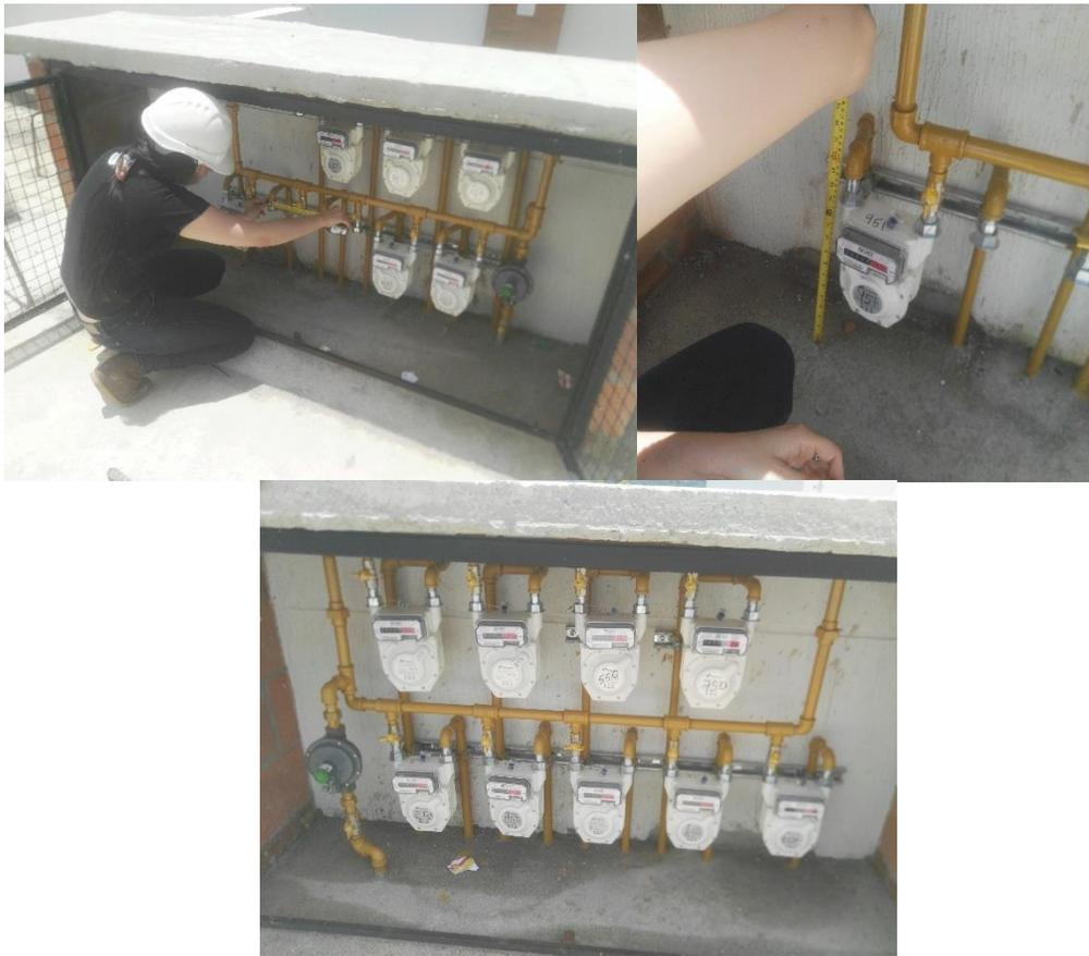
*Figura 24. Comprobando medidas de las flautas según la norma.*
