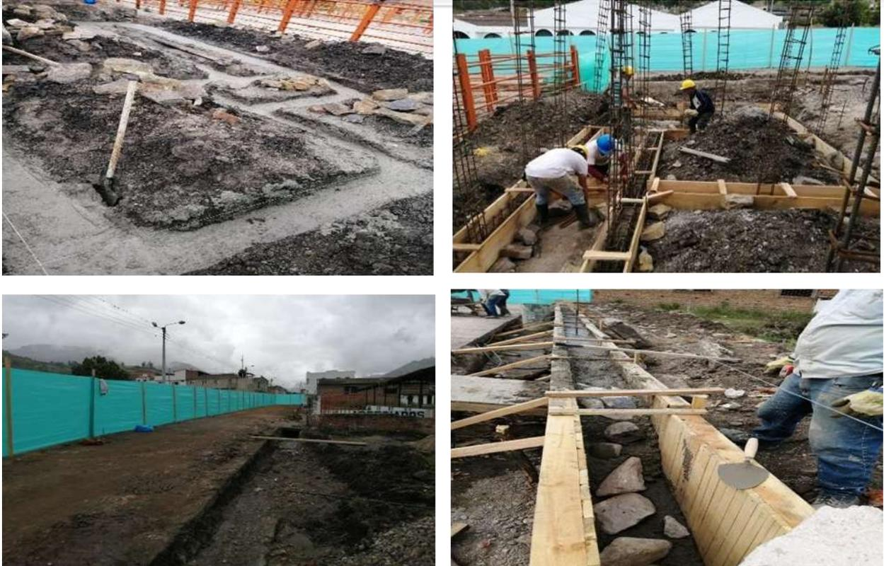
Figura 10. Concreto ciclópeo, encofrado viga de cimentación, cerramiento en lona verde. (elaboración propia Mejía, 2019)
