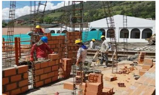
Figura 11. Instalación tubería sanitaria, hidráulica; mampostería, nivelación tubería metálica. (elaboración propia Mejía, 2019)
