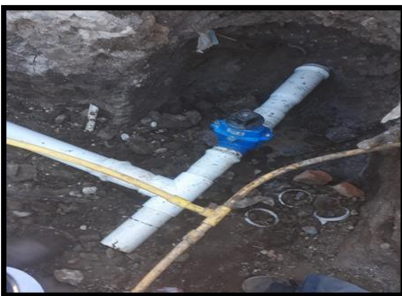
Ilustración 12. Instalación de accesorios en red de acueducto
