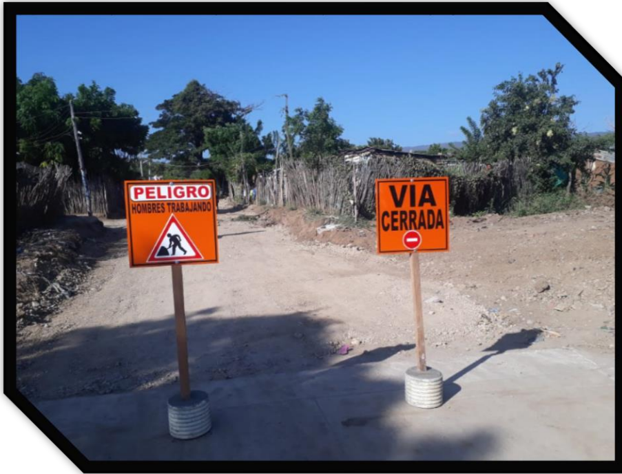
Ilustración 7. cerramiento y colocación de vallas de prevención
