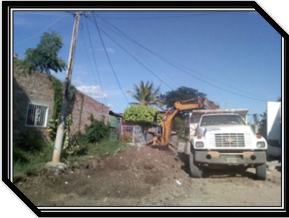
Ilustración 8. Acarreo del material sobrante en obra
