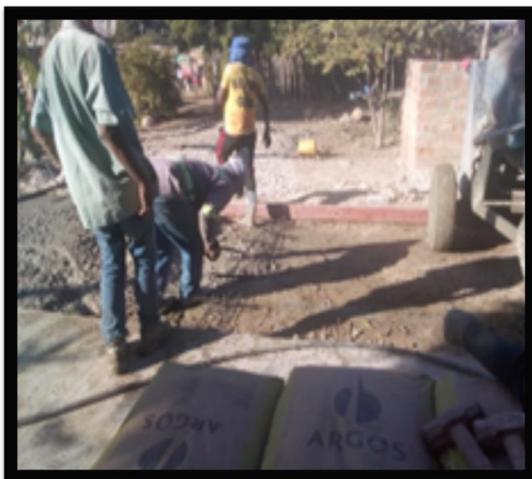
Ilustración 22. pavimentación e instalación de acero de transferencia de cargas
