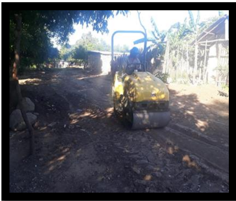
Ilustración 19. Compactación del terreno con vibrocompactador tipo rodillo
