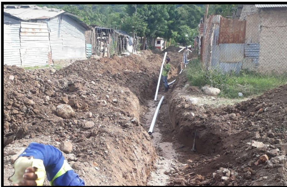
Ilustración 10. instalación de red de acueducto seguidamente de la capa de arena
