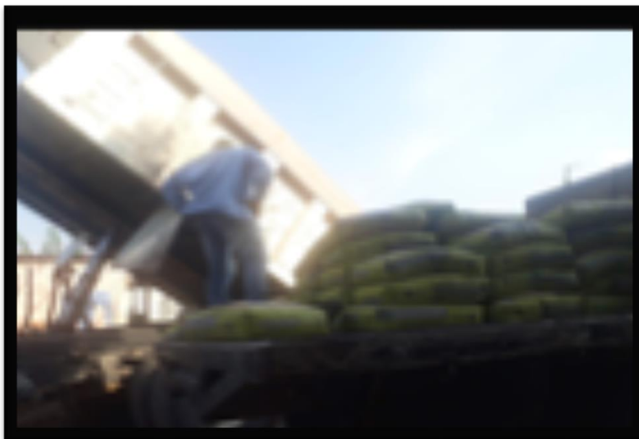
Ilustración 32. almacenamiento colocado en los frentes de trabajo
