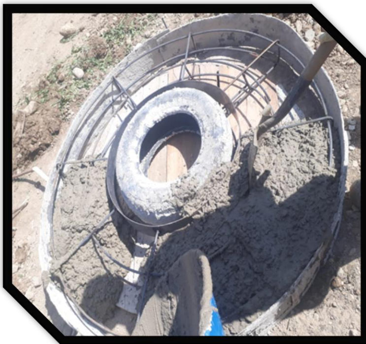
Ilustración 14. Estructura metálica de tapas y construcción de pozos
