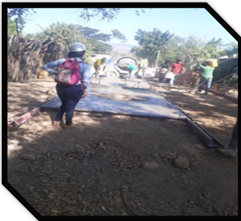
Ilustración 21. supervisión en la actividad de pavimentación
