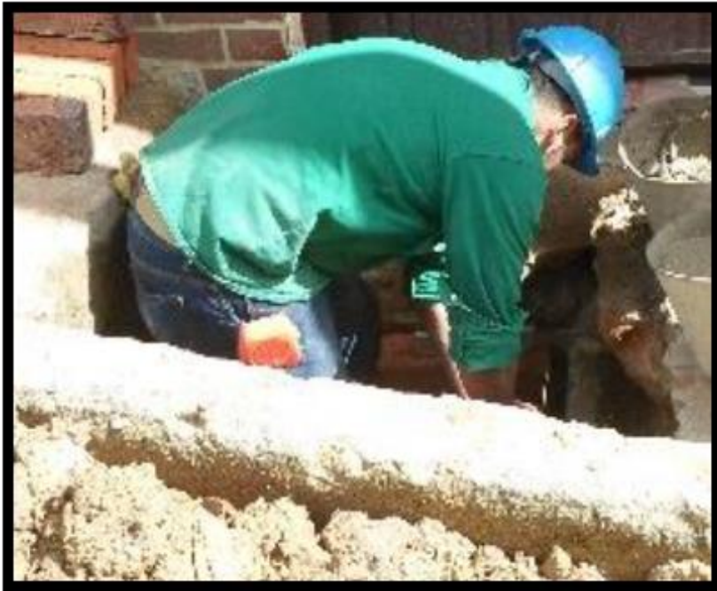
Ilustración 15. construcción de cajas de inspección
