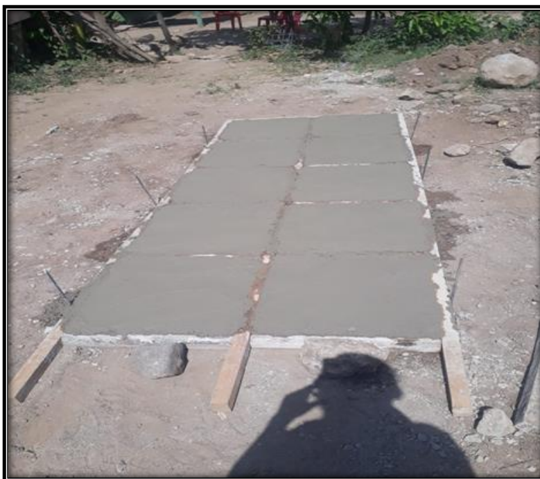
Ilustración 16. construcción de tapas para cajas de inspección
