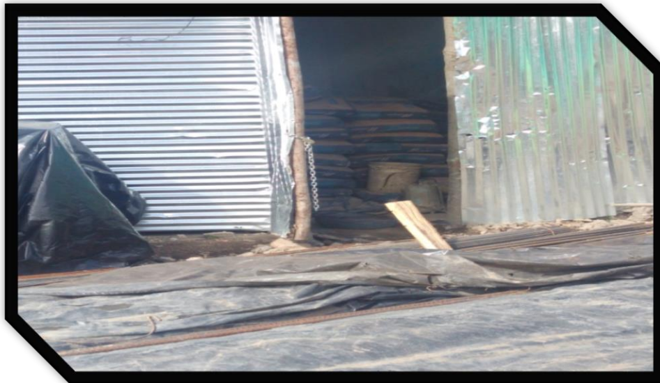
Ilustración 31. Almacenamiento Provisional de Materiales con un Contorno Cerrado
