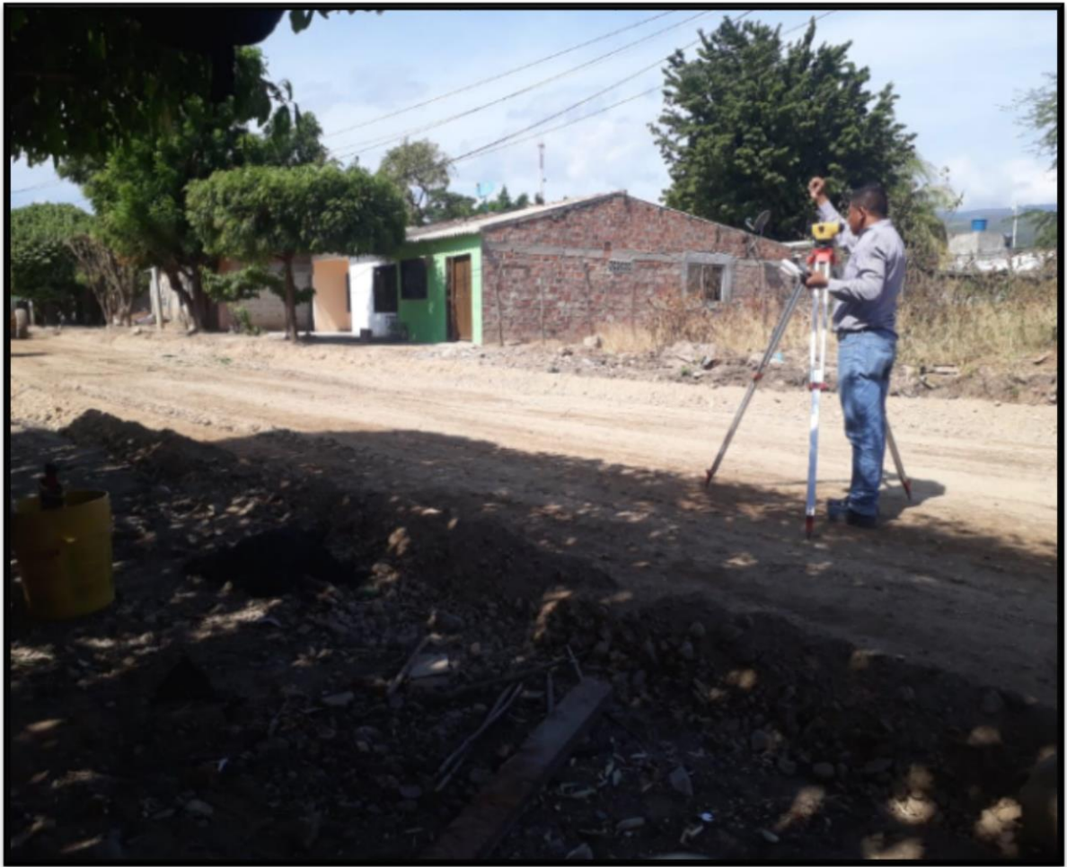
Ilustración 5. Localización y replanteo del terreno
