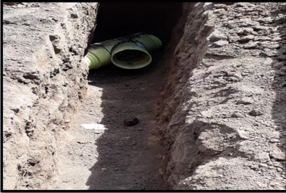
Ilustración 13. Instalación de red de alcantarillado
