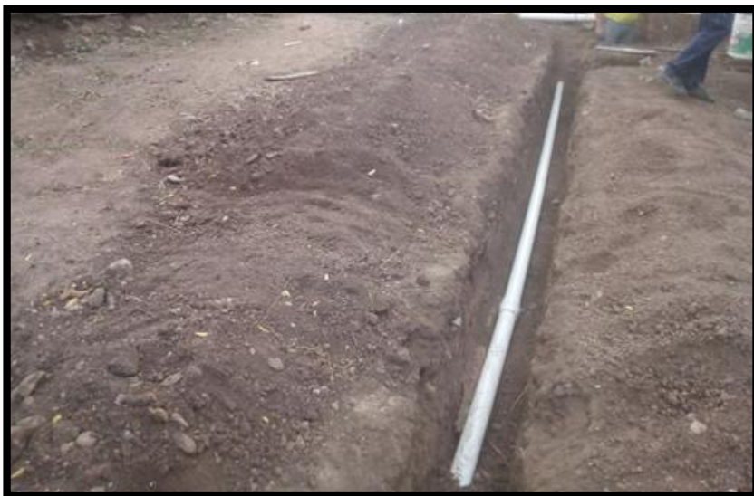
Ilustración 11. Instalación de red de acueducto
