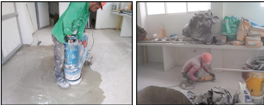
Figura 20. Pulido del granito
