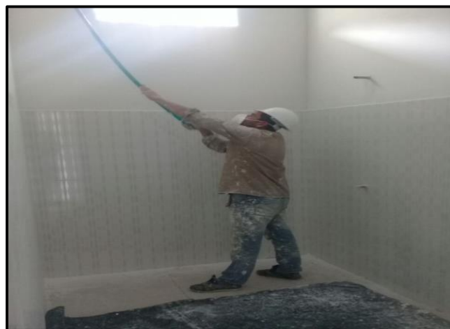
Figura 14. Pintura de interiores
