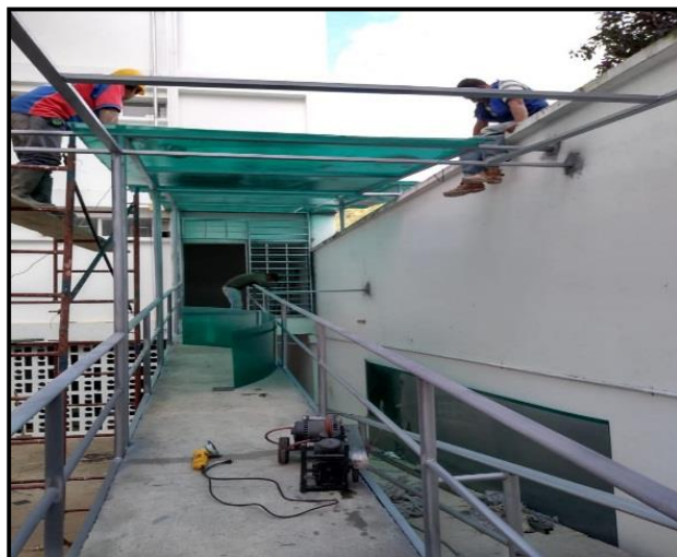
Figura 30. Cubierta para rampa
