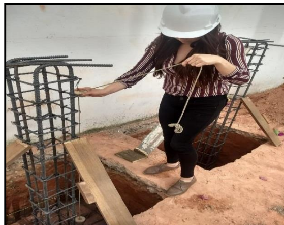
Figura 26. Verificación Verticalidad del refuerzo
