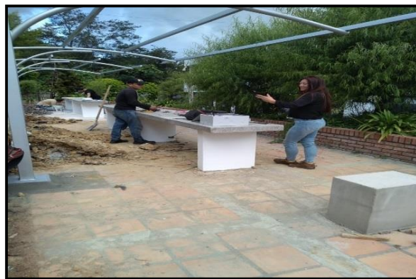
Figura 7. Instalación salida de toma 110v
