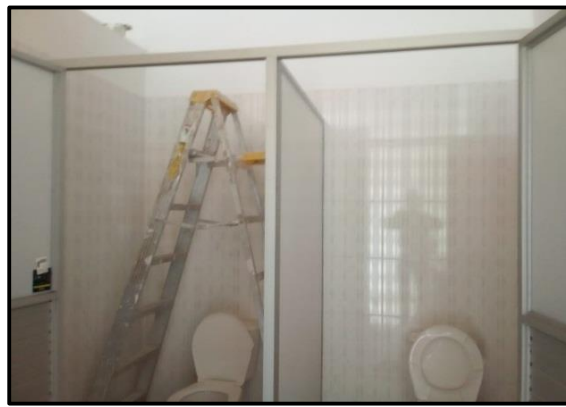
Figura 16. Instalación de divisiones metálicas
