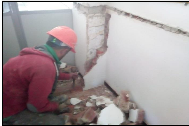
Figura 3. Demolición de mampostería
