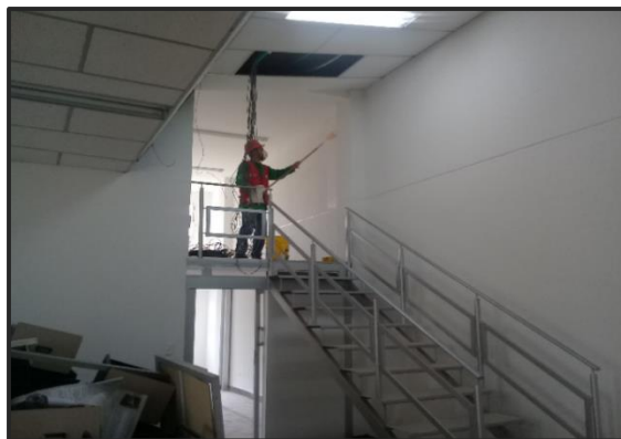
Figura 10. Pintura de interiores
