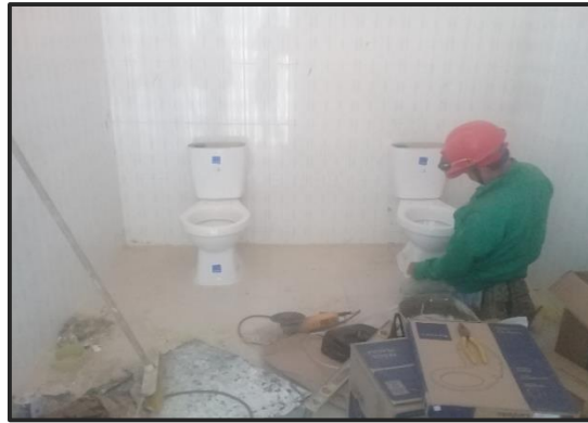
Figura 15. Instalación de sanitarios
