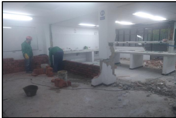
Figura 4. Muro en ladrillo
