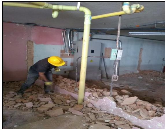
Figura 25. Demolición de mampostería
