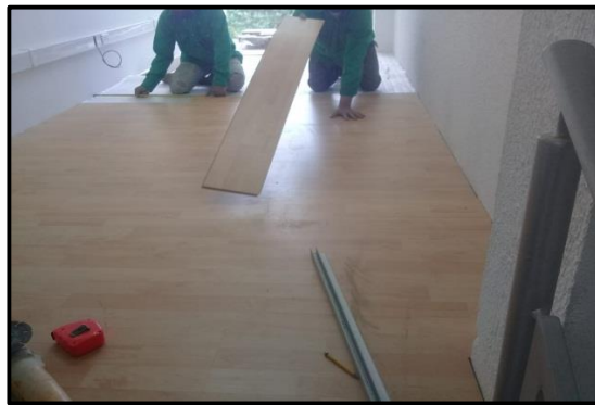
Figura 12. Piso laminado para mezzanine
