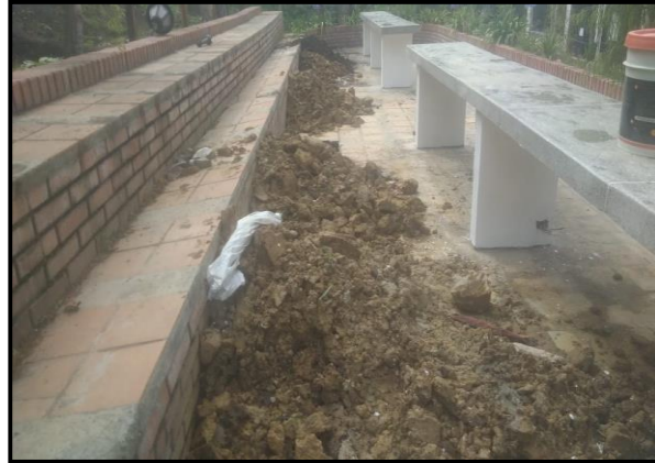
Figura 6. Excavación columnas para cubierta
