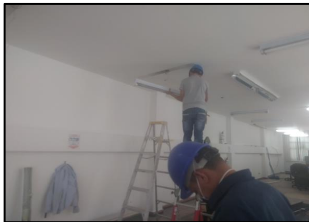
Figura 17. Instalación canaleta y cable UTP
