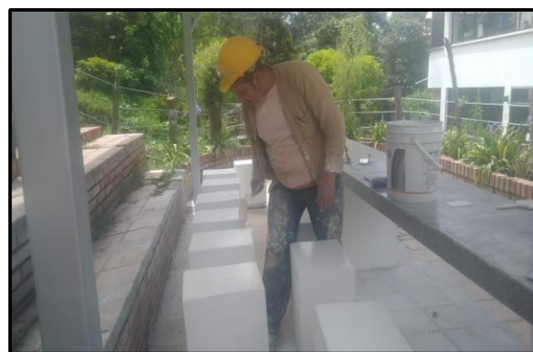
Figura 8. Pintura de soportes
