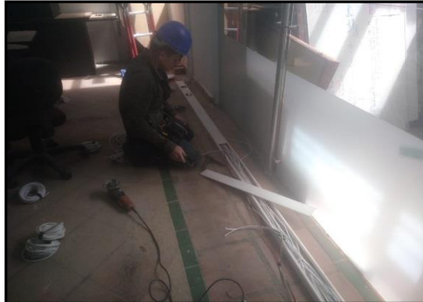
Figura 18. Instalación lámpara led
