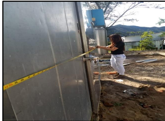
Figura 47. Verificación de dimensiones de los equipos de la planta de lácteos.
