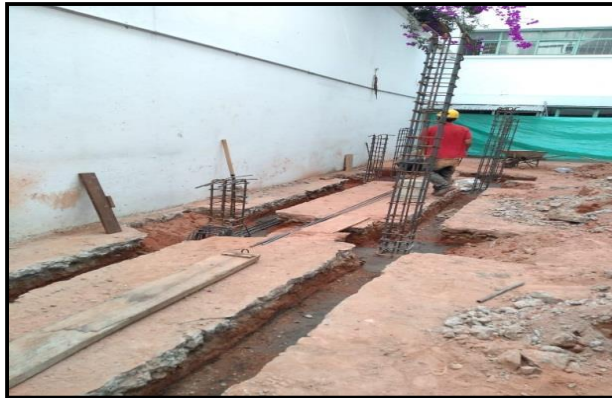
Figura 28. Armado formaleta para rampa
