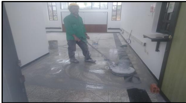
Figura 19. Pulido tableta de granito
