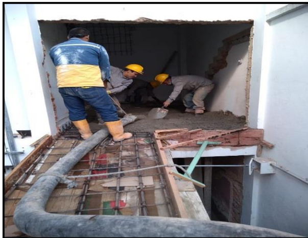
Figura 29. Fundición concreto placa y rampa.
