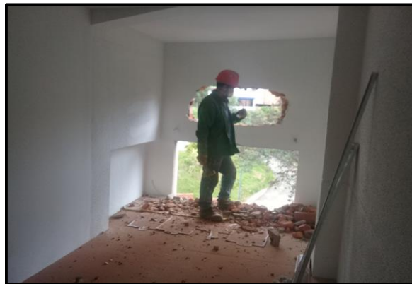
Figura 9. Demolición de mampostería
