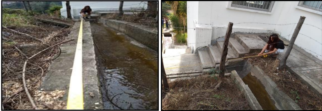
Figura 32. Levantamiento de canal existente
