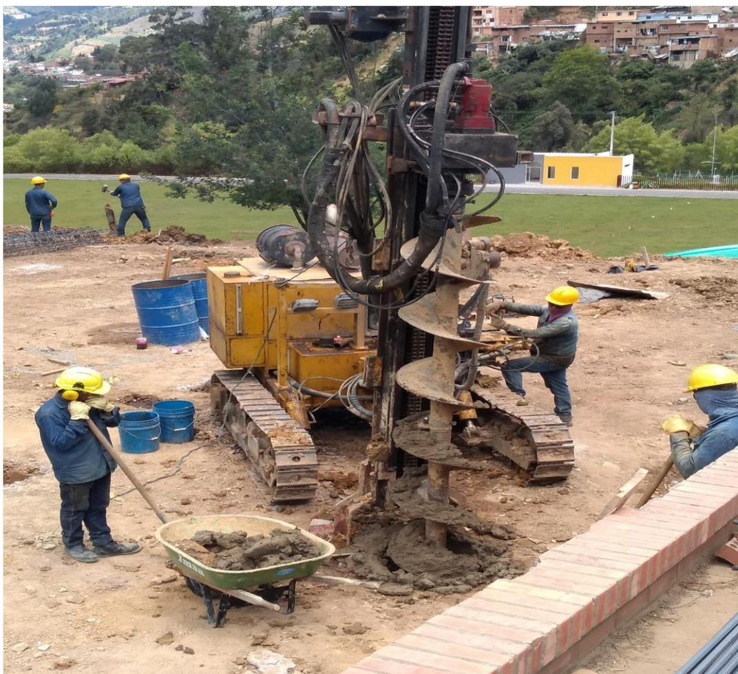
*Ilustración 9: Excavación con máquina perforadora*
