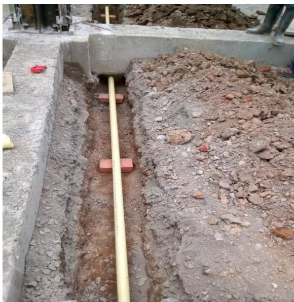
*Ilustración 21: Instalación Sanitaria*
