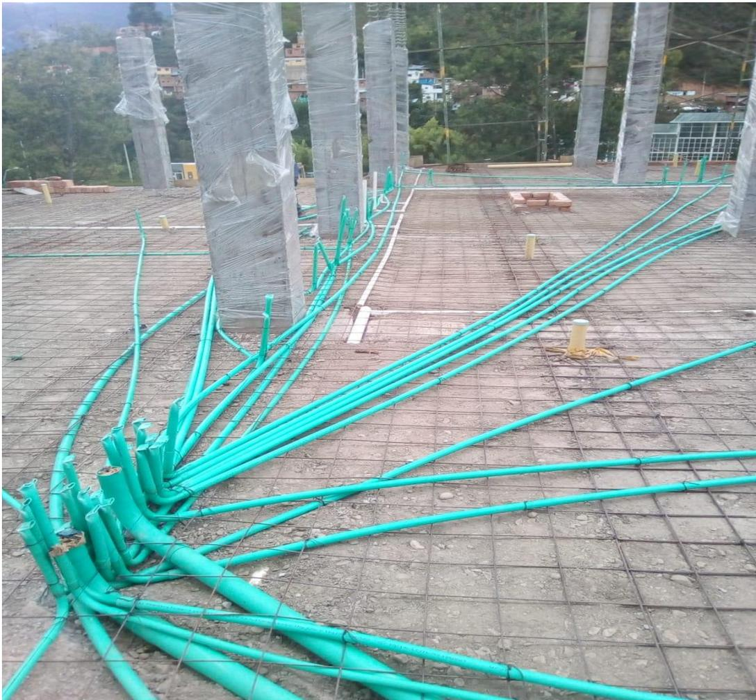
*Ilustración 22: Instalaciones eléctricas por debajo de malla electrosoldada.*
