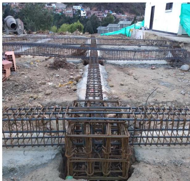
*Ilustración 17: Verificación Acero de Pilotes*
