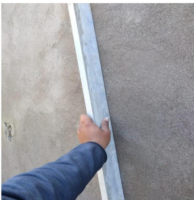
*Ilustración 19: Verificación de la mampostería mediante el uso de codal.*
