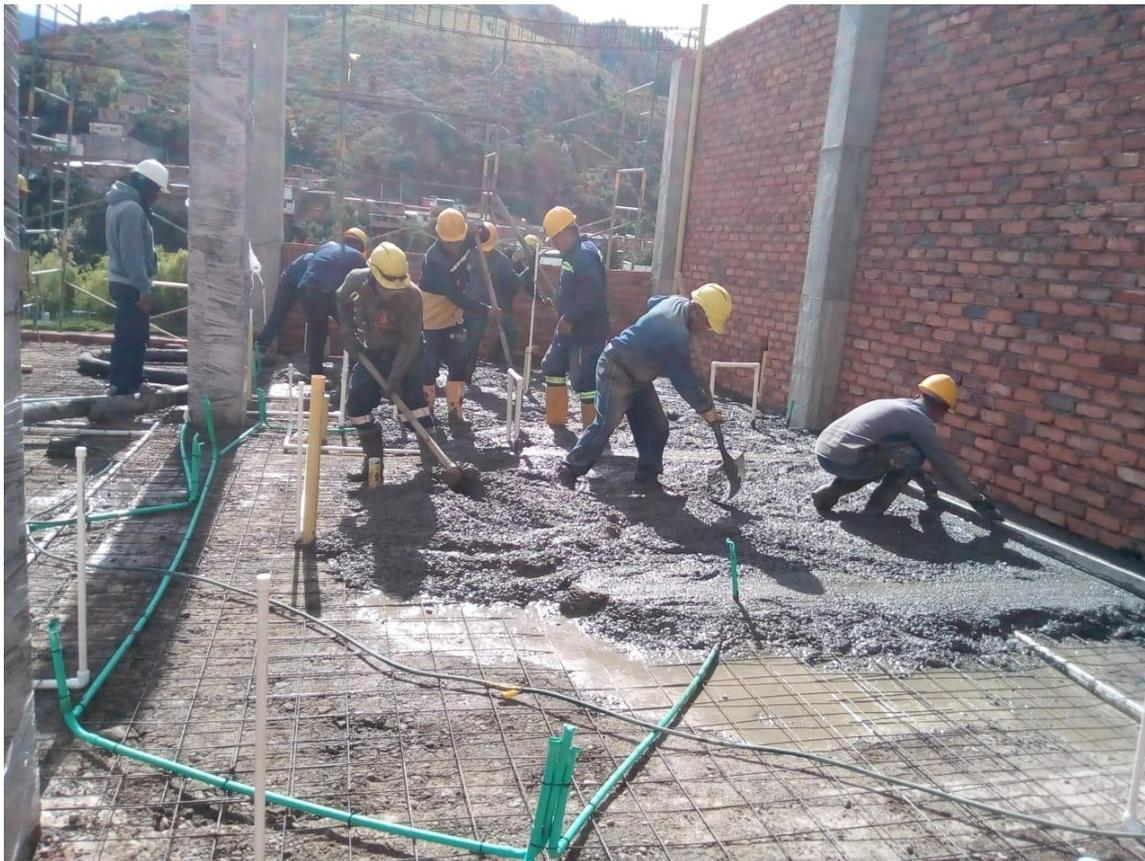
*Ilustración 23: Aplicación concreto piso*
