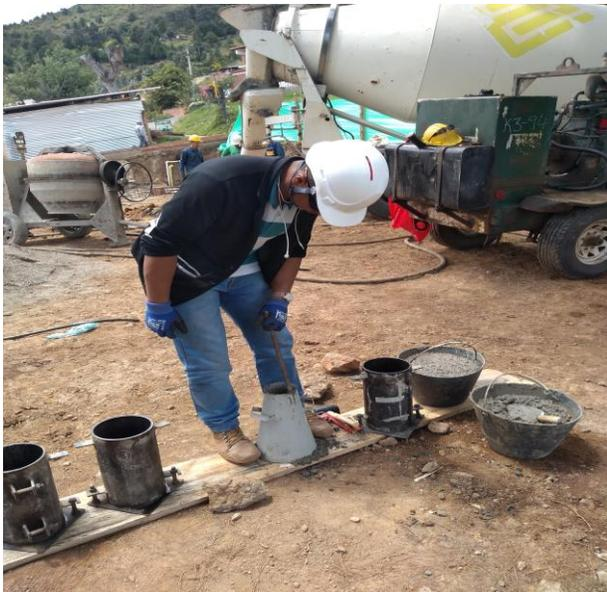
Ilustración 12: Prueba de asentamiento del concreto.
