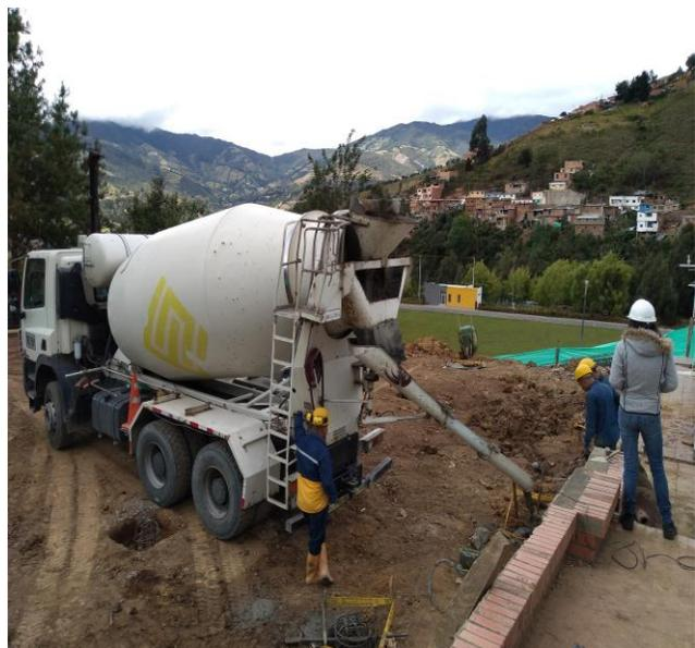
Ilustración 11: Aplicación de concreto premezclado en pilote 8D.
