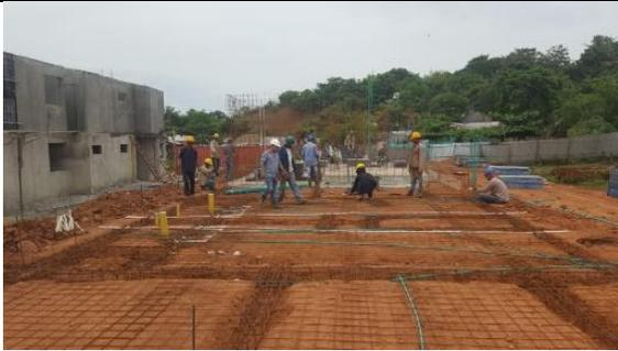
1. Instalación de vigas de cimentación nave e1
