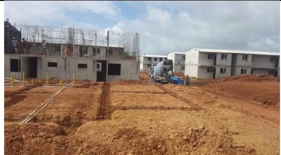
2. Instalación de vigas de cimentación nave e2
