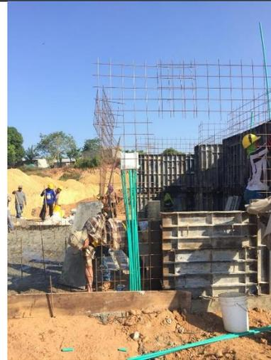
4. Encofrado muros perimetrales
