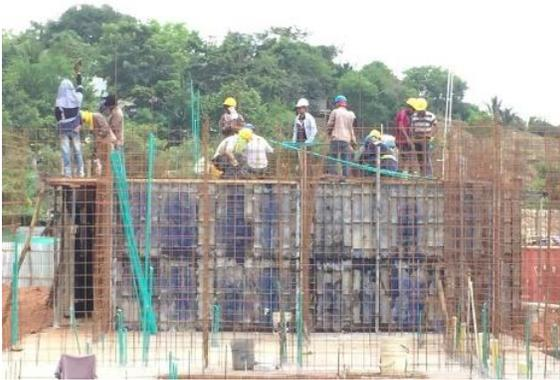
1. Refuerzo muros segundo nivel
